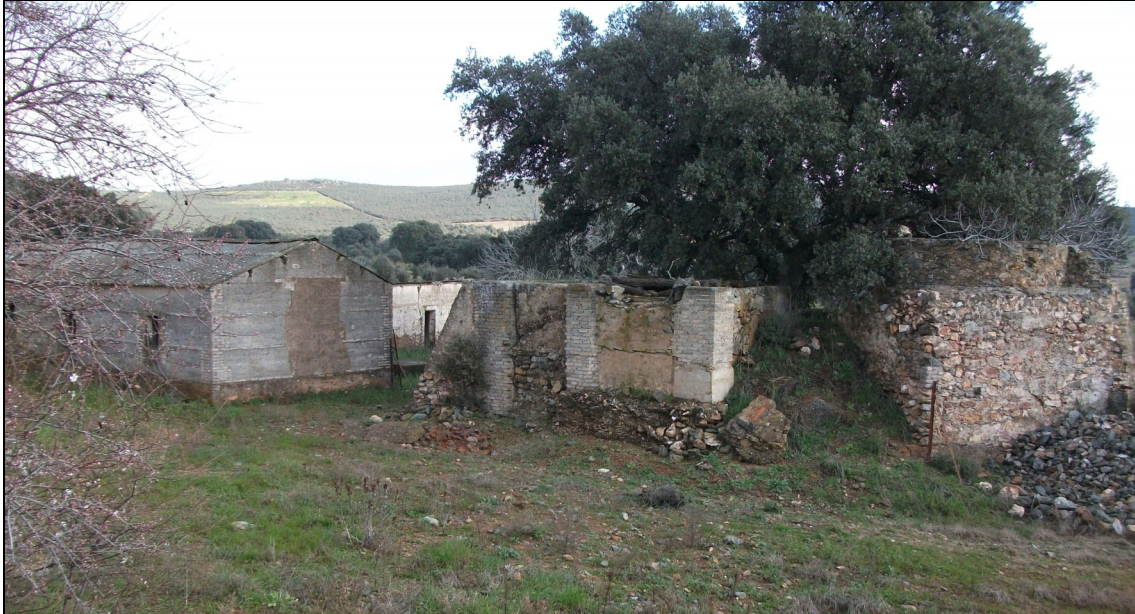
Figura 1: Restos de edificaciones de la mina "La Solución". El pozo maestro, de sección rectangular y completamente despejado, se sitúa en el edificio central de la imagen. Fotografía: Francisco Javier Costa Ripoll (2011).
