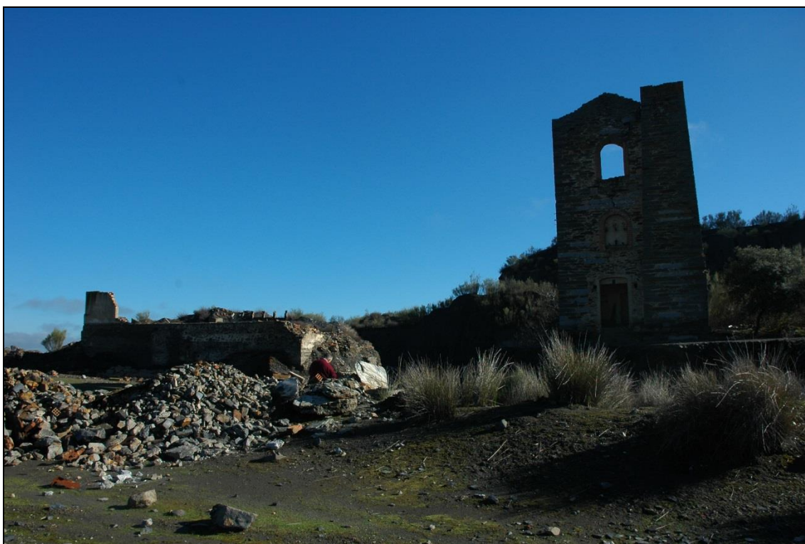
Figura 3: Vista de una zona de la mina "Terreras". A la derecha, la casa de bombeo tipo "Cornish" del Pozo "Arellano", uno de los pozos maestros. A la izquierda, las ruinas de lo que fue el lavadero. Al fondo, detrás de la casa "Cornish", se aprecia la altura que alcanzan los finos de lavado del mineral. A la izquierda también, pero en primer término, pueden verse algunos escombros, entre los que es posible recoger muestras de mineral.
