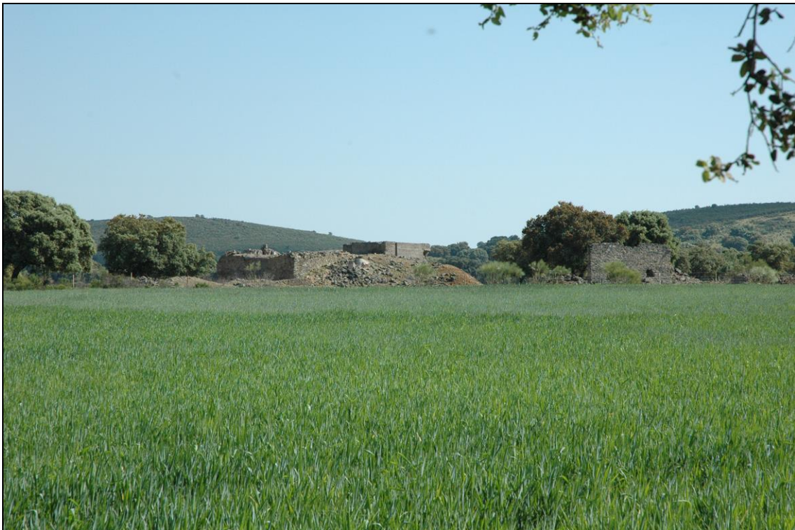
Figura 73: Vista trasera del pozo "Manuela" (izqda.) y de uno de los muros de lo que fue casa de máquinas (dcha.). Fot. I. Ramos, 2011.
