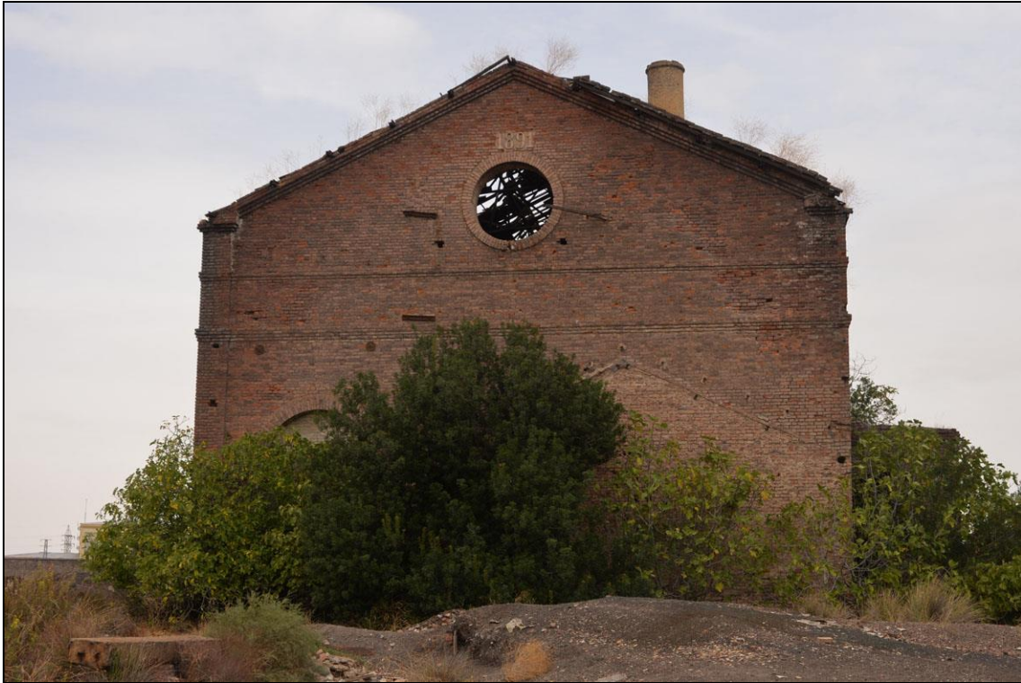
Figura 108: Lateral de la Fundición, donde aún puede leerse el año, 1891, en el que entró en producción el horno de fusión pequeño. Fot. I. Ramos, 2015.
