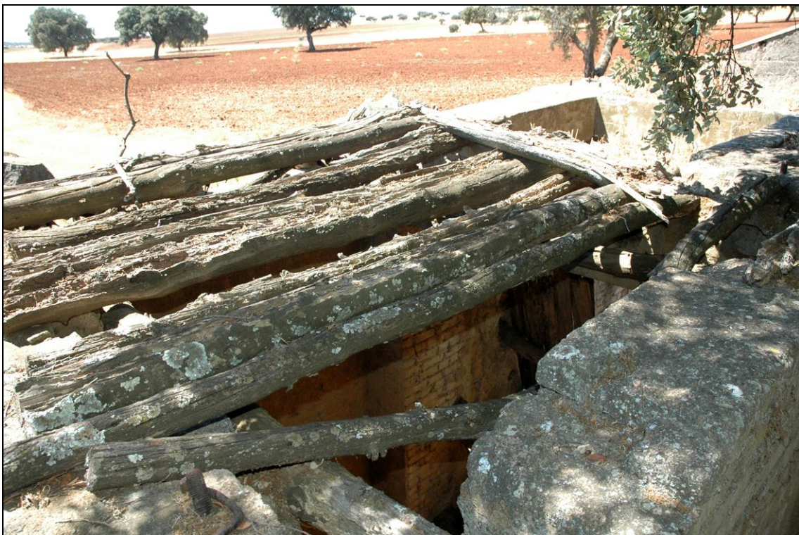
Figura 97: Vista superior del pozo, protegido con maderos para evitar caídas. Fot. A. Carmona, 2011.
