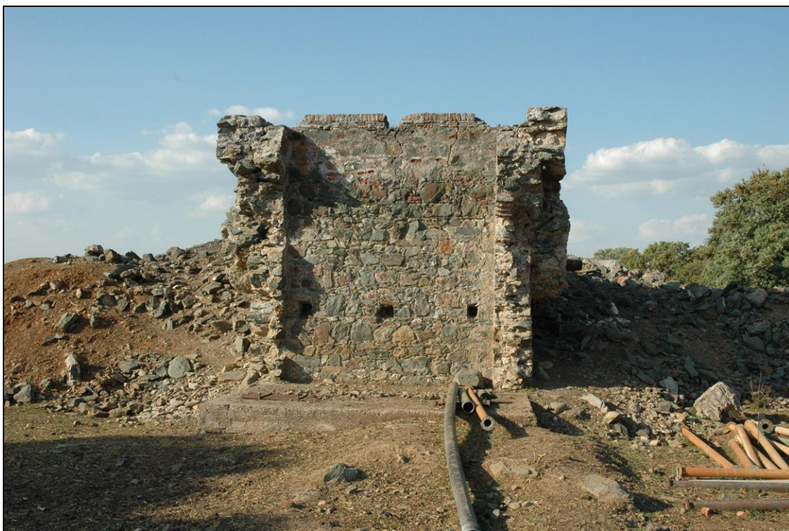
Figura 69: Otra vista de los restos del pozo "Manuela". Fot. I. Ramos, 2011.
