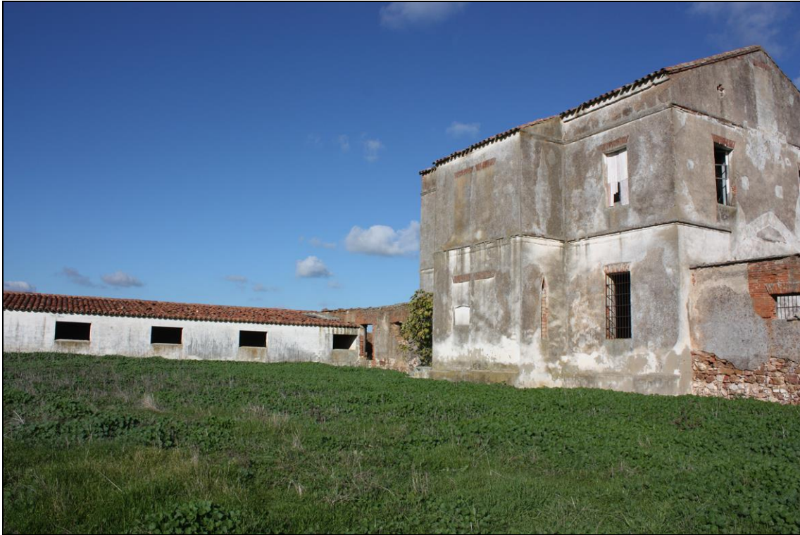
Figura 104: Patio interior del Cortijo de la Fundición y, a doble altura, parte trasera de la vivienda del Jefe de la Fundición. Fot. I. Ramos, 2016.
