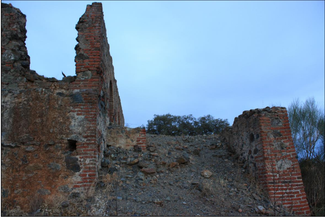
Figura 88: Lateral oeste del lavadero. Fot. I. Ramos, 2009.
