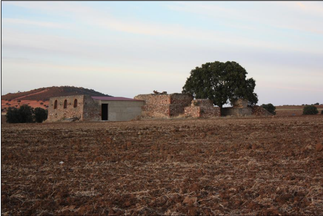
Figura 40: Otra vista de "San Lorenzo". La estructura que une las instalaciones del pozo con las tolvas del lavadero es totalmente nueva (quizá garantice que en un futuro no se venga abajo alguna de las antiguas construcciones que ha unido). Fot. I. Ramos, 2009.
