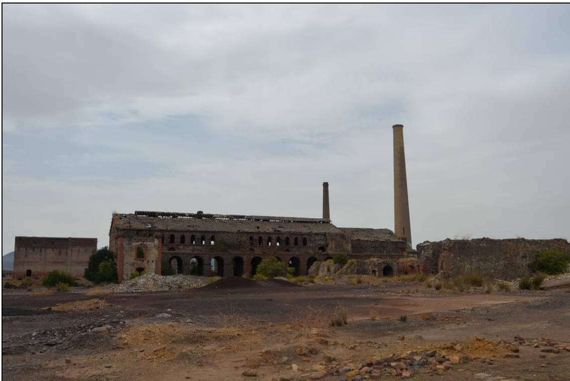
Figura 110: Fachada Noreste de la Fundición de Peñarroya. Fot. I. Ramos, 2015.
