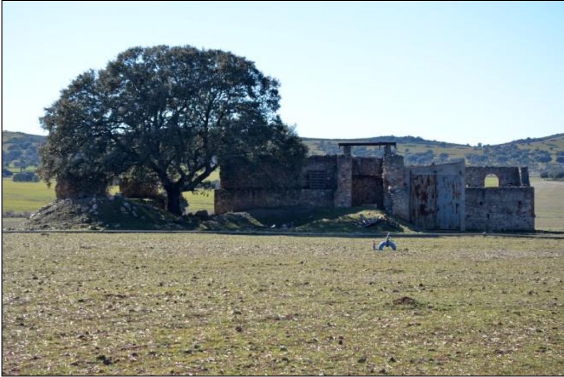
Figura 38: Pozo "Jorgito" e instalaciones anejas. Fot. I. Ramos, 2015.
