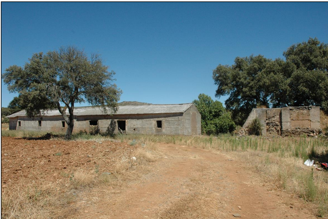
Figura 95: Pozo de la mina a la derecha de la imagen y edificación (izqda.) que albergaría la maquinaria de extracción, porque aparece tapiado un gran hueco en el lateral que da al pozo. Fot. I. Ramos, 2011.
