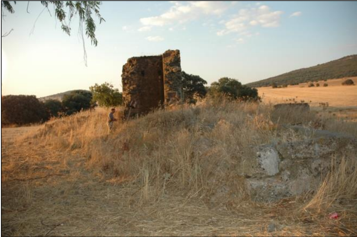
Figura 26: Restos del pozo "Julio". Fot. I. Ramos, 2010.
