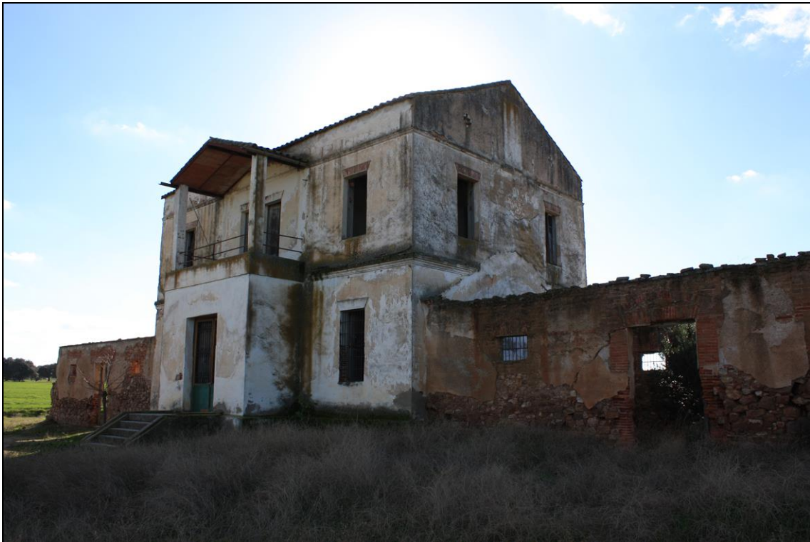
Figura 102: Cortijo de la Fundición. La zona encalada y de doble altura se corresponde con la vivienda del Jefe o Director de la Fundición. Fot. A. Carmona, 2016.
