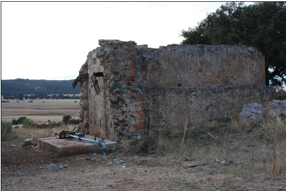
Figura 78: Ruinas del pozo "Radium". Fot. I. Ramos, 2009.
