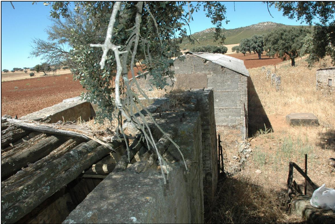
Figura 98: Alineación del pozo con el edificio que pudo ser la casa de máquinas (obsérvese la zona tapiada bajo el tejado). Fot. I. Ramos, 2011.
