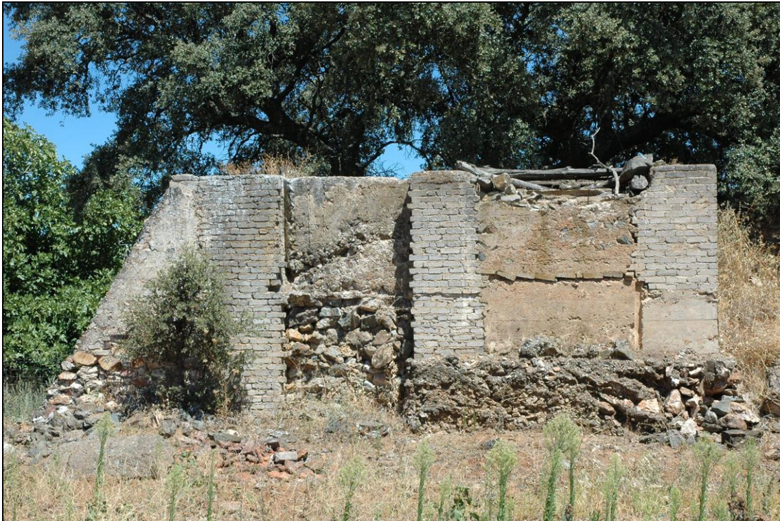
Figura 96: Vista lateral del pozo de extracción. Fot. I. Ramos, 2011.
