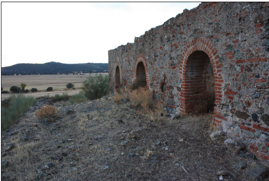
Figura 87: Otra vista del lavadero. Fot. I. Ramos, 2009.
