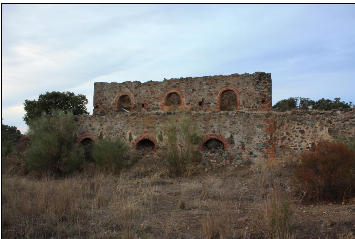
Figura 85: Vista frontal de las tolvas del lavadero. Fot. I. Ramos, 2009.
