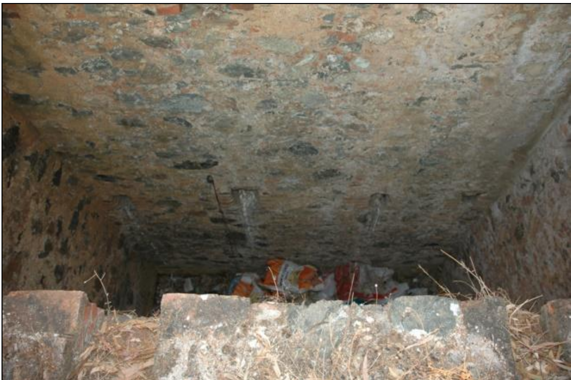
Figura 27: Interior mamposteado del pozo "Julio", bien repleto de basura. Fot. I. Ramos, 2010.
