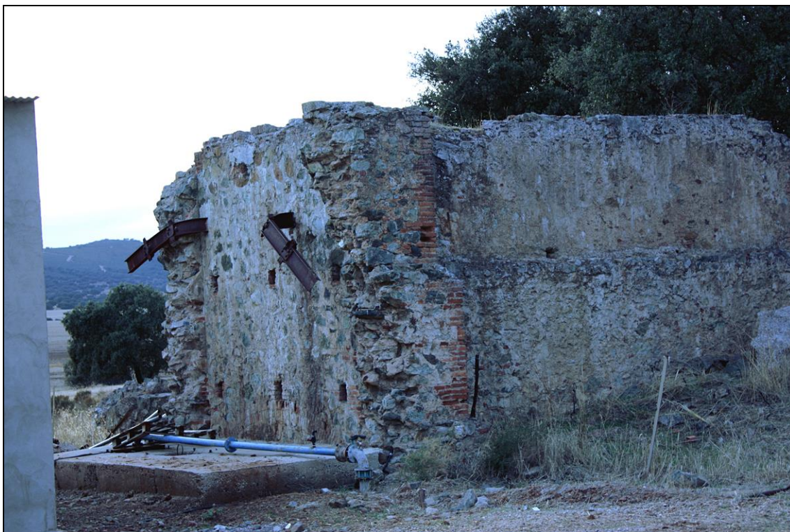
Figura 82: Otra vista del pozo "Radium", actualmente inundado y aprovechado para riego. Fot. I. Ramos, 2009.
