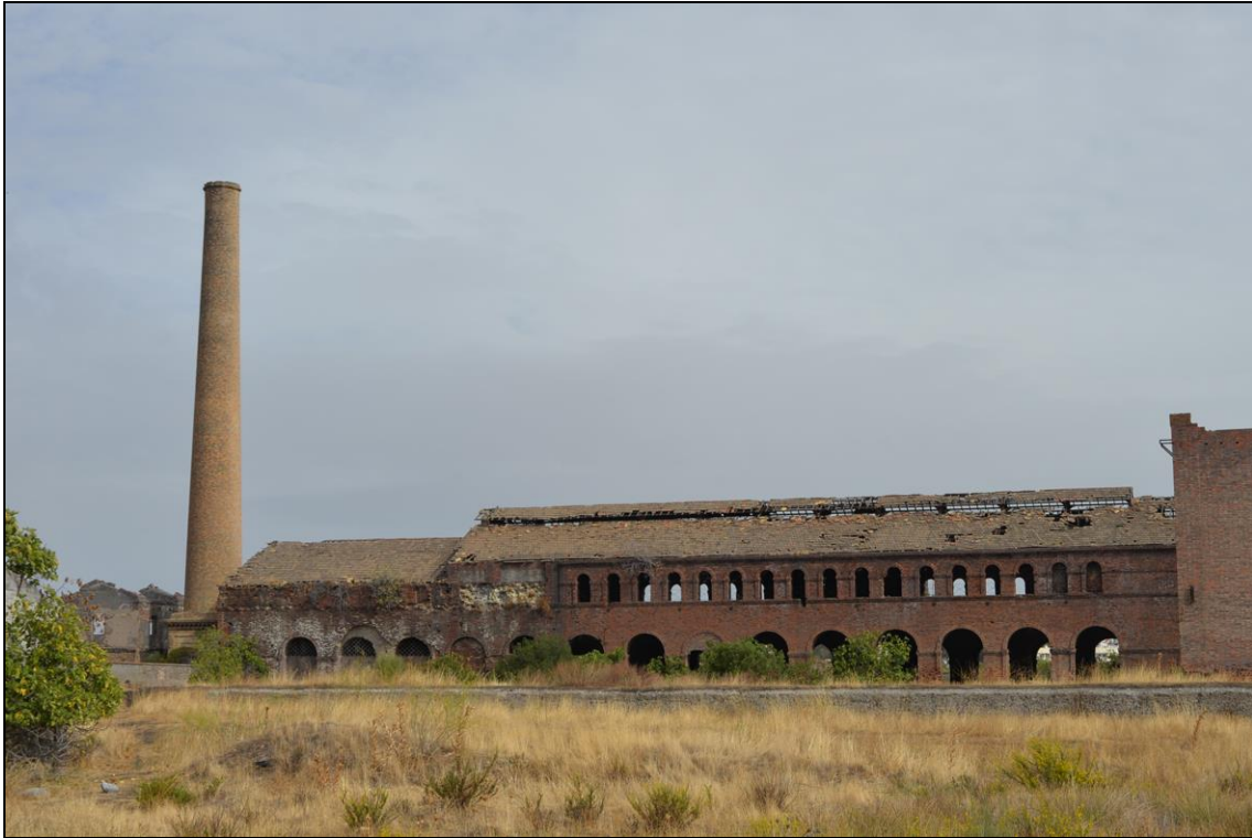
Figura 109: Fachada de la Fundición de Peñarroya que mira hacia el Suroeste. Fot. I. Ramos, 2015.
