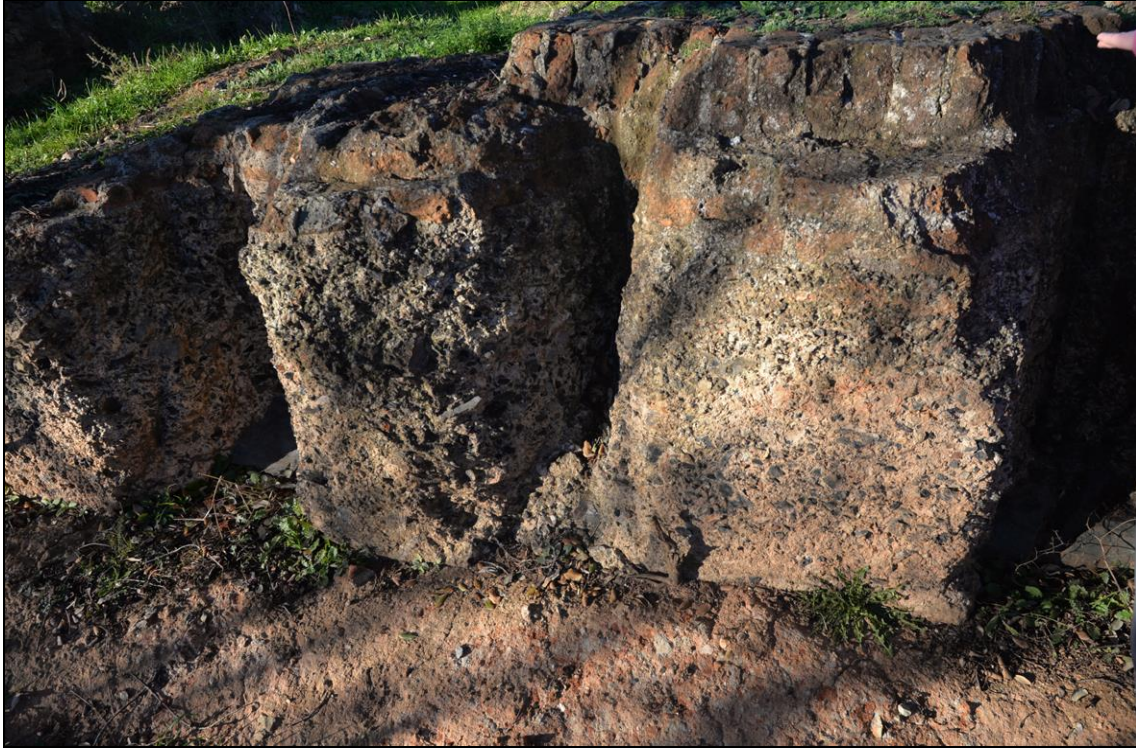
Figura 46: Detalle de la cimentación anterior, realizada en hormigón de carbonilla y ladrillo. Fot. I. Ramos, 2015.
