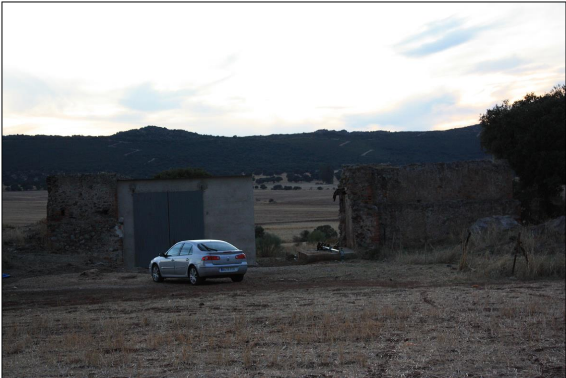
Figura 89: Pozo "Radium", a la derecha de la imagen, construcción moderna en el centro y vista lateral de las tolvas del lavadero. Fot. I. Ramos, 2009.
