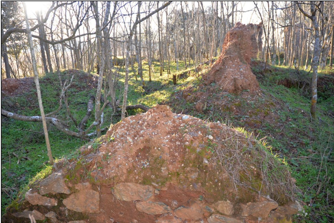
Figura 54: Uno de los edificios en ruinas que pueden encontrarse en "Descuido". Fot. I. Ramos, 2015.
