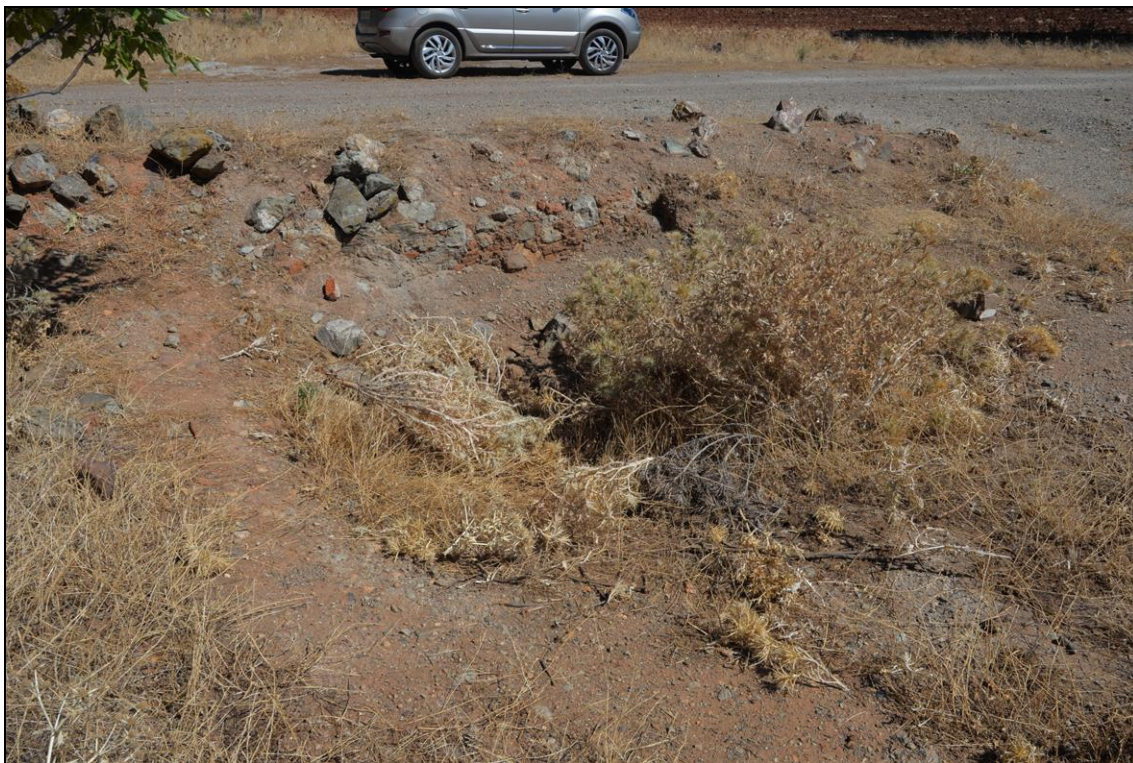
Figura 50: Mínimos restos de lo que pudo ser el pozo N° 1, también llamando "Jabalí", junto al camino, y de fábrica de mampostería y ladrillo. Fot. I. Ramos, 2015.
