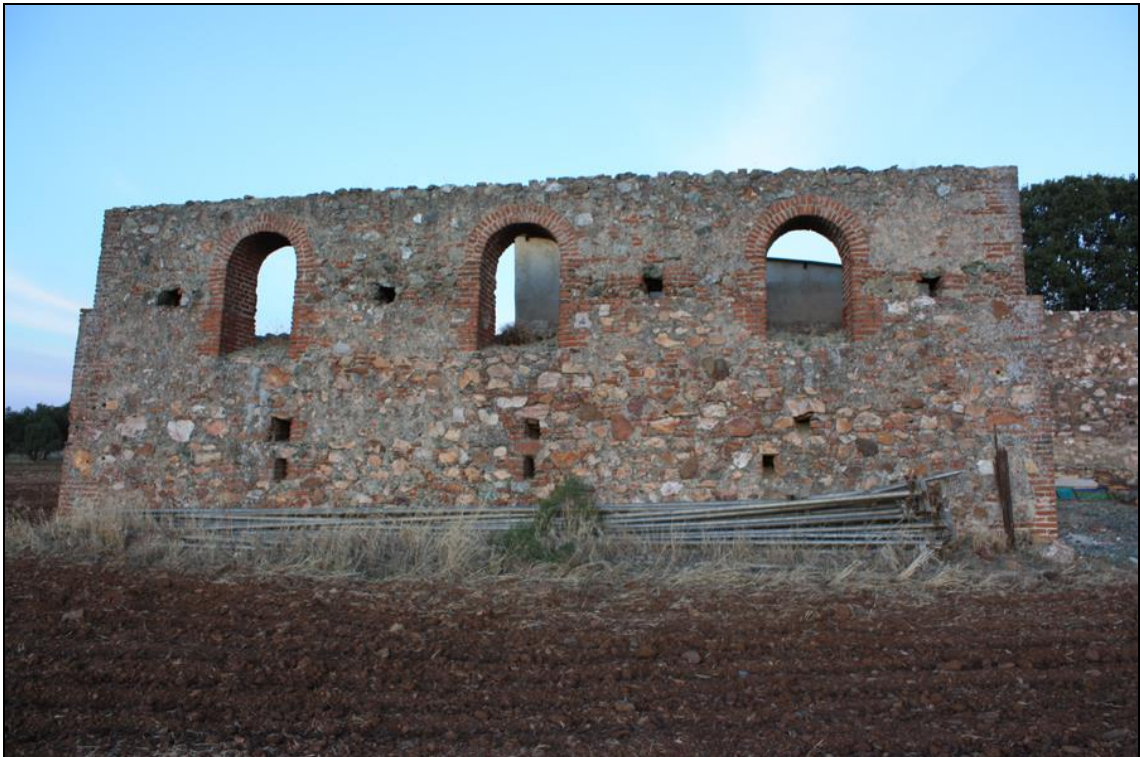
Figura 37: Tolvas del lavadero de la mina "San Lorenzo", de idéntica factura a las de la mina "El Complemento". Fot. I. Ramos, 2009.
