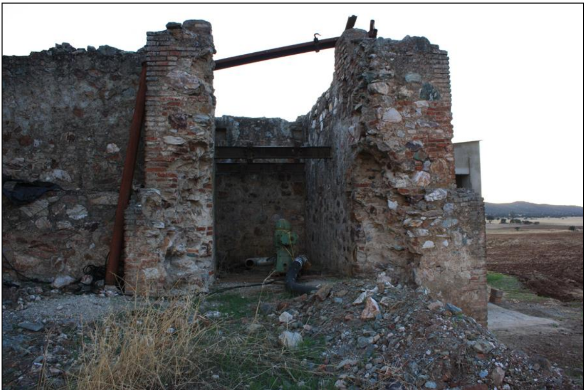
Figura 39: Restos del pozo "Jorgito", sobre el cual se halla instalada una bomba para el riego. Fot. I. Ramos, 2009.
