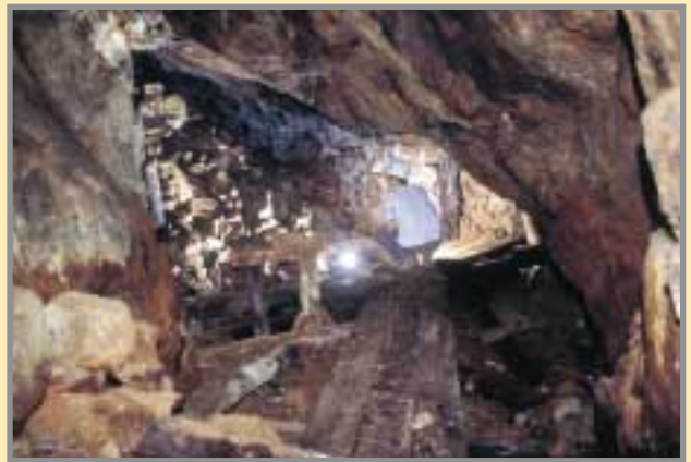
Perspectiva de la galería de arrastre del tercer nivel, que tiene acceso por una bocamina por la que también desaguan las labores. Foto: L. Jordá, 2003.
