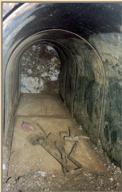
En el frente del túnel aparecían bolos de barita que no cabían por el ancho y era preciso triturar. Foto: J. Peña.
