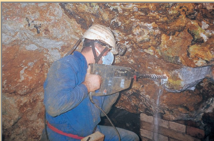
Dando taladros en el filón de barita para localizar geodas de piromorfita. Se trata de los primeros trabajos que conducirían al hallazgo de la geoda "del Túnel", en noviembre de 1998. Véase la llave de madera sobre la que se calzó la masa del filón. Foto: J. Peña.
