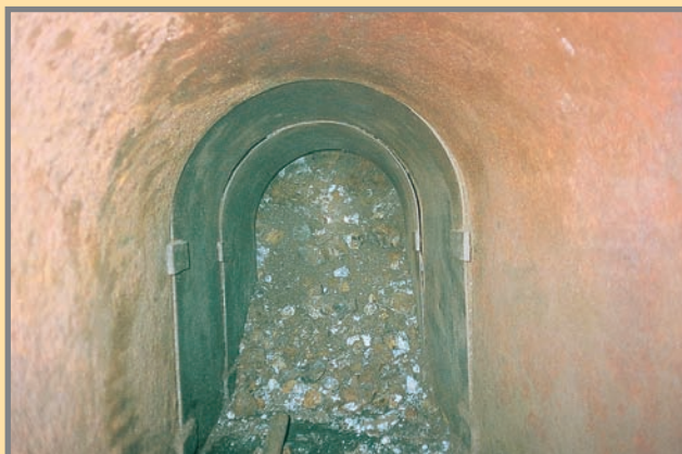
Aspecto suelto de tierras de relleno en el frente del túnel. Foto: M. Séneca, 9/1998.
