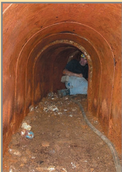
El túnel tuvo un recorrido de 7 metros. En la foto se aprecia el giro del mismo y el retraso de los tramos pequeños para girar. Foto: J. Peña, 2006.
