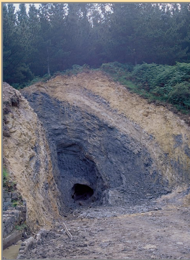
Antiguo socavón de la Plaza del Monte, cuando intentó ser recuperado como acceso. Véase la cuneta lateral de desagüe. Actualmente está hundido, ya que este material requiere un sostenimiento consistente. Foto: G. García, 8/2000.
