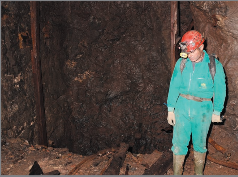
Enganche del 2º nivel en La Cuerre, con restos del guionaje de madera de las jaulas. El pozo era de sección rectangular de 3 m x 2,5 m y 167 m de profundidad. Foto: M. Hedrosa.
