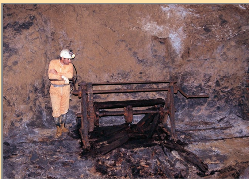
Torno manual de servicio del plano inclinado de Las Ligorias. Foto: M. Hedrosa, 10/1998.
