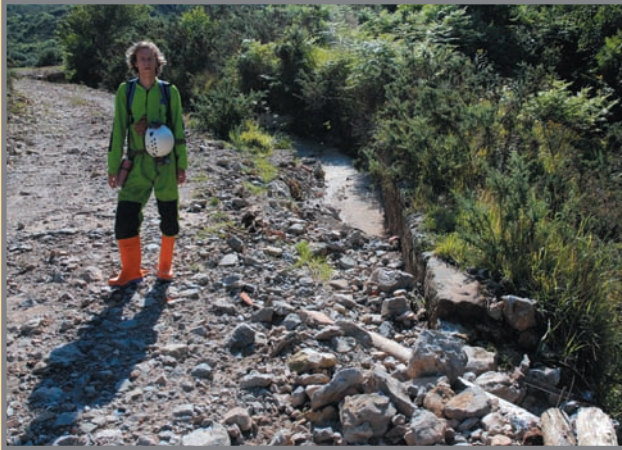
Antigua arqueta de mampostería de desagüe de la mina rota por la pista de aprovechamiento forestal. Foto: M. Hedrosa.
