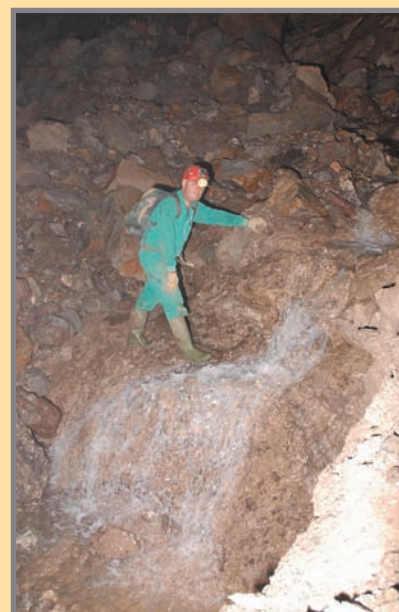
Destrozos del agua entre 2º y 3º nivel, desde donde actualmente se puede ver la luz de la calle por los hundimientos que han afectado a la superficie. Foto: M. Hedrosa.
