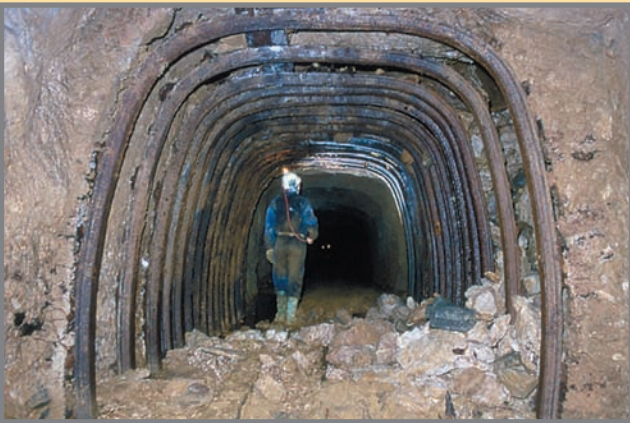
Zona postzada con cerchas metálicas. Foto: Cortesía de J. Colina.
