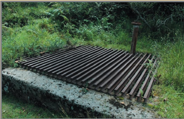
Estado actual del brocal del pozo de entrada de aire comprimido y electricidad de la Plaza del Monte. Foto: A. Bueno, 8/2007.
