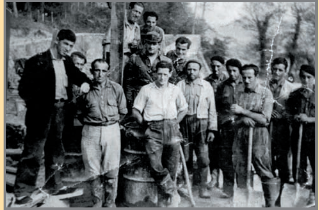
Trabajos de perforación del pozo de servicios de la Plaza del Monte. En principio el pozo quiso hacerse de abajo a arriba, pero los continuos descostres de la marga les hicieron desistir y realizarlo en descenso, con encofrados y hormigonados constantes. Foto: cortesía de Ramón Reigadas, vigilante general, a la izqda. de la foto.
