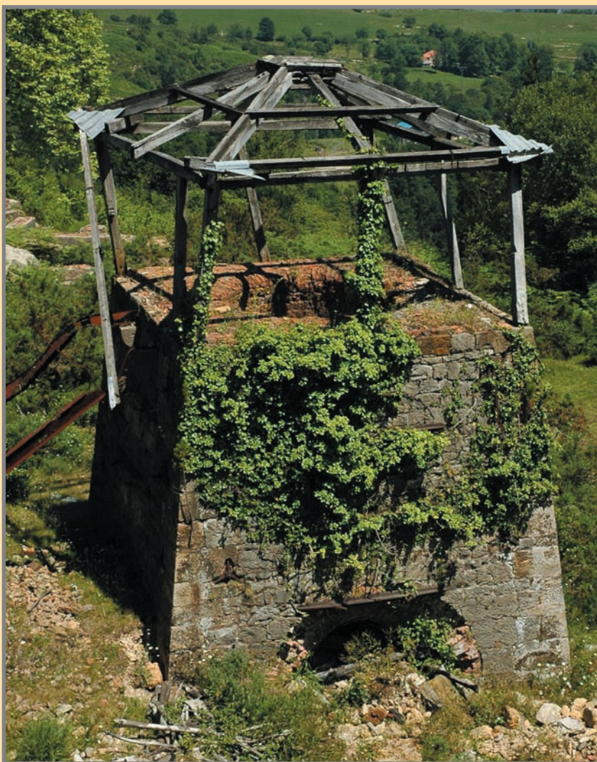
Horno de calaminas de la Plaza del Monte, uno de los elementos patrimoniales más relevantes de La Florida. Sería conveniente destinar algún dinero a la consolidación de la corona de madera, antes de que se desplome. Foto: G. García, 7/2007.
