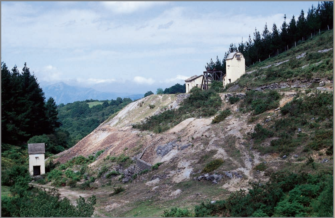
Instalaciones de superficie sobre el extremo occidental de La Florida. Se observa el castillete del Pozo La Curre con su casa de máquinas y su transformador. Debajo, la mampostería de la tolva de descarga y un segundo transformador, que suponemos alimentaba la máquina del cable aéreo o línea de baldes que transportaba el mineral hasta la Plaza del Monte y Cereceo. Los pinares del entorno han sido talados y el ensanche de la pista ha tenido consecuencias negativas para la purga natural de las aguas del valle al haber destruido la cuneta original de la mina, provocando su afluencia al interior y el deterioro de las labores subterráneas. Foto: G. García, 8/2000.
