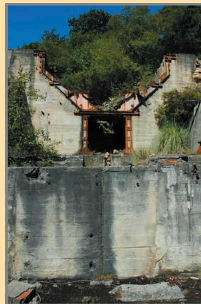
Restos de la tolva de recepción a la entrada del lavadero de Cereceo. Foto: A. Bueno, 8/2007.
