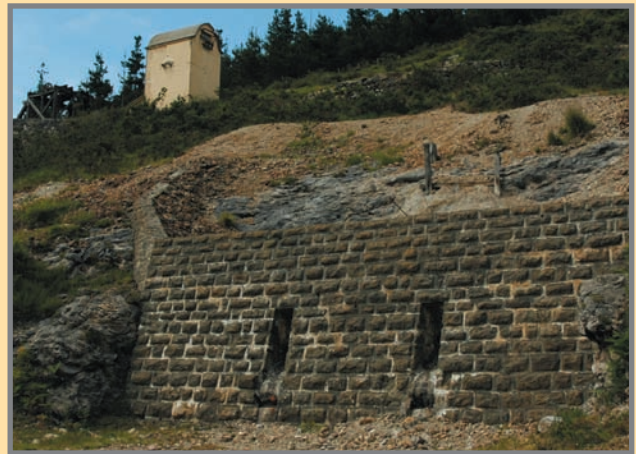
Antigua tolva de descarga del mineral de La Cuerre. Aquí estaba instalado el extremo de la línea de baldes, sobre una plataforma giratoria desaparecida. Foto: A. Bueno, 8/2007.
