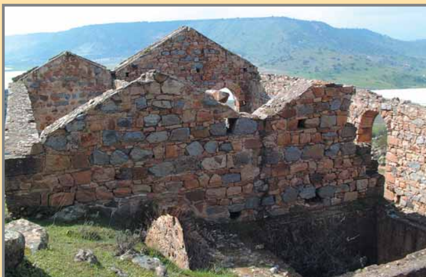
La casa del Pozo "San Andrés" resulta singular en el resto de edificaciones mineras de Linares. Su construcción en ladrillo rojo difiere de la habitual mampostería de arenisca o granito. Foto: A. Bueno, 2008. Inferior: Restos de edificaciones junto al Pozo de La Endrina. Foto: Colectivo Arrayanes.
