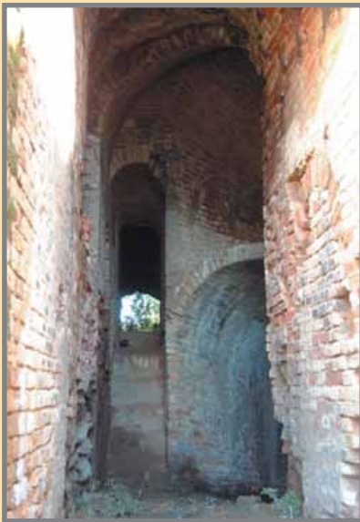
Laberinto de gases en la instalación motriz de vapor del Pozo "San Andrés". Foto: Colectivo Arrayanes.
