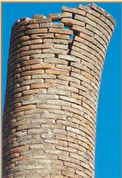
El extremo de la chimenea de "San Pascual" se encuentra agrietado. Foto: J. Peña, 2008.
