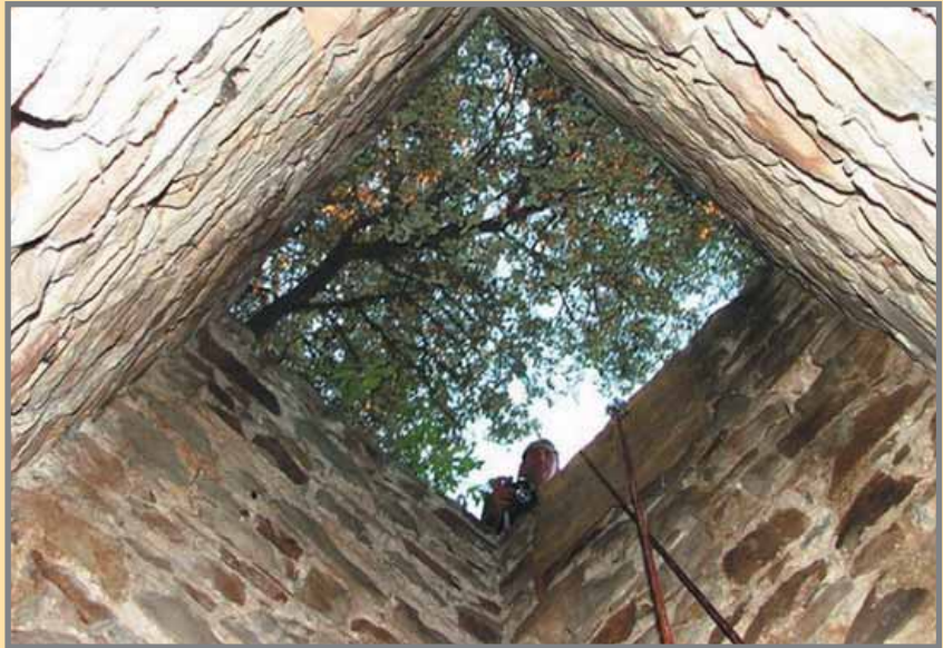
Pozo-respiradero en "San Pascual", de sección cuadrangular e inicialmente forrado de mampostería. En seguida discurre desnudo. Foto: J. Peña, 8/2008.
