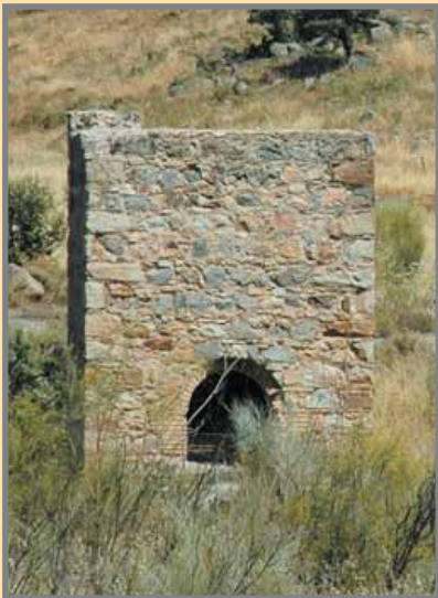
Posible chimenea de ventilación en la línea de los dos pozos "San Andrés", viejo y nuevo. Generalmente llegan sólo hasta la 1ª Planta. Foto: J. Peña, 8/2008.
