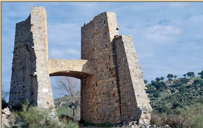
Inferior: Contrafuertes de contención de la escombrera para el tránsito inferior de la pista de acceso. Con la puesta en marcha del lavadero de flotación esta estructura su función, al consumirse buena parte del material. Foto: G. García.
