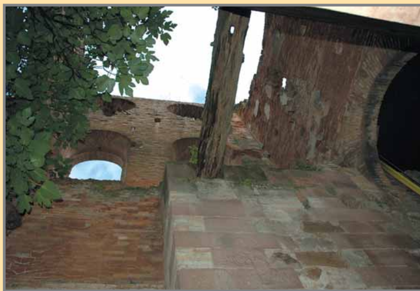
Perspectiva interior de la Casa Bull aneja al Pozo "San Andrés". Obsérvese el refuerzo de sillares de arenisca para la ubicación de la bomba de acción directa. Se conserva un grueso estempe. Foto: A. Bueno, 2008.
