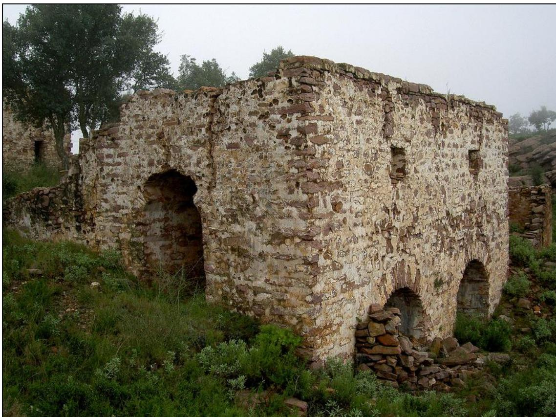
Figura 108: Cámaras de cabecera, con puerta de carga y buitrones (Fot. J.M. Sanchis, 2008)
