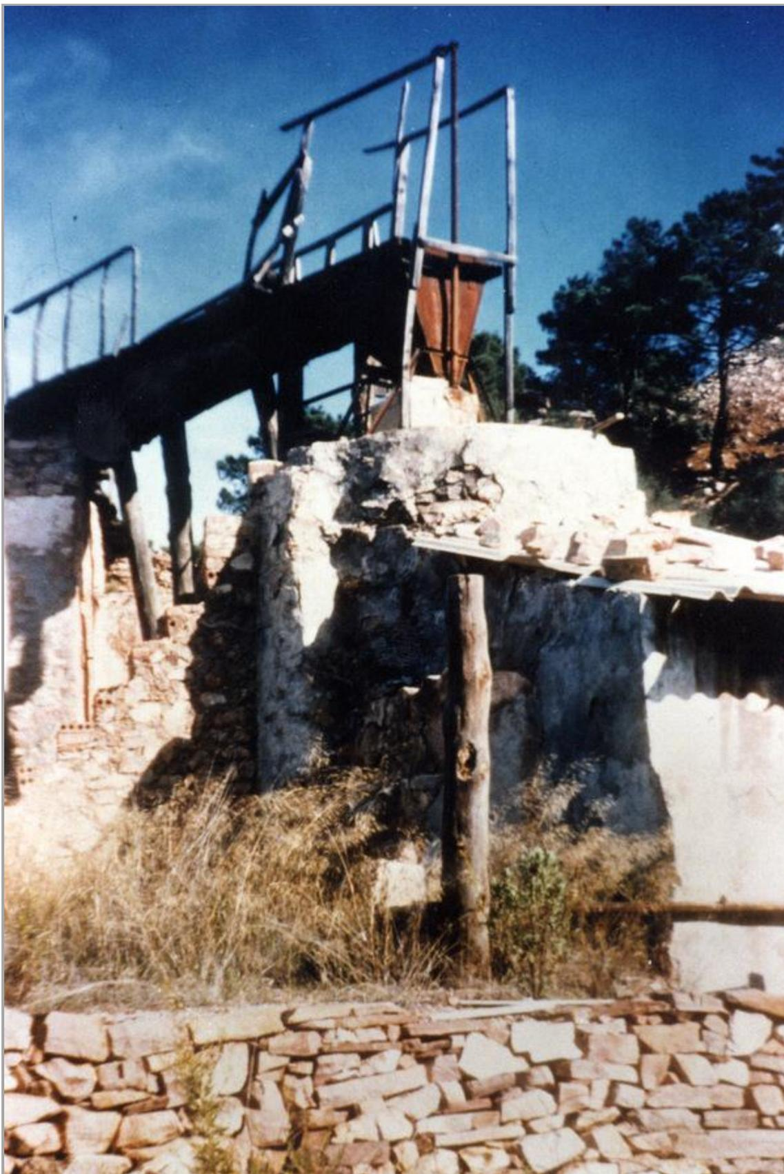
Figura 47: Tolva de alimentación del horno, en 1966 (Arch. J.M. Sanchis)
