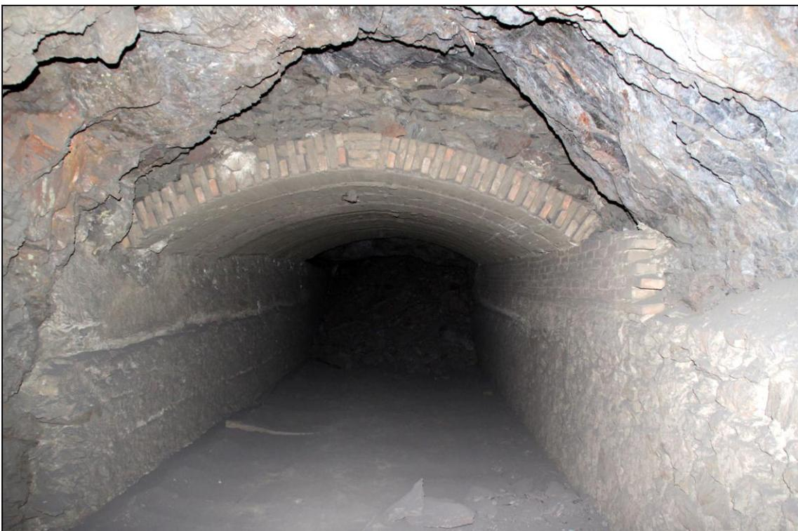
Figura 57: *Tramo del socavón reforzado con techo y muros de hormigón y ladrillo (Fot. J.M. Sanchis, 2011)*
