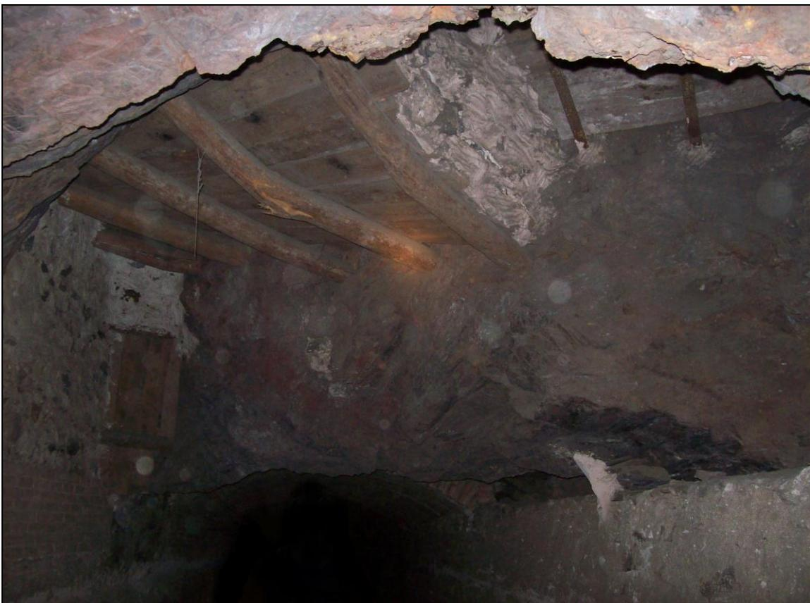
Figura 64: *Punto donde se produjo el hundimiento que colapsó la galería (Fot. A. González, 2010)*
