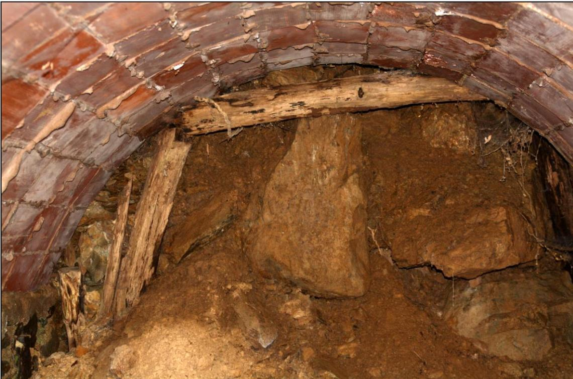
Figura 14: *Galería colapsada con entibado en mina Canta (Fot. J.M. Sanchis, 2011)*
