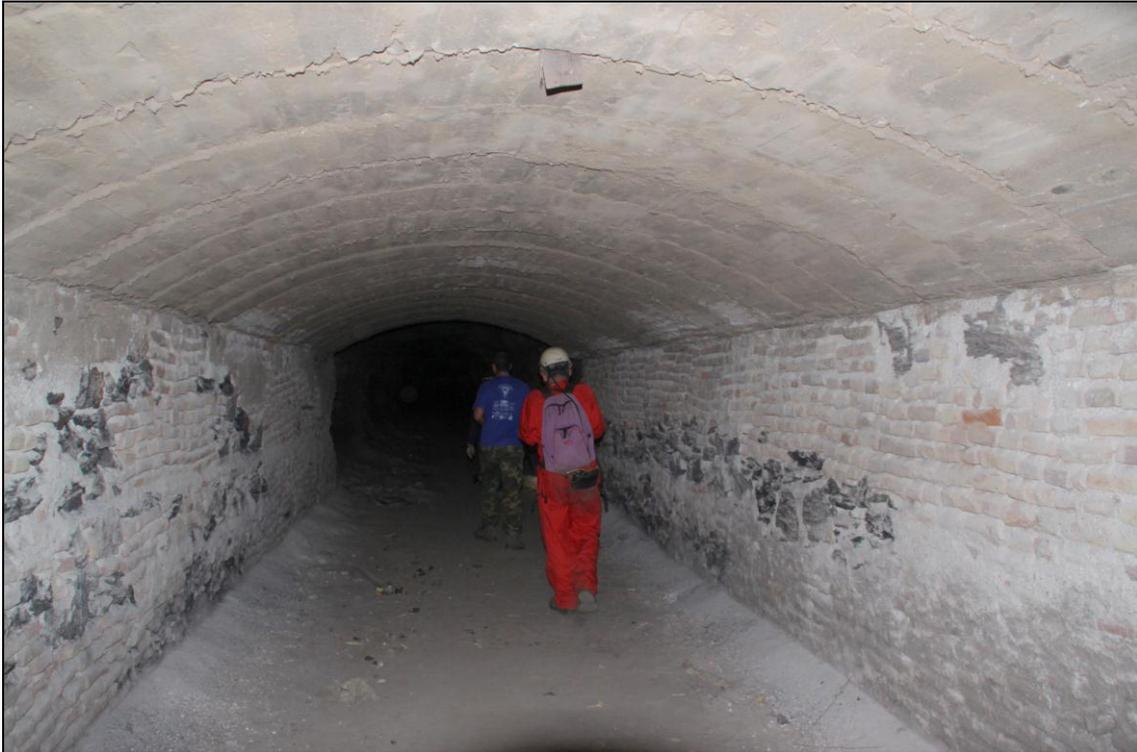
Figura 56: *Inicio del socavón, con techo de hormigón y paredes de ladrillo (Fot. J.M. Sanchis, 2011)*
