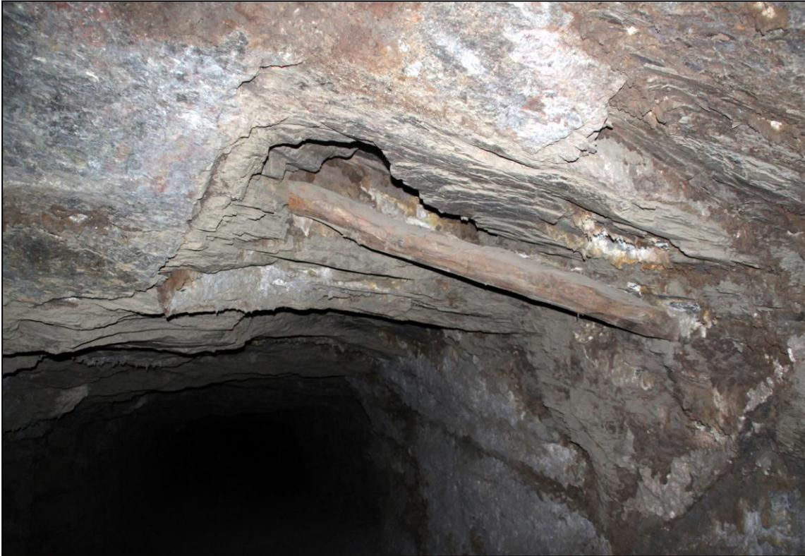
Figura 63: *Entibación de madera en un pequeño tramo (Fot. J.M. Sanchis, 2011)*
