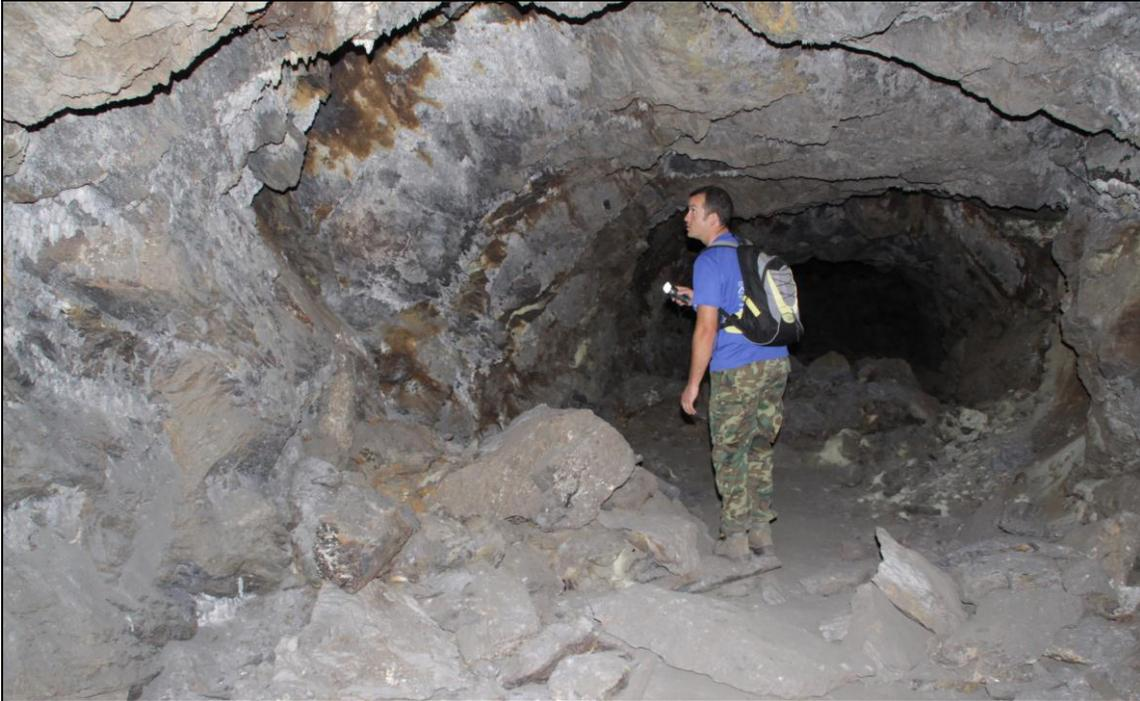
Figura 58: *Hundimientos en la galería (Fot. J.M. Sanchis, 2011)*
