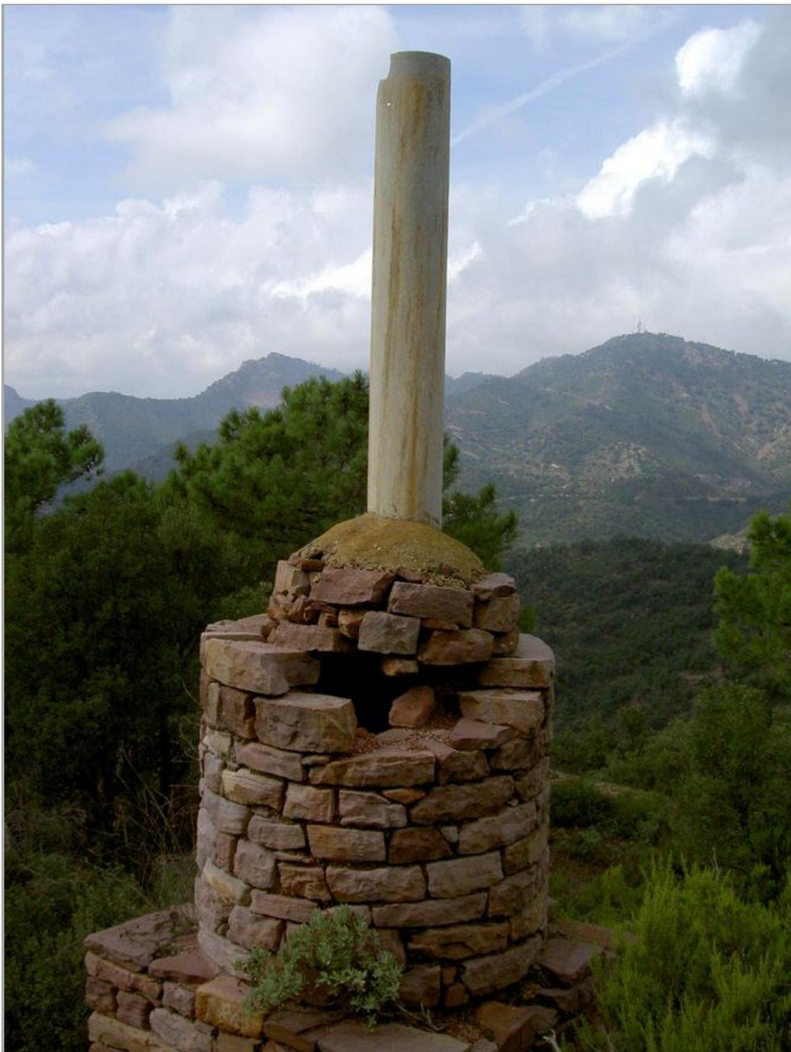
Figura 57: *Chimenea de evacuación de humos (Fot. J.M. Sanchis, 2008)*
