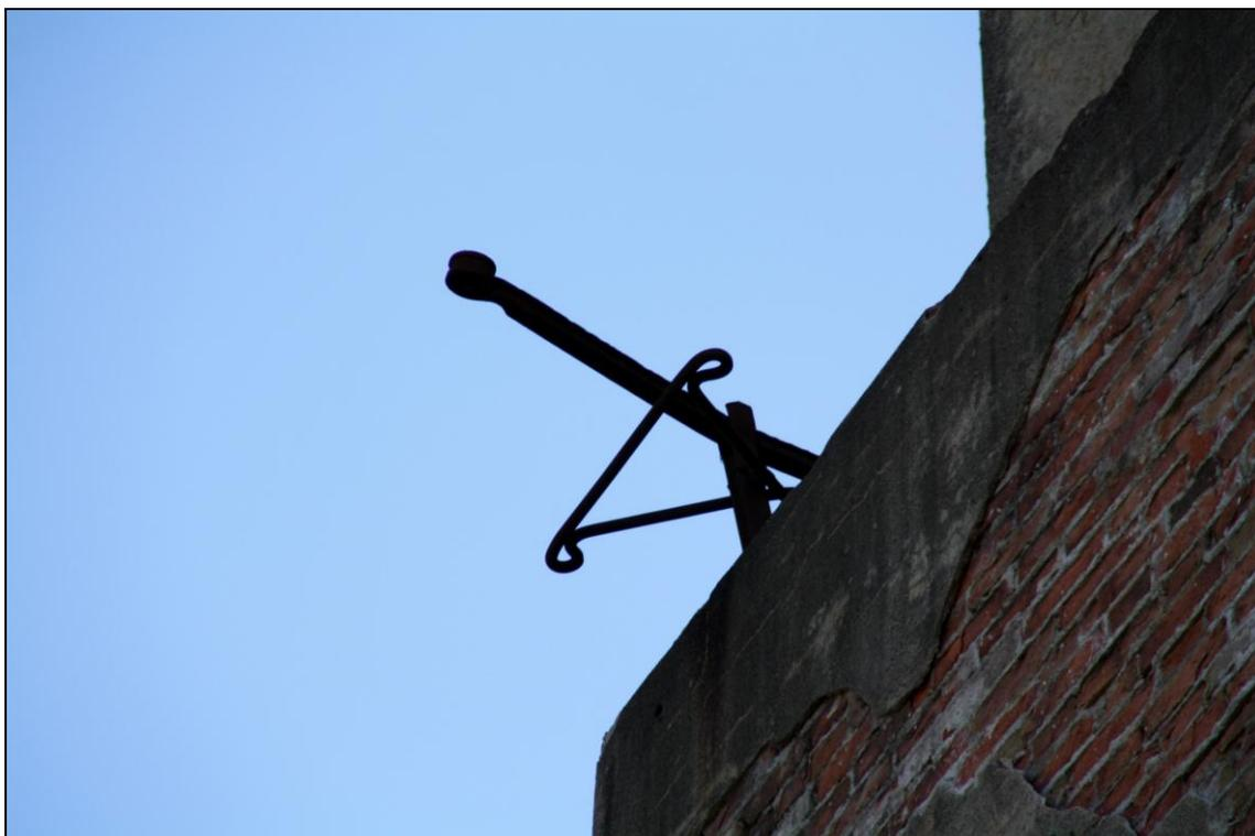
Figura 48: Gancho de sujeción de la red de camuflaje (Fot. J.M. Sanchis, 2011)
