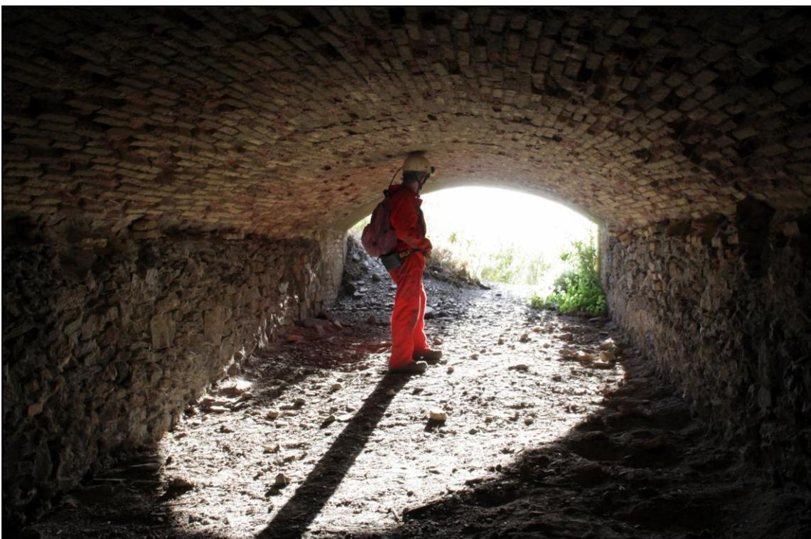
Figura 55: *Emboquille de ladrillo (Fot. J.M. Sanchis, 2011)*
