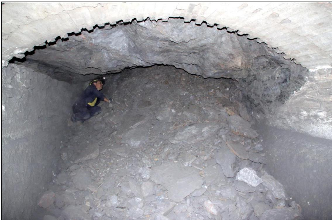
Figura 65: *Hundimiento en la galería (Fot. J.M. Sanchis, 2011)*
