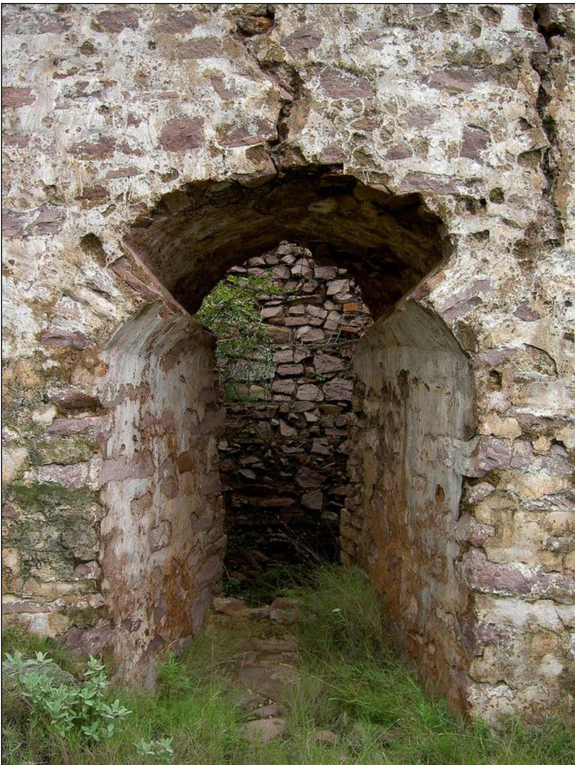
Figura 109: *Puerta de carga de uno de los vasos del horno*
