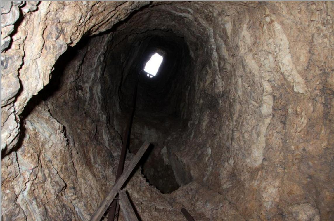
Figura 25: *Chimenea de ventilación en Diana (Fot. J.M. Sanchis, 2008)*
