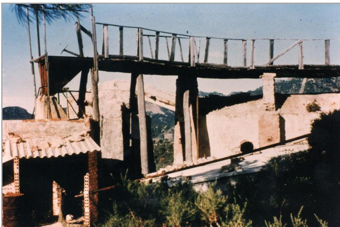
Figura 35: *Puente de vagonetas para carga en tolva del horno, 1966 (Arch. J.M. Sanchis)*
