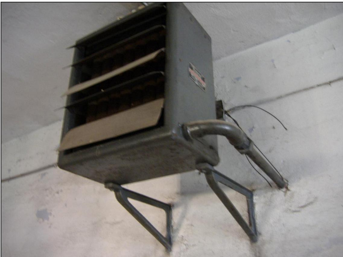
Figura 33: *Calefactor por agua caliente en vestuarios.* (Fot. A. Pizarro, 2004).
