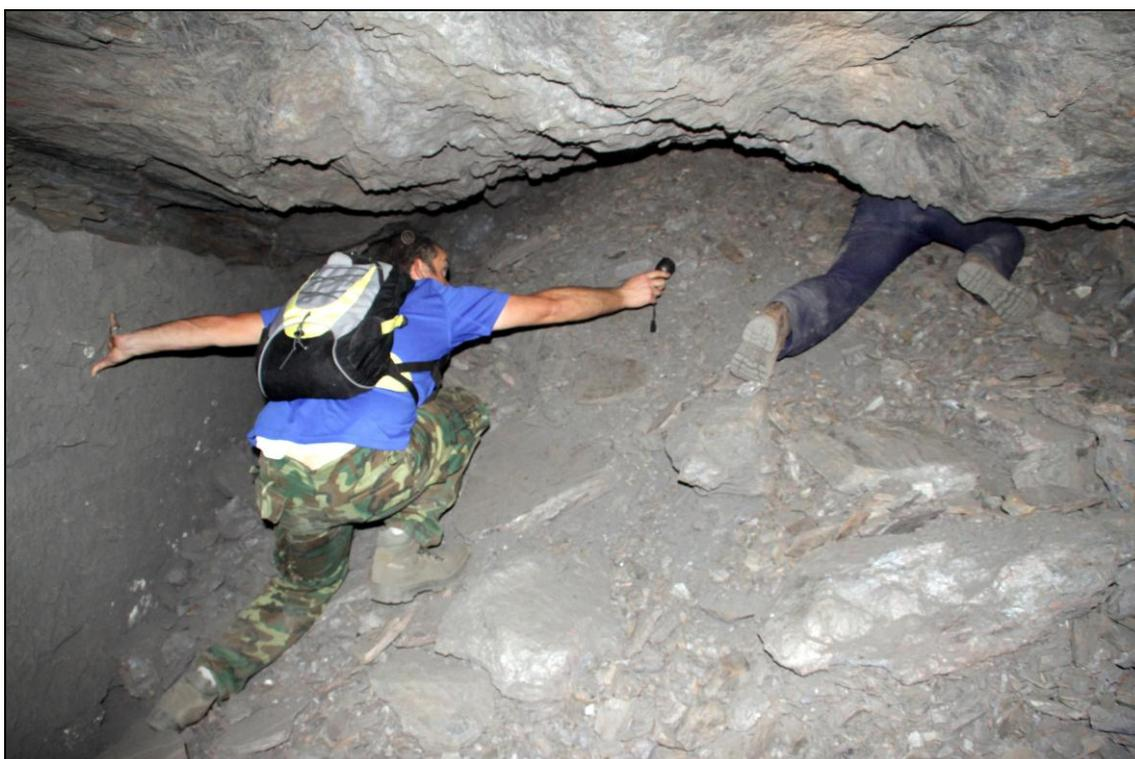
Figura 66: *Colapso por hundimiento en la galería general (Fot. J.M. Sanchis, 2011)*
