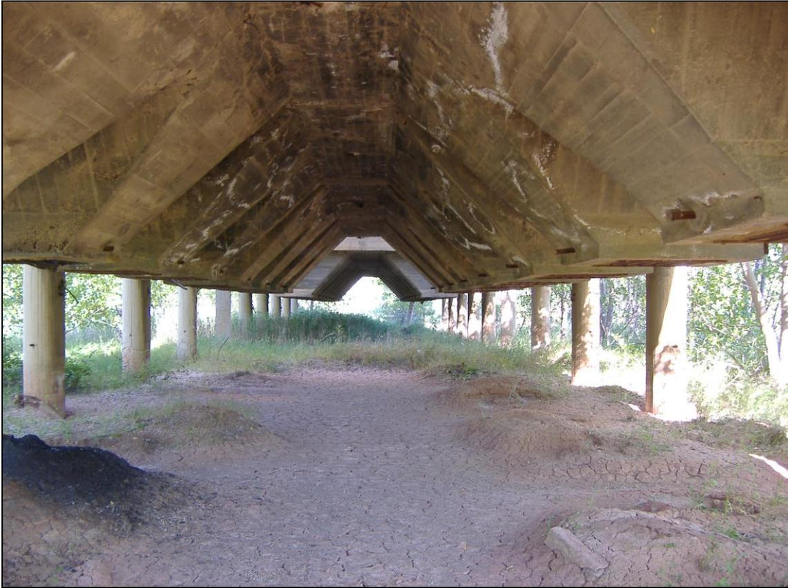
Figura 26: *Parte inferior de la tolva y boquillas de salida, donde se alojaban los vagones del tren minero. (Fot. A. Pizarro, 2004).*
