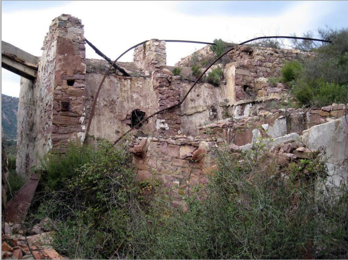
Figura 52: Los hornos, en ruinas, con el tendido de vías caído (Fot. J.M. Sanchis, 2008)
