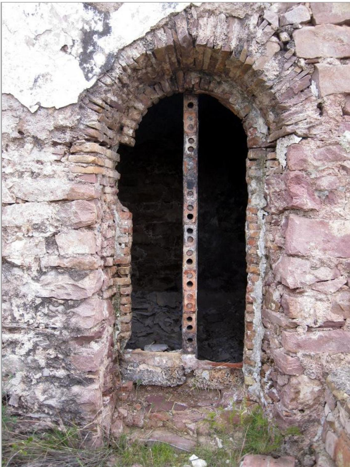
Figura 50: *Detalle de una boca de carga (Fot. J.M. Sanchis, 2008)*
