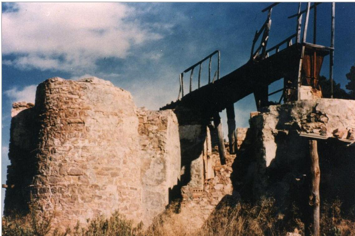
Figura 34: *Puente de vagonetas para carga en tolva del horno, 1966 (Arch. J.M. Sanchis)*
