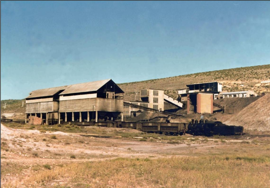
Figura 13: *Conjunto de instalaciones de mina Andorrana, sin actividad, solo funcionando tolva recogiendo el carbones del Val de Ariño (Fot. Archivo Celan, 1975).*
