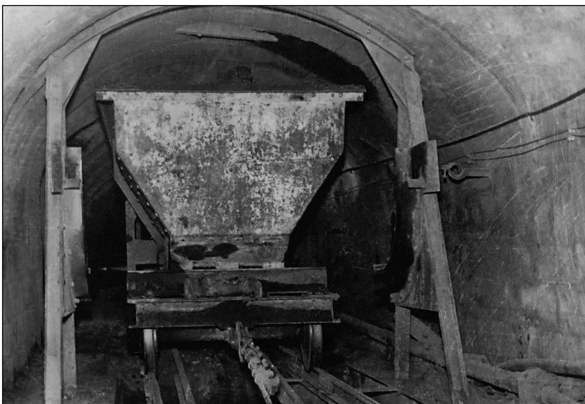
Figura 16: *Interior de mina con skip dentro del basculador (Fot. Archivo Celan, 1964).*
