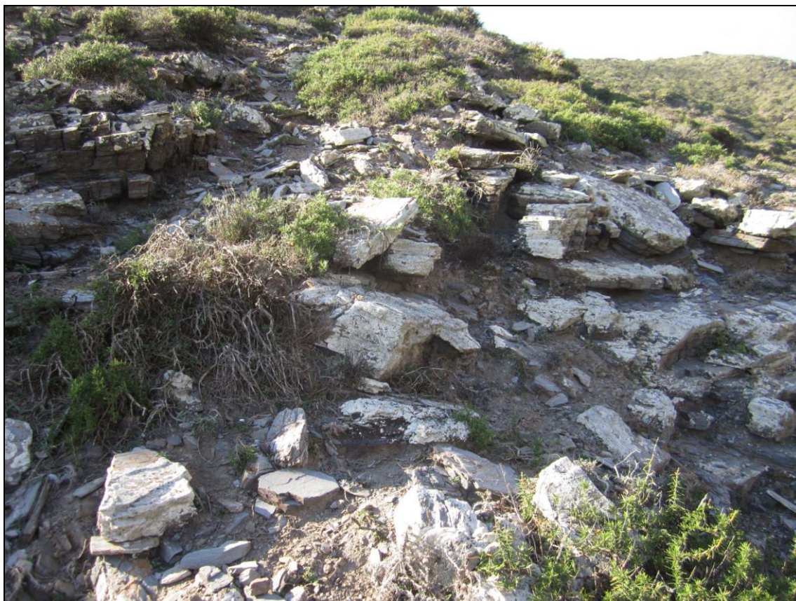
Figura 10: Mina 2. Visera de protección sobre la entrada. Cala Cocón (Cartagena).
