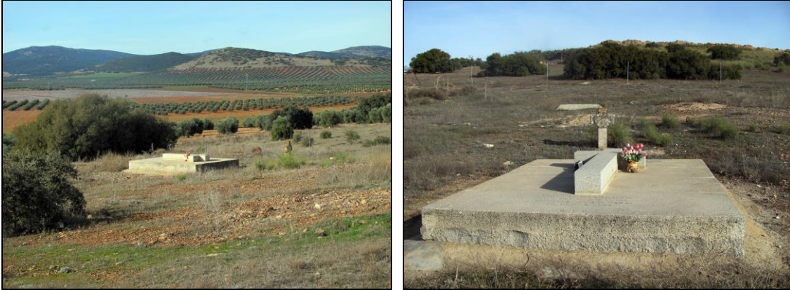
Figuras 92 y 93: Izquierda: Vista general de las labores en el Punto 25 con una lápida que cubre el pozo principal. Derecha: Lápida que cubre el pozo principal y detrás forjado de hormigón que clausura el pozo auxiliar en las labores del Punto 25.
