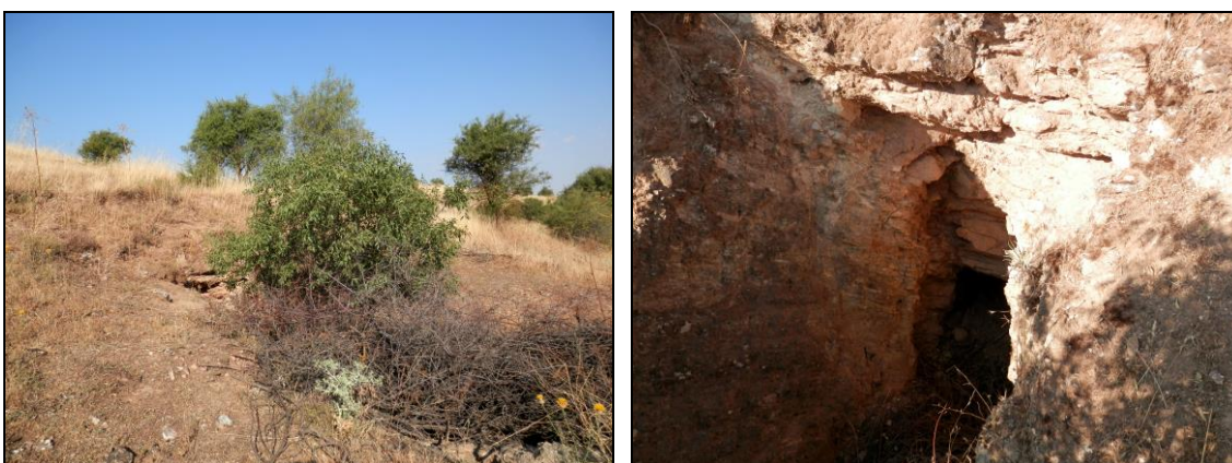
Figuras 38 y 39: Izquierda: Vista general de la zanja en el Punto 7 de las labores localizadas. Derecha: Detalle de cómo la zanja se introduce en las capas calizas en el Punto 7.
