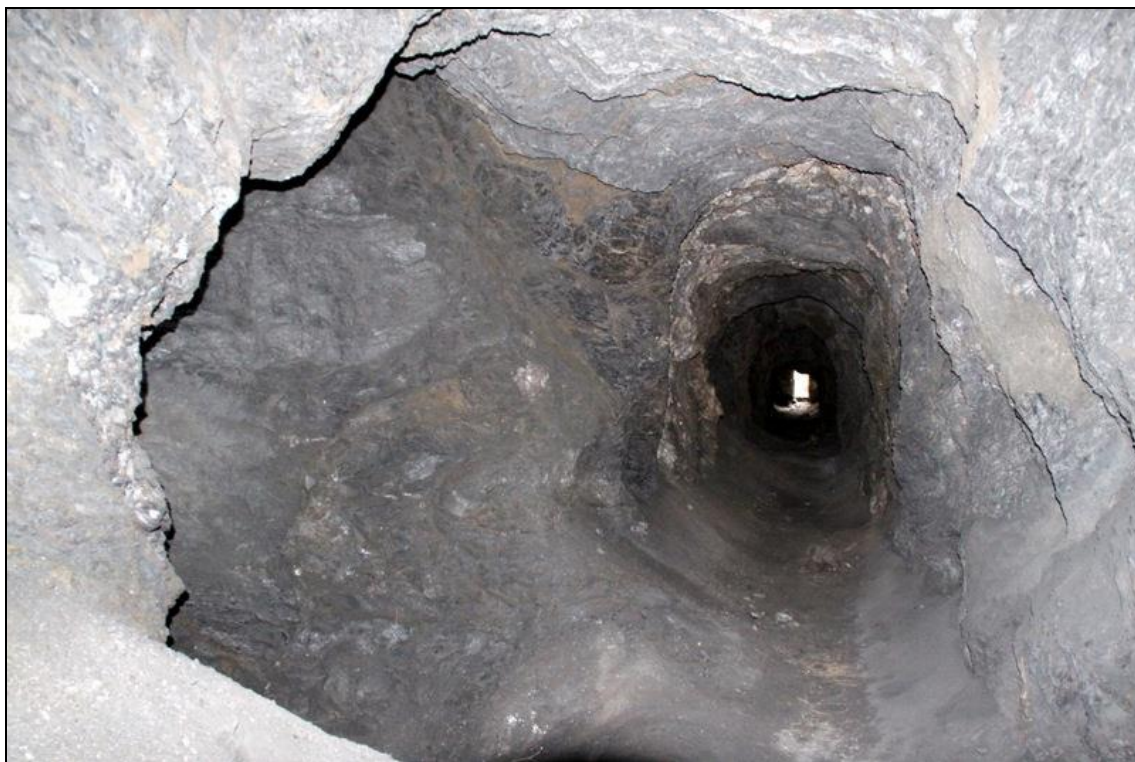
Tramo ampliado por trabajos más recientes (JM Sanchis, 2011)
