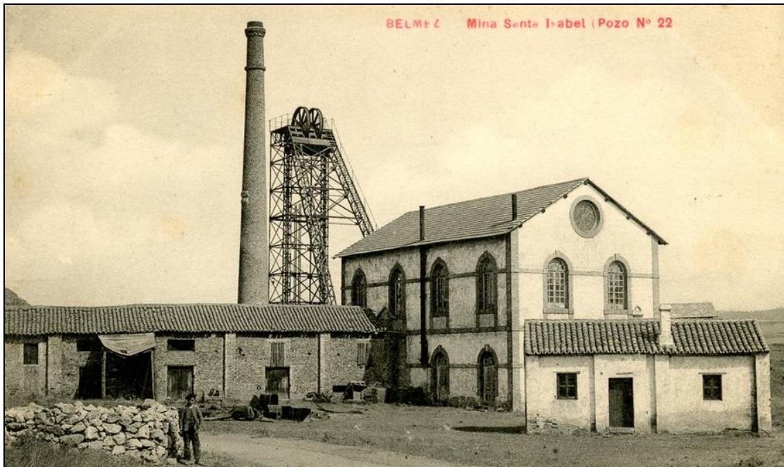
Figura 29: Pozo nº 22 de la mina Sta. Isabel (Arch. J.M. Sanchis)
