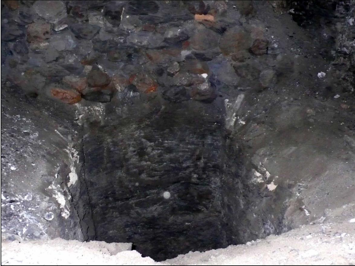
Sus constructores emplearon mampuesto en la coronación (F. Penco, 2011)
