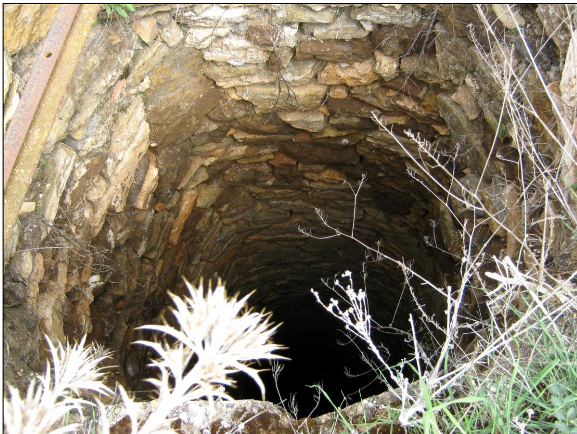
Figuras 46: Pozo de mampostería con sección circular en el Punto 11 de las labores localizadas.
