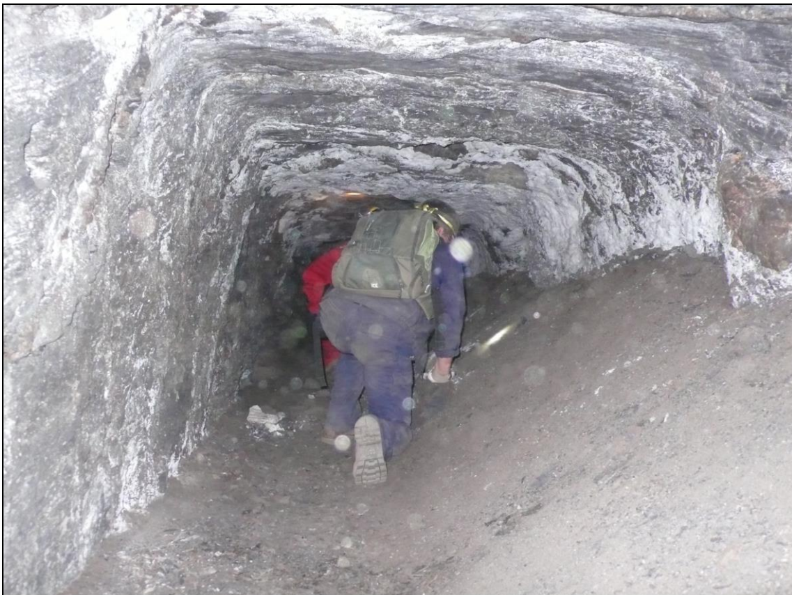
En algunos instantes, la galería se halla muy colmada por hundimientos y derrumbes (F. Penco, 2011)
