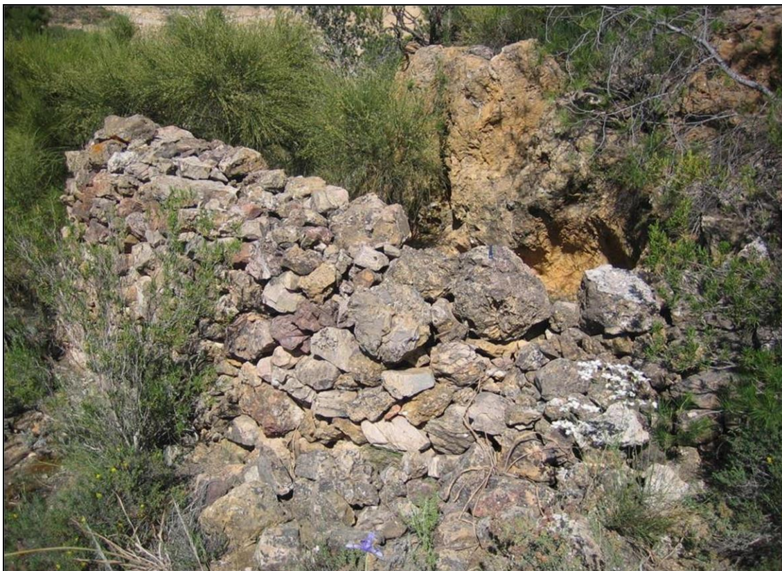
Figura 21: Horno de tostación de 5 m de largo, 2 m de ancho y 1,7 m de altura. Está abierto por uno de los lados y utiliza en parte una pared de roca natural. Se observa una rampa de carga. Actualmente desaparecido (2004, mina No ganamos para sustos, Pinar de Bédar).
