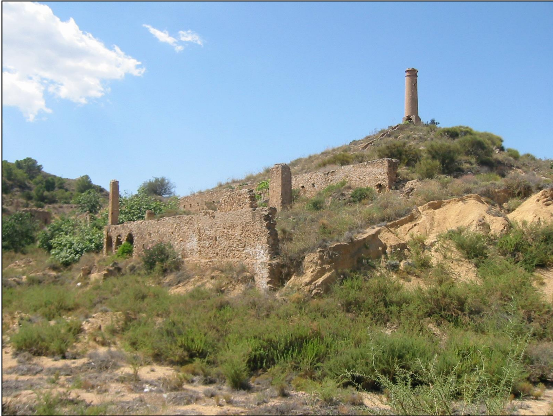
Figura 3: Fundición Carmen de Bédar, se observa una pequeña galería de condensación de humos (Pinar de Bédar, 2009).
