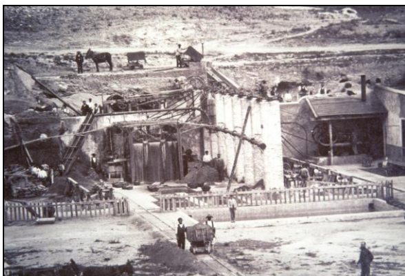
Figura 9 (Izquierda): Fotografía de José Rodrigo de las instalaciones de lavado de la mina Reforma entre 1881 y 1883. Se distinguen dos trómeles de clasificación, cribas cartageneras, varios rumbos, y una criba oscilante. Se distingue la locomóvil que acciona toda la maquinaria.
