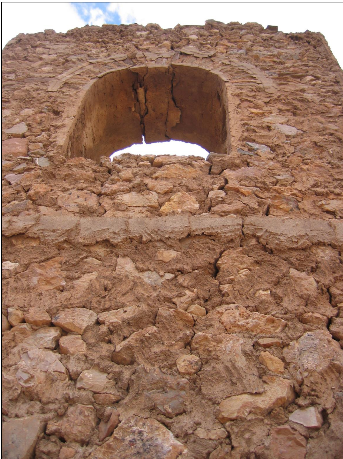
Figura 2: Torre de 10 metros con abertura inferior y arcos decorativos, podría tratarse de un horno de cuba (fundición Carmen de Bédar, Pinar de Bédar, 2009).
