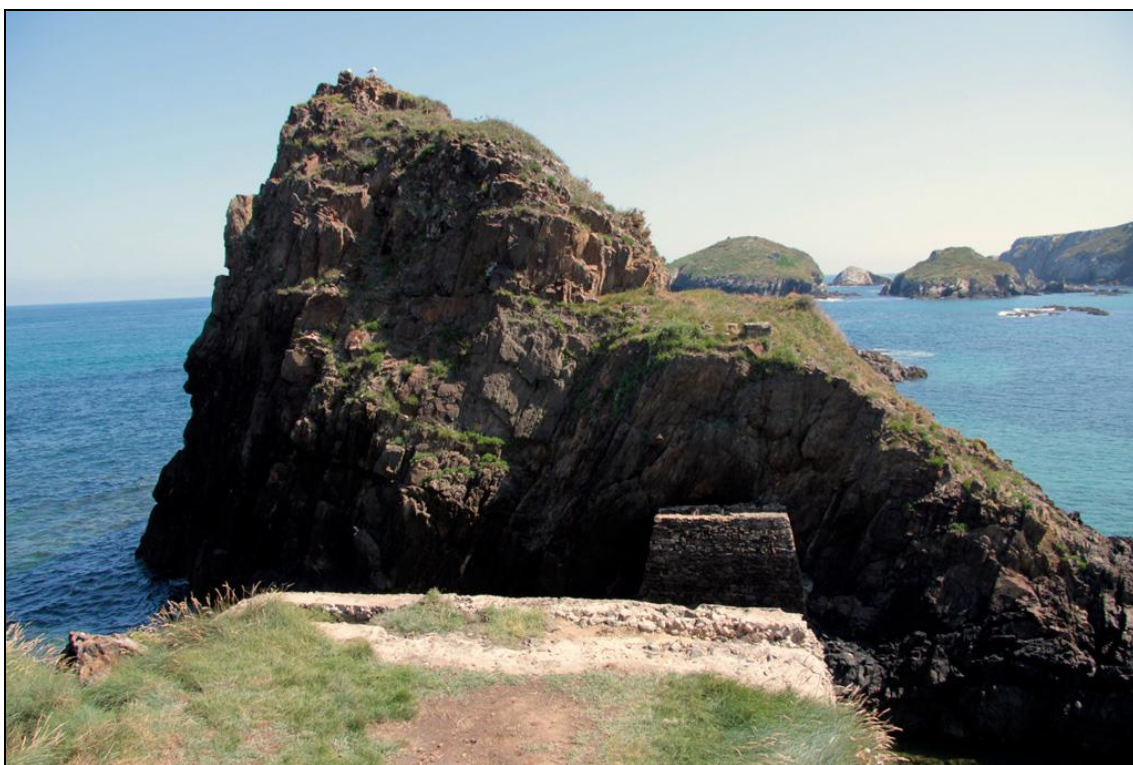
Figura 17: Zócalos de hormigón en el que se apoyaban los castilletes del cable (Fot. J.M. Sanchis, 2014)
