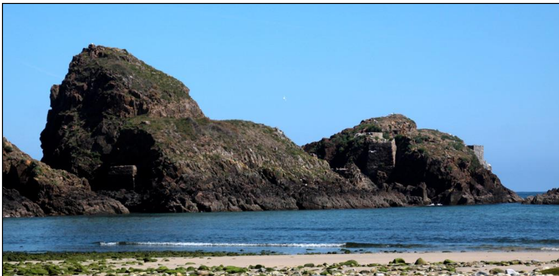
Figura 29: Farallones donde apoyaban los castilletes del cable (Fot. J.M. Sanchis, 2014)
