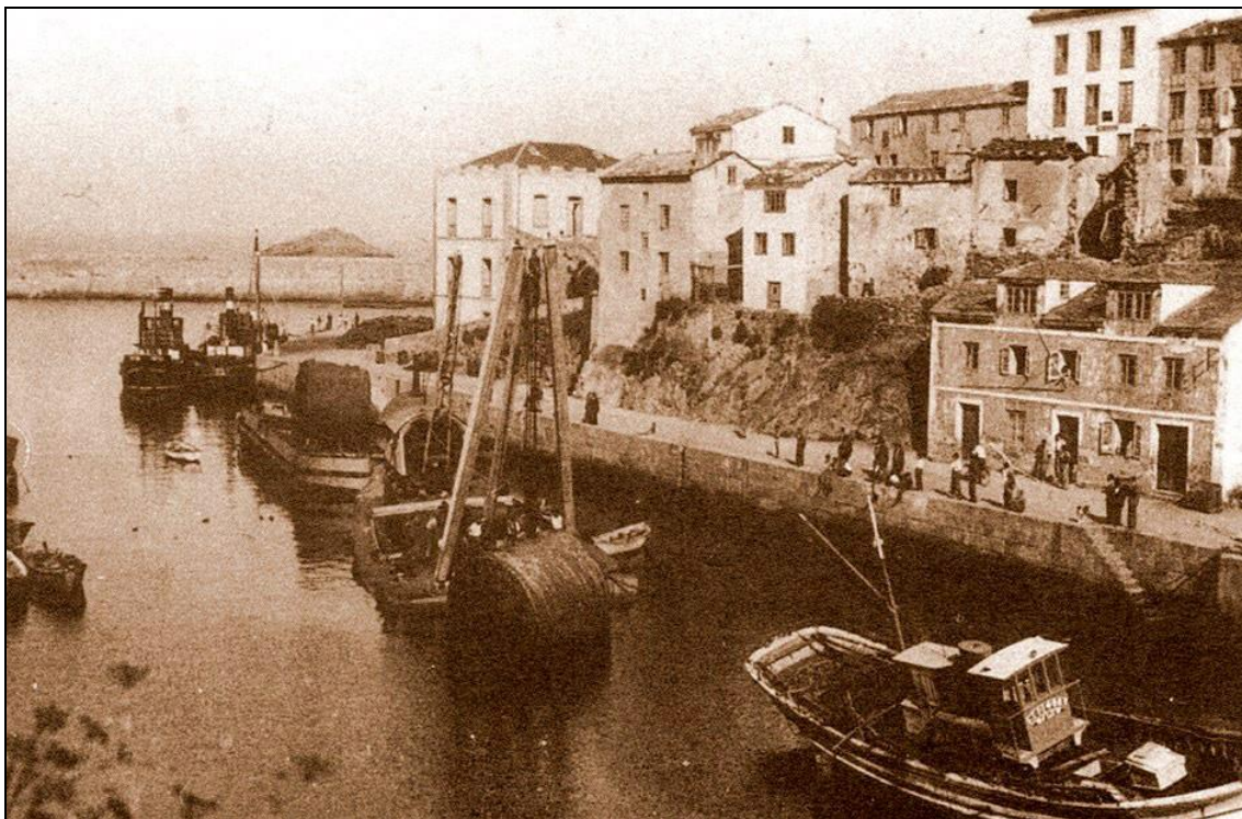
Figura 21: Descarga de las calderas (Fot. Amigos de la Historia de Tapia)
