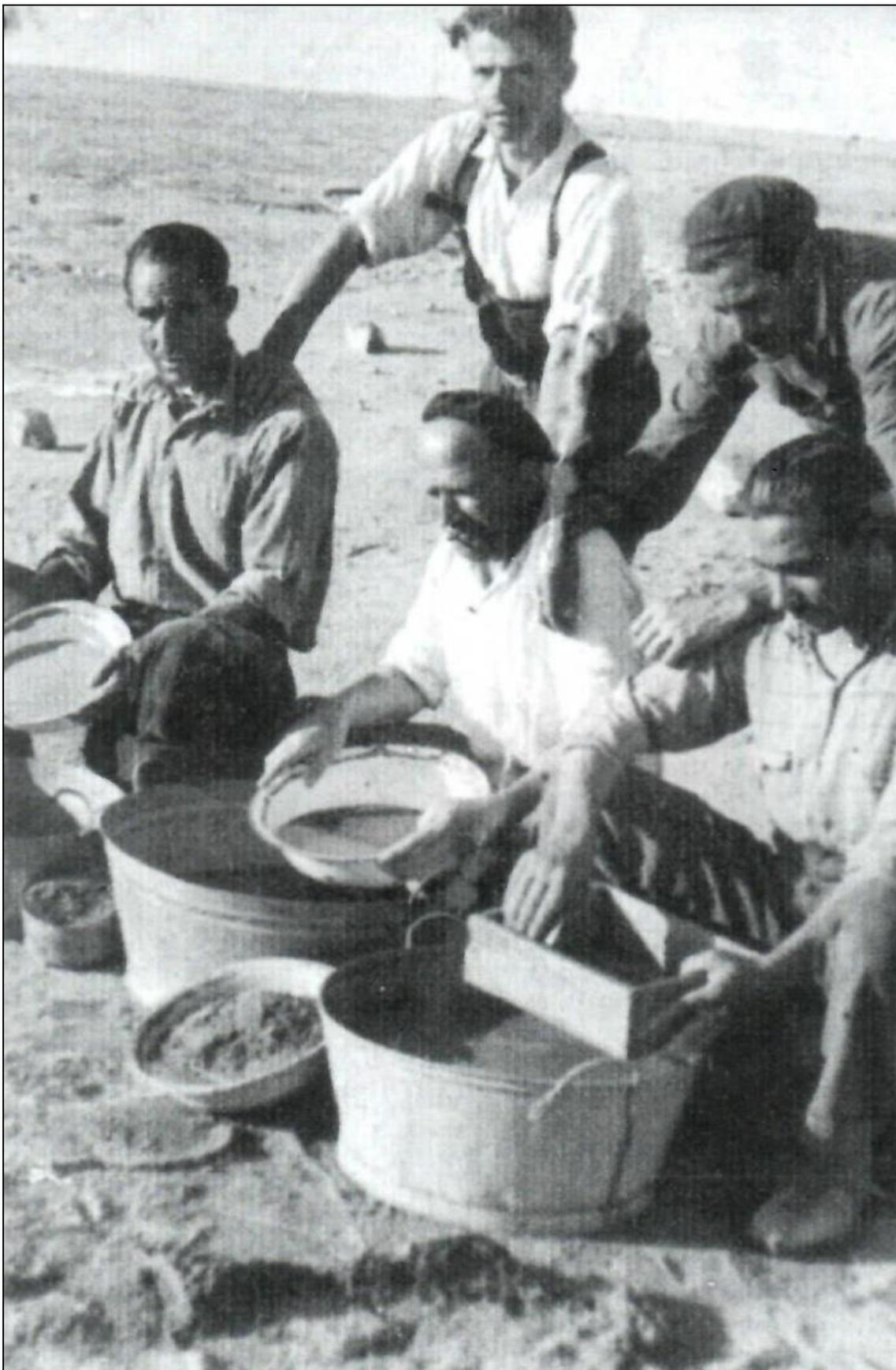
Figura 3: *Mineros lavando sedimentos para la obtención de concentrados de wolframita (ferberita), scheelita, casiterita y, en ocasiones, oro, en el año 1945. Fotografía tomada de Almeida (1999).*
