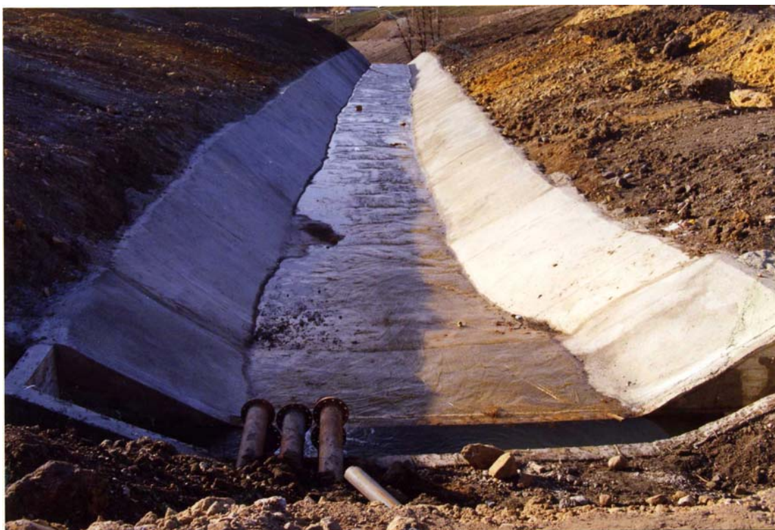
Figura 7: Ejemplo de canal perimetral construido para la conducción de las aguas de escorrentía y bombeadas.
