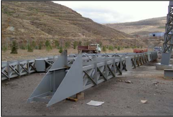
A la izquierda: tornapuntas del nuevo castillete, sin instalar. Diciembre 2007 (Fot. J.M. Sanchis). A la derecha: Plaza de la mina y castillete en fase de montaje. Diciembre 2007 (Fot. J.M. Sanchis)
