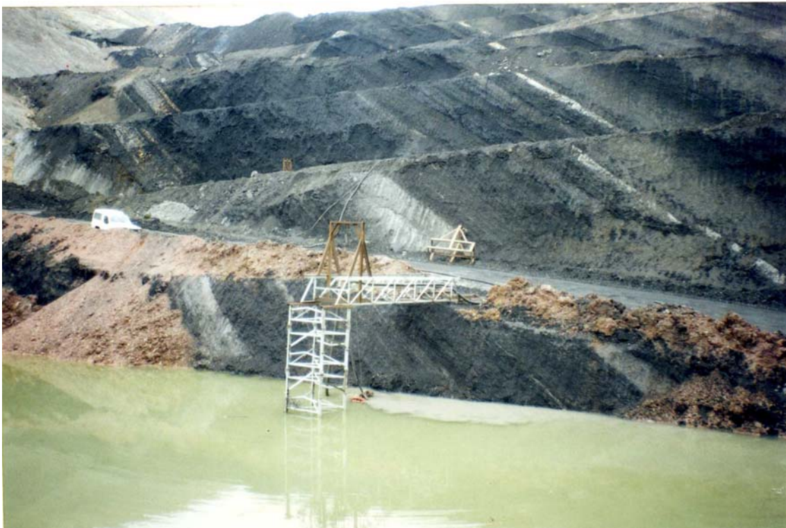
Figura 8: Bomba de achique instalada en una plataforma construida al efecto.
