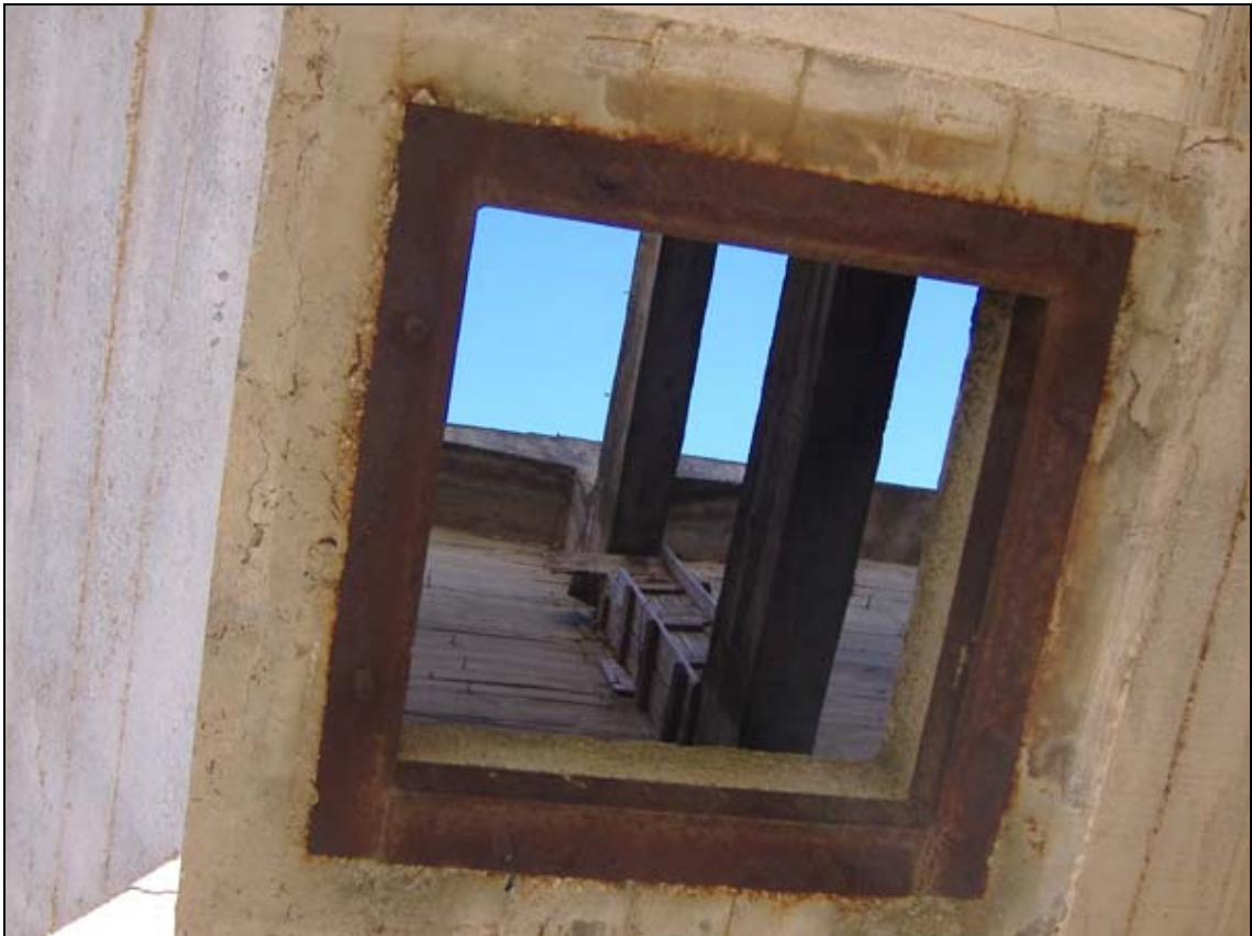
Interior de tolva con el encofrado original. 2006
