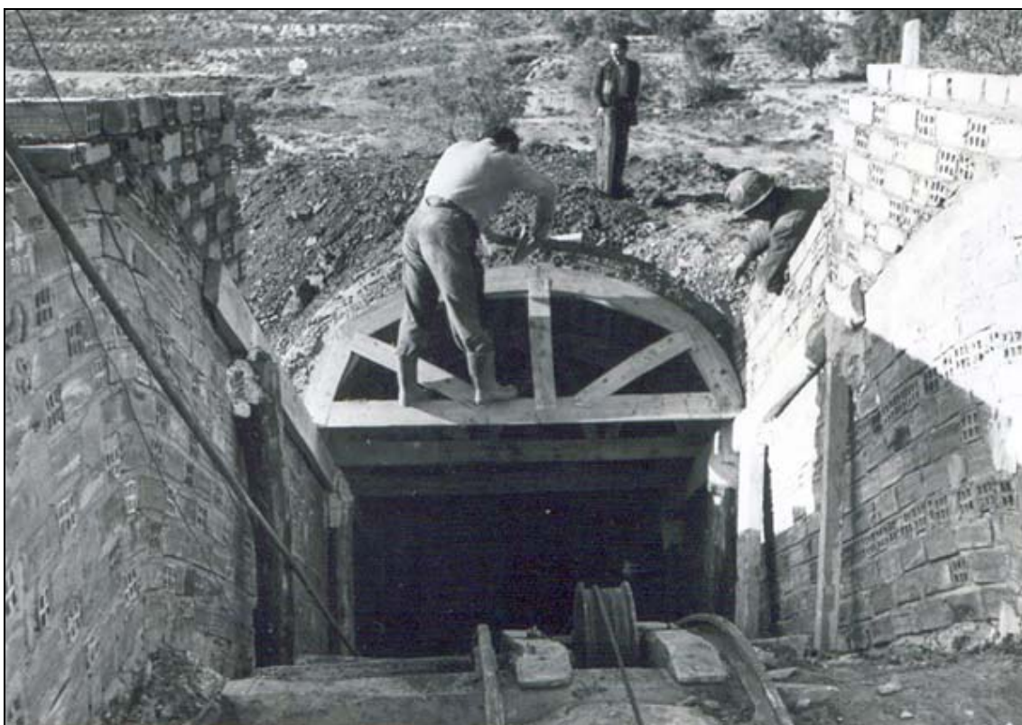
Detalle de construcción del plano auxiliar en el año 1957, cerrando la bóveda de emboquille del mismo.
