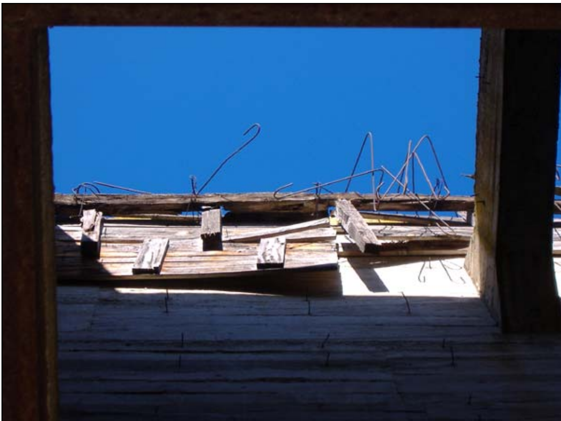
Detalle del interior de la tolva de hormigón, se observa todavía la madera del encofrado, no llegó a finalizar su construcción. 2006
