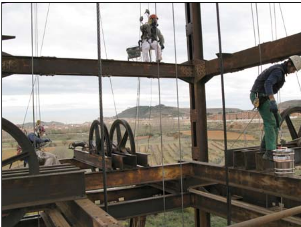
Trabajos de tratamiento y pintado del castillete
