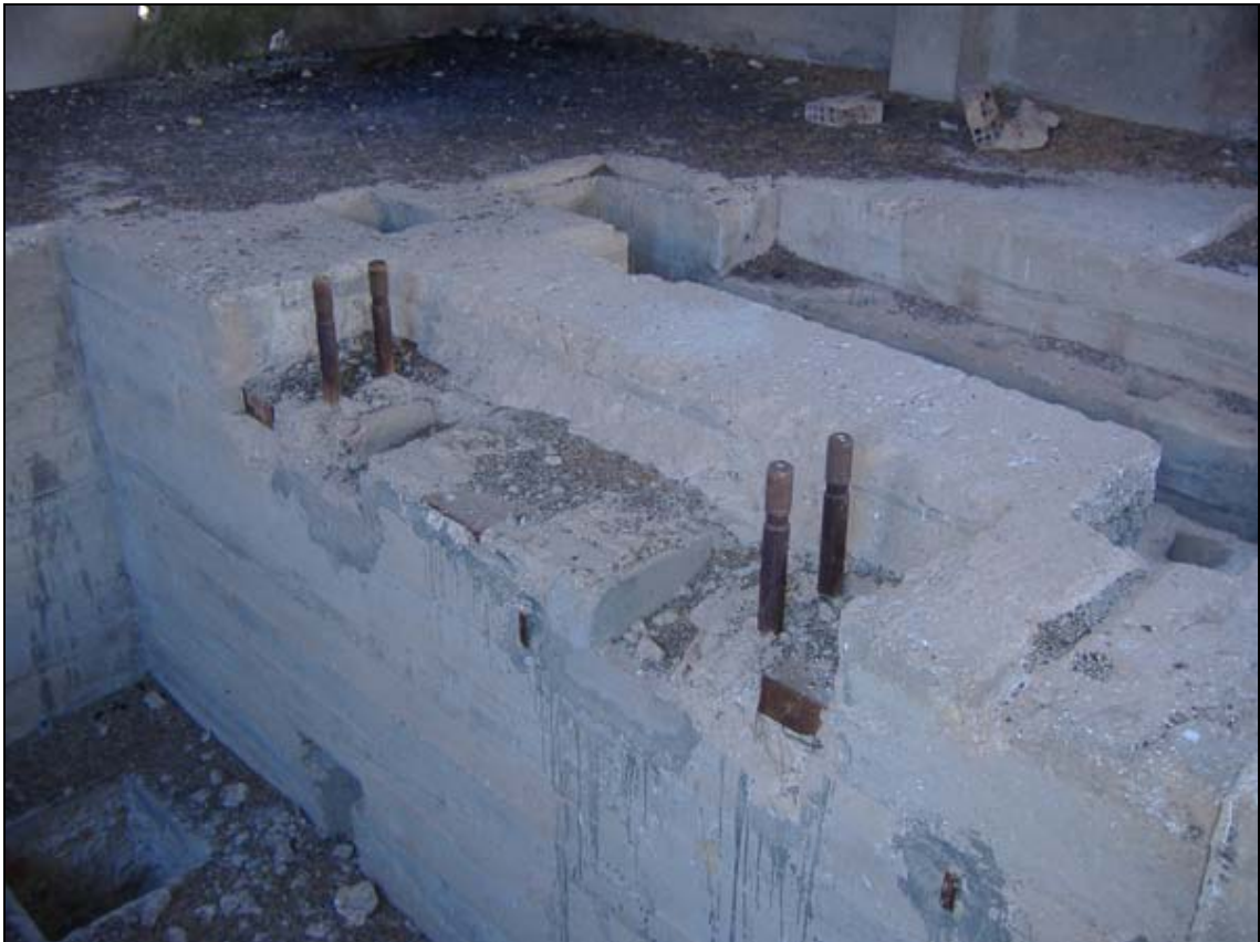
Anclajes de la máquina de extracción una vez desmantelada. 2006
