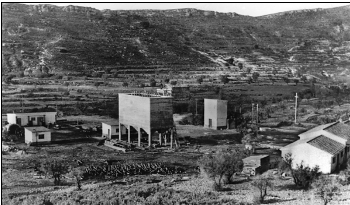
Vista general de las instalaciones finales de los 50, construyéndose la tolva, se observan los dos planos de acceso a la mina por delante con sus casetas para alojar los cabrestantes.
