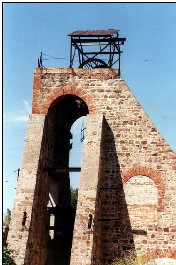
Castillete de mampostería (Fot. J.M. Sanchis, 2002)
