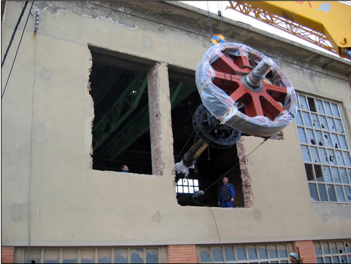
Figura 26: Montaje de máquina de extracción Robey en Pozo San Juan (Fot. José Juárez, 2006).
