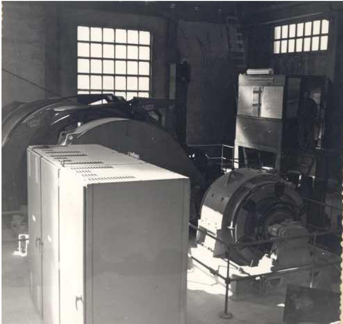
Figura 18: Máquina de extracción Robey, instalada sala de máquinas del Pozo San Juan, 1960 (Fot. Asoc. Cultural Pozo San Juan).
