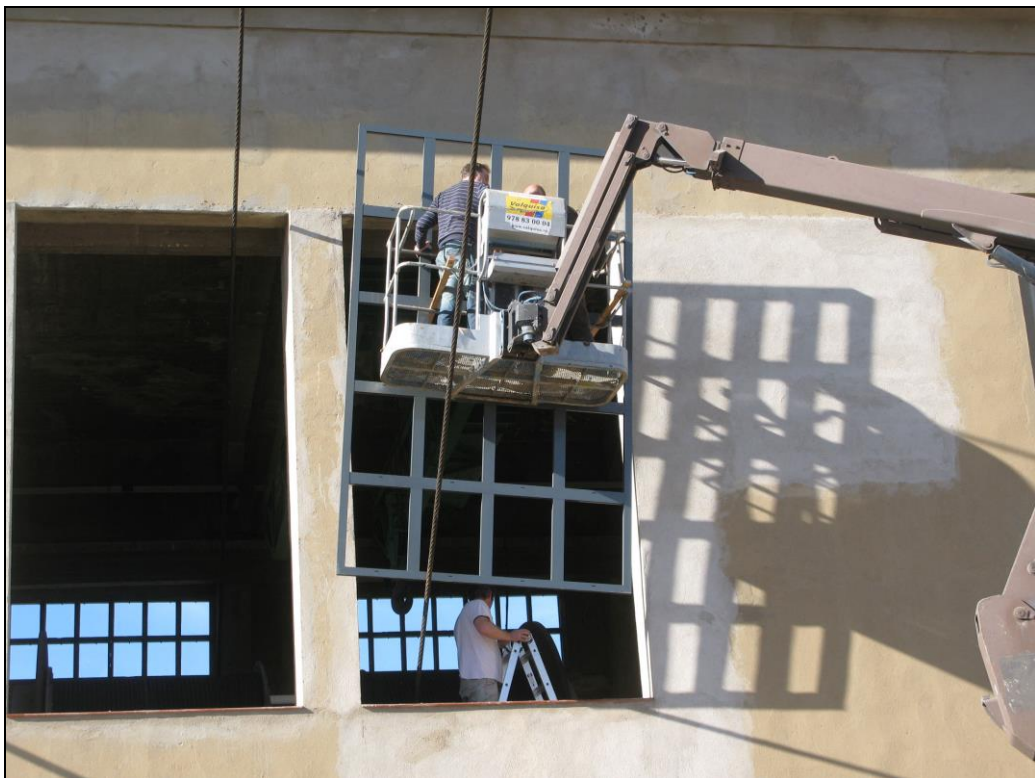
Figura 33: Colocando cristalerías nuevas en los huecos del edificio (Fot. José Juárez)
