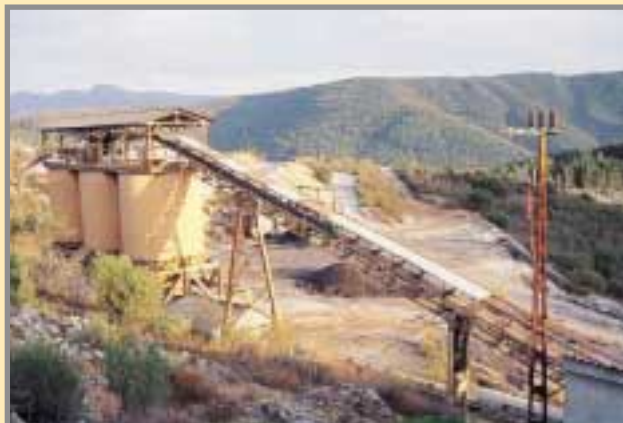
Cinta y silos de mineral (para 600 t) a la salida del lavadero de la mina, en septiembre de 1998. También fueron instalados en 1976 por Peñarroya. Actualmente han sido desmantelados, junto a otras instalaciones exteriores. Foto: G. García.
