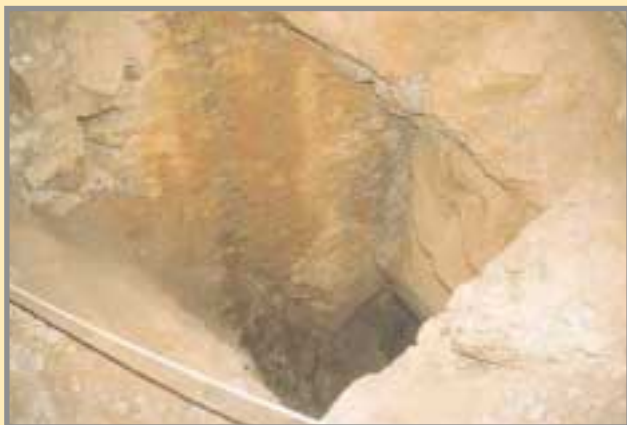
Una vista del pozo "Manolito", sobre el filón "Ingeniera". Sirvió de pozo de arras- tre para comunicación con los trabajos inferiores. Foto: A. Bueno, 12/2002.
