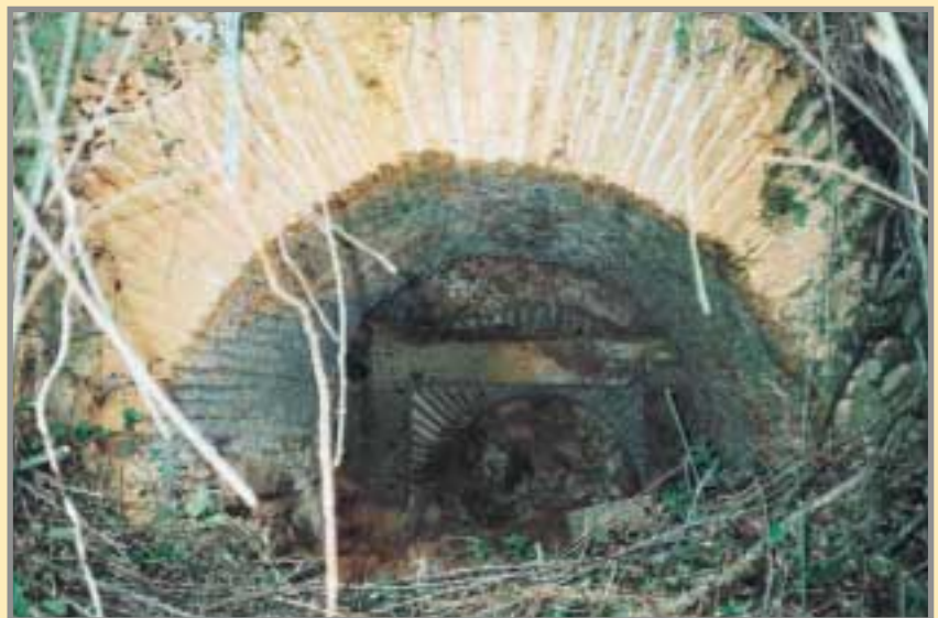
El socavón "San Felipe" atravesaba mayor distancia en material suelto, por lo que dispone de arcos de mampostería como refuerzo. No obstante, en la actualidad está hundido como se aprecia en la imagen, siendo imposible su reconocimiento. Foto: C. Gzlez. Bargaño, 2002.
