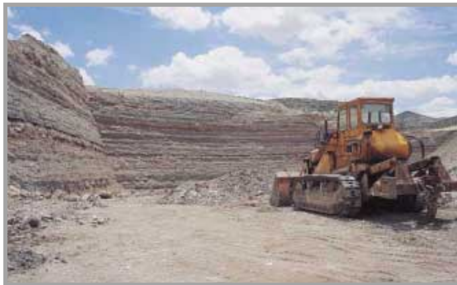
Bulldozer con uña de ripado. Con esta máquina se desarma el piso por pasadas sucesivas, aflojando el terreno y separando los bolos de alabastro del resto de materiales estériles. Foto: G. García, 6/2002.
