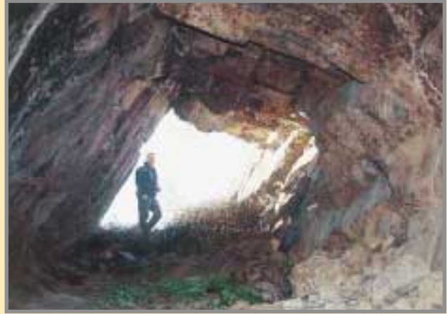
Vista de la sección inclinada de la galería principal de la mina "Capitán". El socavón discurre en estéril hasta que corta el filón. Foto: G. García, 11/2001.
