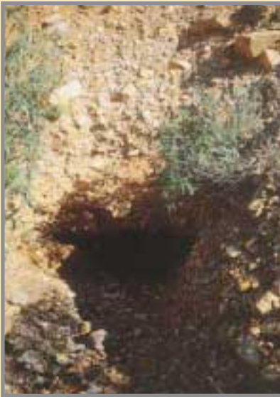
Estrechez del acceso al socavón "Dos de Mayo". Para facilitar su conservación, o fomento de su valor científico y turístico, sería conveniente rebajar su piso y encofrar el emboquille. Foto: G. García, 5/1995.
