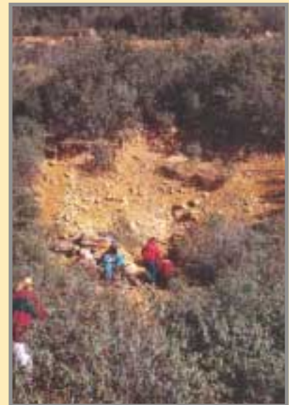
Acceso al socavón "Dos de Mayo", en la ladera de la Sierra Jaena. Los materiales de la entrada son rañas sueltas de escasa estabilidad, lo que favorece la ruina del acceso al interior. Foto: G. García, 5/1995.
