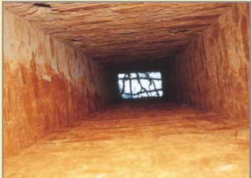
Pozo vertical de mampostería en el socavón "Dos de Mayo" de la mina "Pilar". Su base se encuentra reforzada por dos bóvedas de ladrillo, pero su brocal en superficie no está adecuadamente protegido ni señalizado. Foto: G. García, 11/2001.
