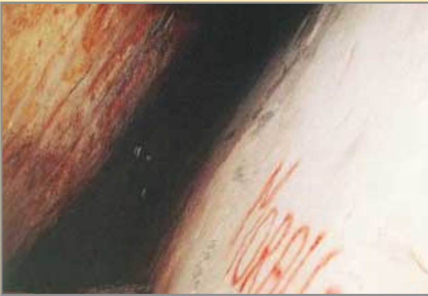
Perfecta ranura que ocupaba el filón "Moralidad". Esta veta ha sido extraída con completa limpieza, lo que hace pensar que probablemente fue uno de los filones más productivos de la mina. Foto: L. Jordá.
