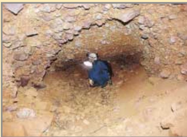
Vista interior de los primeros metros del socavón "Dos de Mayo", que discurre en coluviones del Plioceno. Foto: G. García, 11/2001.
