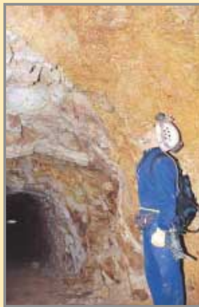
Contacto por falla, con el conglomerado triturado por cizalla frágil. Al fondo, la luz del exterior. Socavón "Dos de Mayo". Foto: G. García, 11/2001.
