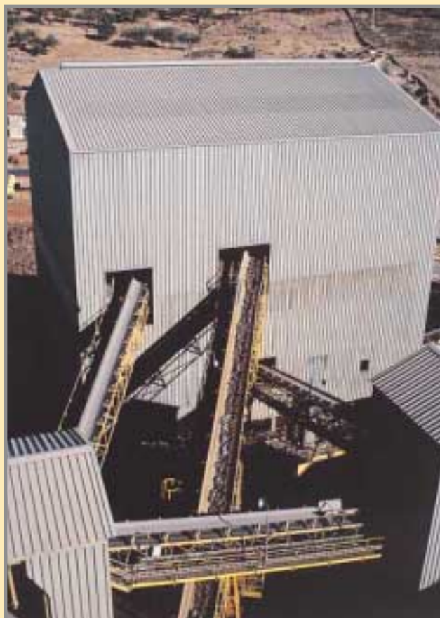
Entrada y salida de cintas de trituración primaria a terciaria. Foto: G. García, 11/98.
