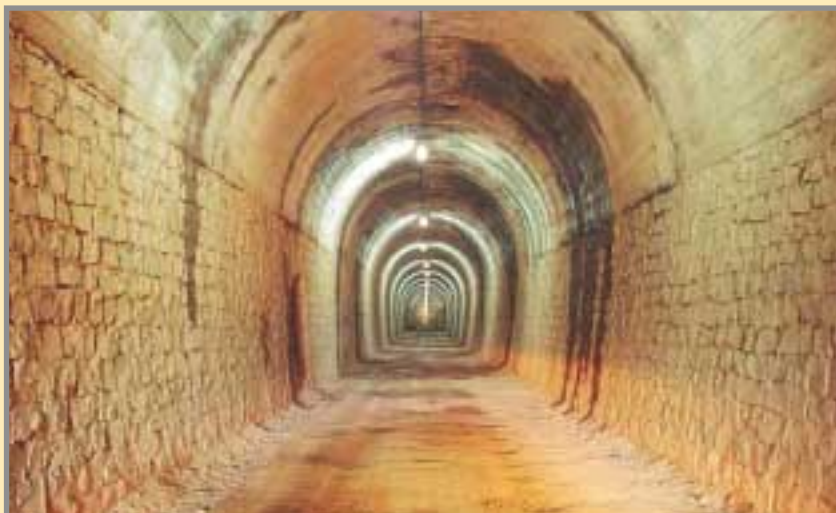
Túnel del ferrocarril de Puertollano a Peñarroya, habilitado actualmente como acceso a El Horcajo. En uno de sus laterales, tiene acceso a un pozo que toca mineralización del filón "María del Pilar". Foto: A. Bueno, 2003.
