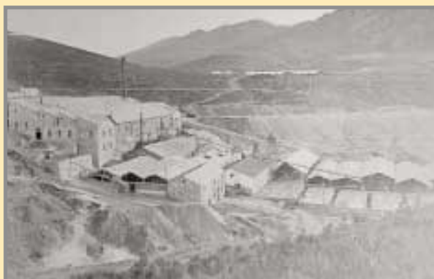
Lavadero de tierras pobres. Se empezó a construir el año 1875; notablemente reformado a partir de 1890, podía entonces considerarse como un lavadero modelo. Ocupaba una superficie de 7.000 metros cuadrados, trabajaban en él 300 operarios y podía lavar 300 toneladas de mineral al día. Utilizaba el agua de la mina, recogida y sedimentada en grandes depósitos. También contaba con un pequeño taller mecánico, para las reparaciones necesarias en este servicio. En este edificio hubo un laboratorio muy bien montado, para hacer el análisis de los minerales.
