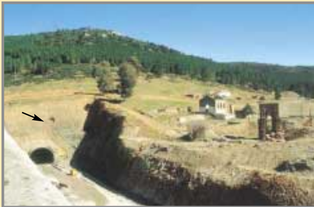
Estado de las obras del AVE a su paso por El Horcajo. La flecha señala el punto en que la trinchera secciona el socavón transversal del filón "María del Pilar". Foto: B. Sáinz de Baranda.
