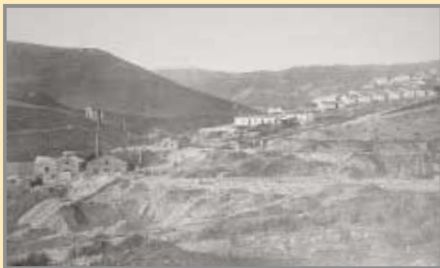
Vía exterior y plano inclinado. Había una línea férrea que unía los diversos pozos de extracción, y servía para conducir los minerales desde ellos al plano inclinado. El transporte se hacía en vagones de hierro arrastrados por pequeñas locomotoras de 8 caballos de fuerza cada una. A la terminación de esta vía había un plano inclinado de 103 metros de longitud con un desnivel de 25 metros, por donde se transportaban los minerales hasta el lavadero de tierras pobres.
