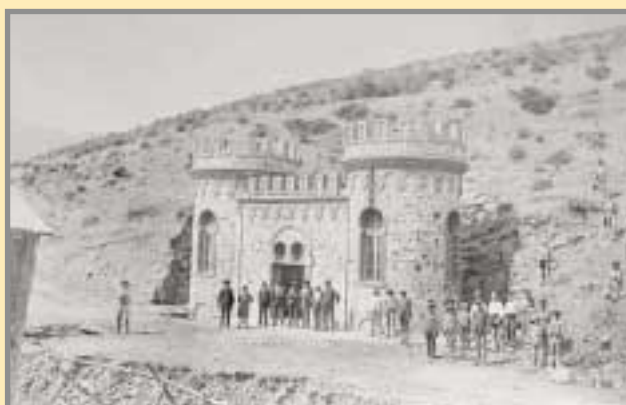
Instalación eléctrica. En este edificio había instalada una turbina de 20 caballos de fuerza que movía una dinamo sistema Derrossier, que suministraba el alumbrado a la población. Este edificio se conserva prácticamente intacto a día de hoy, y constituye un bien patrimonial a proteger como testimonio del centro minero del Horcajo.
