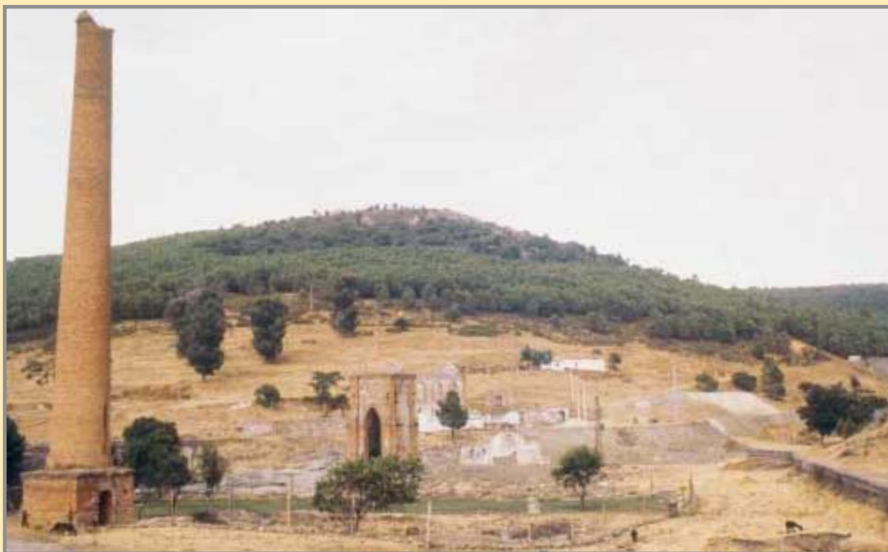
Panorama de las minas del Horcajo antes de iniciarse las obras del tren de alta velocidad. Lo más significativo de la imagen es la ya desaparecida chimenea de ladrillo de una de las máquinas de vapor asociada al avanzado sistema de desagüe del Pozo "Argentino", cuyo bello brocal de mampostería se erige un poco más al fondo. Foto: F. Palero, octubre de 1986.
