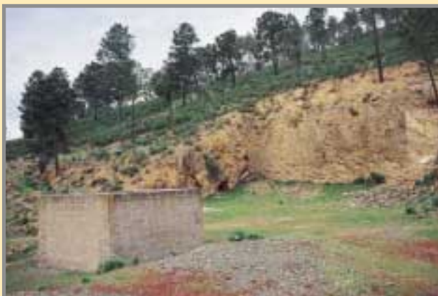
Brocal del Pozo "Postdata", y retranqueo del talud para la ubicación de la máquina. El pozo se encuentra colmado de basuras. Abril de 2003. Foto: G. García.
