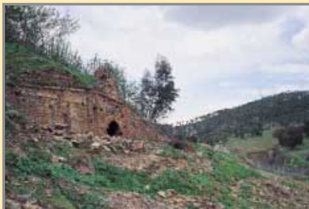
Estado actual del socavón del Pozo "San Juan". Por este nivel salían los vagones con la producción para el ferrocarril con destino al lavadero. Foto: G. García, 2003.
