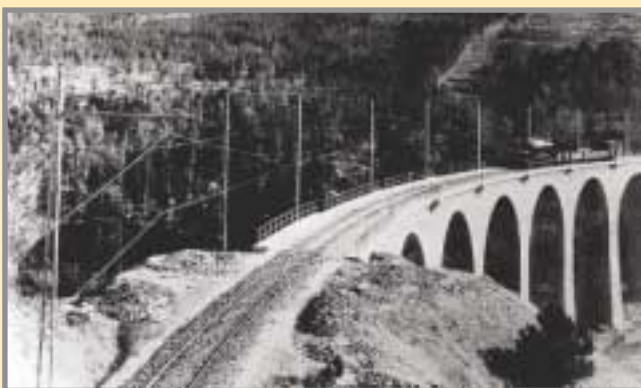
Ferrocarril de Puertollano a Peñarroya, justamente en el viaducto de El Horcajo. Este ferrocarril era conocido popularmente como "La Eléctrica" (sin "e"). Se utilizaban locomotoras "Cocodrilo" alimentadas por electricidad suministrada por la central térmica que la SMMP tenía en Puertollano. El ferrocarril servía para unir los principales centro mineros que la empresa tenía en esta zona: "San Quintín", Puertollano, El Horcajo, La Garganta, "El Soldado" y Peñarroya. La foto es de comienzos de los 50, cedida por el Museo Municipal de Puertollano.
