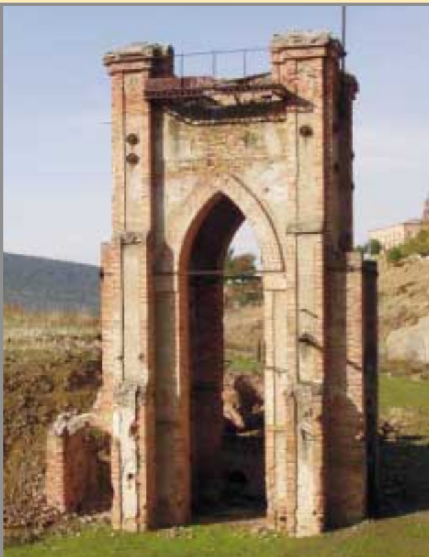
Vistas laterales del estado actual del Pozo "Argentino". Este pozo, que fue uno de los más profundos a efectos de desagüe, alcanza la planta 23, a 518 metros de profundidad. Fotos: F. Palero.
