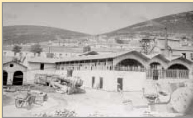
Lavadero Malacate. Fue construido por Leopoldo Meyer el año 1889. Estaba destinado a lavar el mineral rico, estriado por los operarios en la mina. Podía dar lavadas 30 toneladas de mineral por día. Tenía un trómel y 14 cribas mecánicas, movidas por una máquina de vapor de 15 caballos de fuerza. Había en él también un secadero de vapor para los lodos, utilizando para este objeto el vapor que sobraba del Malacate. En este lavadero se recogía el 60 % del mineral total.
