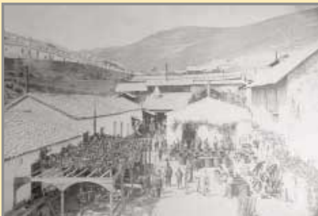
Talleres mecánicos y almacenes. Disponía de los aparatos y operarios para reparar y mantener las más perfeccionadas máquinas. Trabajaban en estos talleres 107 operarios y dependían de ellos 47 maquinistas y operarios. Disponía de tornos, fresadoras, 11 fraguas, horno para fundición de hierro, grúas, carpintería, taller de calderería, etc. Fotos: "Recuerdo del Horcajo", cedido por M. Morales.
