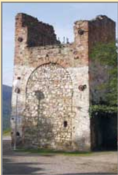
El Pozo "San Juan" fue escenario en 1899 de un lamentable incendio que acabó con todo su guionaje. En la reparación, se forró enteramente de mampostería. Foto: G. García, 12/2003.
