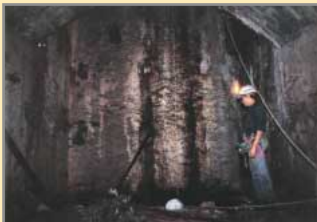
Un equipo de esta revista descendió en 1995 al Pozo "San Juan", pero a 50 metros tiene efectuado un tapamento sobre el que se ha arrojado gran cantidad de basura. En la imagen, enganche del pozo al socavón de transporte. Foto: G. García.
