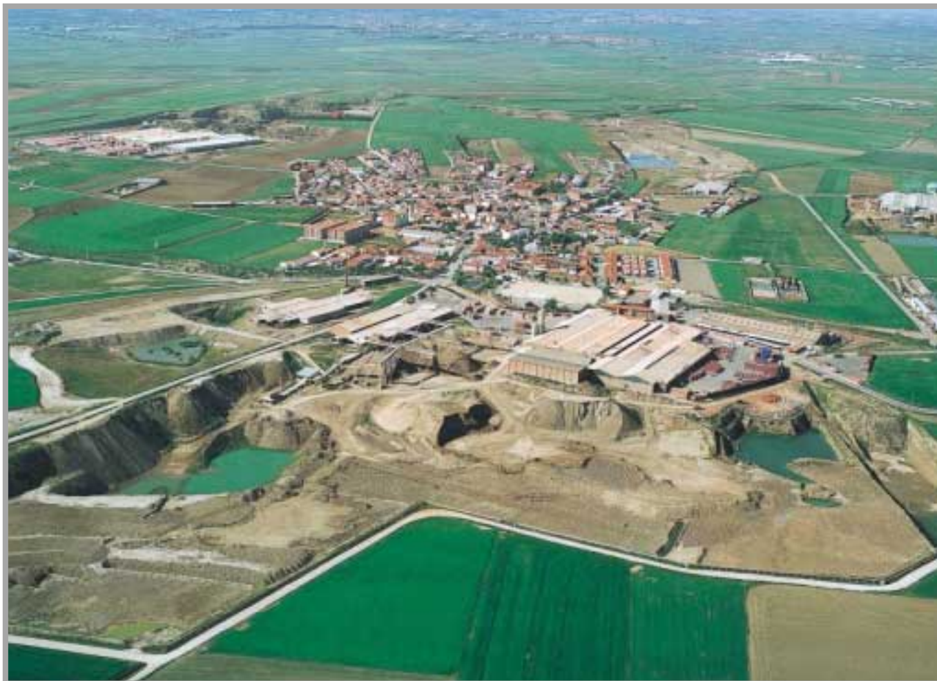
Imagen de conjunto de una instalación cerámica. En primer plano, las canteras de extracción, con amplias parvadas a la intemperie. Un poco más al fondo, apiladora para la alimentación de fábrica, donde se verifica la dosificación y mezcla de la arcilla. A continuación se inicia el proceso en nave cerrada, donde tras la molienda en seco o en húmedo se extrusión la pasta moldeando la forma definitiva de la pieza. Posteriormente se seca y se cuece, se paletiza y sale al parque de producto terminado. En la imagen, fábrica de Hnos. Díaz Redondo, en la localidad de Cobeja (pueblo al fondo). Foto: Cortesía de HDR, S.A.
