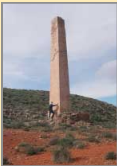
Chimenea de las máquinas de vapor instaladas en la mina "Santa Bárbara", del Área de Cabo de Gata. Se trata de una de las explotaciones más importantes de Pb-Zn. Foto: F. Palero, 12/2003.
