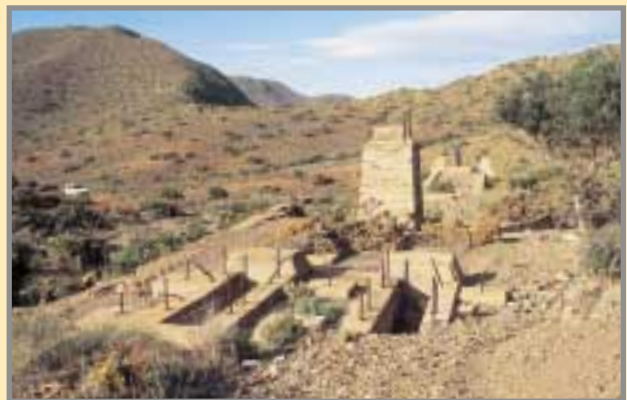
Punto de partida del cable aéreo que se estableció para la explotación de las escombreras de las minas del Área de Cabo de Gata. Foto: F. Hernández, 12/2003.
