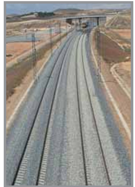
El balasto para la vía férrea es una de las aplicaciones más importantes de la ofita, donde se requiere una resistencia e inalterabilidad elevada. Foto: G. García.
