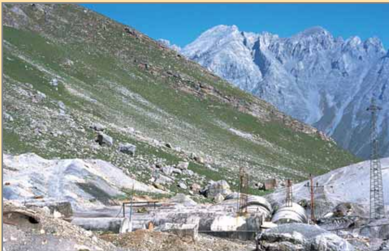
La energía eléctrica necesaria para los trabajos se tomaba de la subestación de Ojeda, desde donde partía una línea de 30 kV que accedía al Puerto de Áliva por el Collado de la Cámara y, atravesando Campomayor, La Lomba y La Torpeza, llegaba hasta la mina. Para los casos de falta de suministro por avería, se disponía de un grupo electrógeno de gasoil Caterpillar de potencia suficiente para atender el desagüe, la jaula del pozo y el alumbrado de las instalaciones de exterior. Foto: G. García, 1991.
