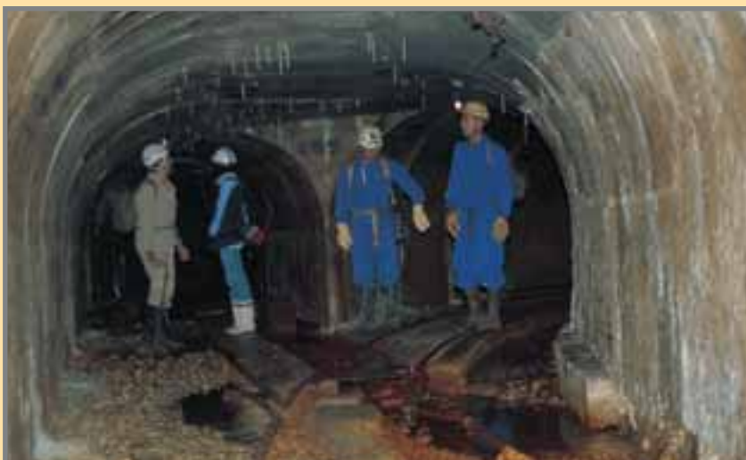
Bifurcación a la jaula en el primer nivel. Zona de sedimentos glaciares integramente hormigonada. Foto: G. García, 9/2002.
