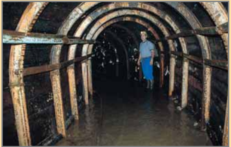
Historia minera y desarrollo industrial de la mina de Áliva: Galería del Vino en la 1ª Planta, completamente posteada.
