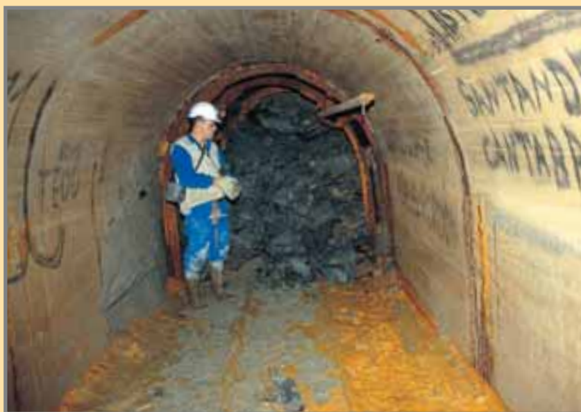
Hundimiento producido por el contacto con las pizarras de la Formación Lebeña con la Caliza de Muro. 2ª Planta. Foto: G. García, septiembre de 2002.
