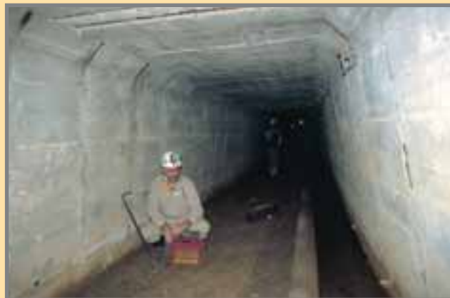
Socavón general de acceso desde el primer nivel, enteramente hormigonado y cuneta lateral para desagüe. Foto: G. García, 2003.
