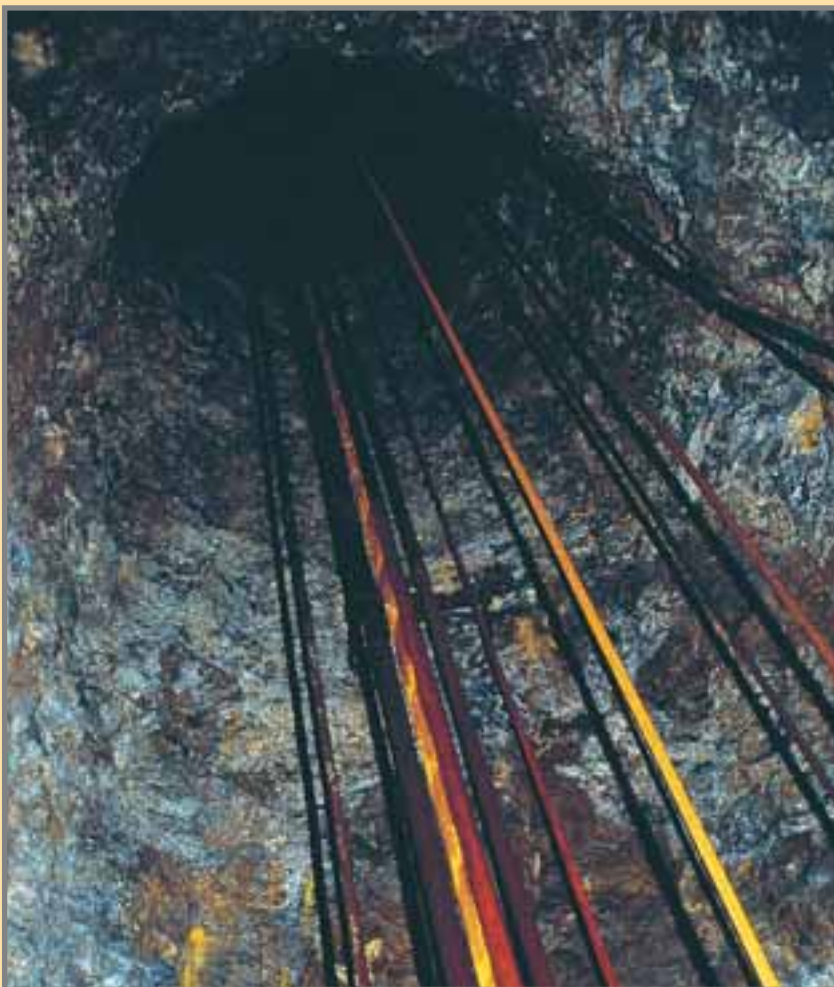
Vista cenital del guionaje de cable del pozo principal o nº 2 desde el embarque de la 3ª Planta. Foto: G. García, 9/2002.
