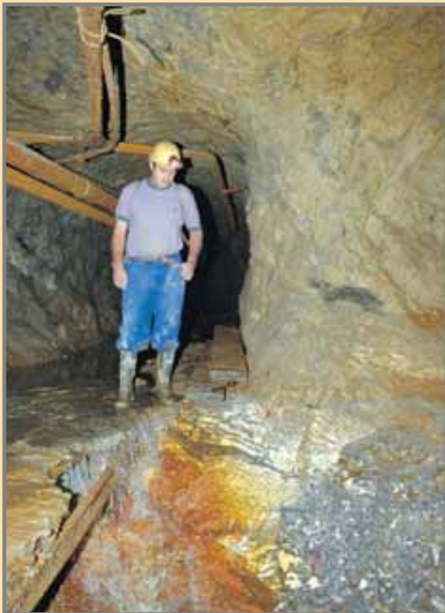
Rotura en el piso en una galería de transporte de la 3ª Planta. Obsérvese la textura cebrada de la dolomía. Foto: G. García, 9/2002.
