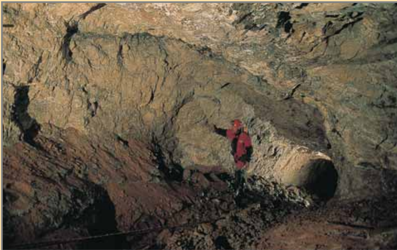
Bella perspectiva de la rampa de comunicación entre las plantas 2,5 y 3ª, que exhibe un contacto neto entre las calizas y la dolomía. Un 80% del recorrido subterráneo no requiere ningún tipo de sostenimiento artificial, merced al excelente comportamiento de las litologías de la mina. Foto: Fernández/Valls.
