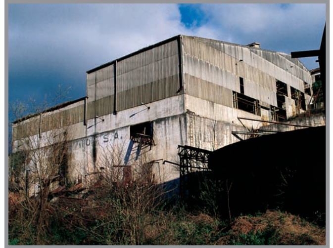
El lavadero de "Fluoruros, S.A." en La Collada disponía de 2 secciones de medios densos, una por tambor y otra por ciclones, previa desenlodado y trituración, con una capacidad de 40 t/h. El producto preconcentrado se llevaba posteriormente a la planta de flotación de Pinzales. En la foto, aspecto de la instalación en 1998. Foto: G. García.
