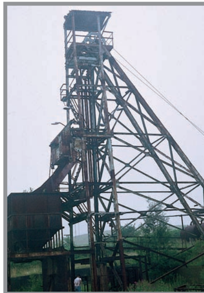
Castillete de 27 m de altura de la mina "Coroña", hoy lamentablemente desaparecido. Daba servicio a un pozo vertical de 127 m de profundidad completamente revestido de hormigón y 3 plantas. Cortaba al filón "Josefa" en el nivel 40. Foto: G. García, 7/1993.
