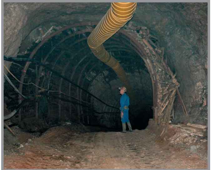
Revestimiento con cerchas y madera en la pendiente del nuevo plano inclinado. Foto: G. García, 2006.
