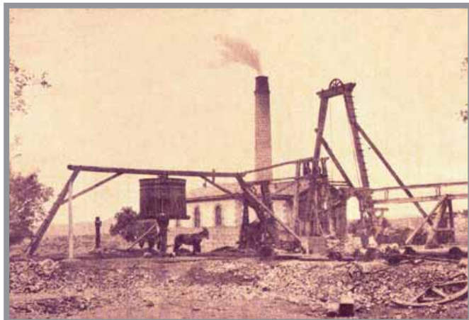
Malacate en el Coto San Antonio, concesión "Cándida". La chimenea del fondo corresponde a una máquina de vapor para accionar el bombeo. Foto: Archivo de F. Gutiérrez Guzmán.
