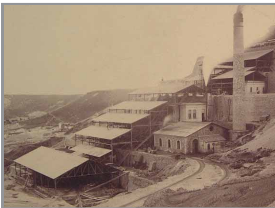
Vista de conjunto del Lavadero de la mina “Arrayanes”, a finales del siglo XIX. Este lavadero mecánico, construido en 1891 por la casa alemana Humboldt estaba dotado de eficientes elementos de concentración, movido el conjunto por 2 máquinas de vapor. En 1899 empezó a funcionar con electricidad. Foto: Colectivo Arrayanes.
