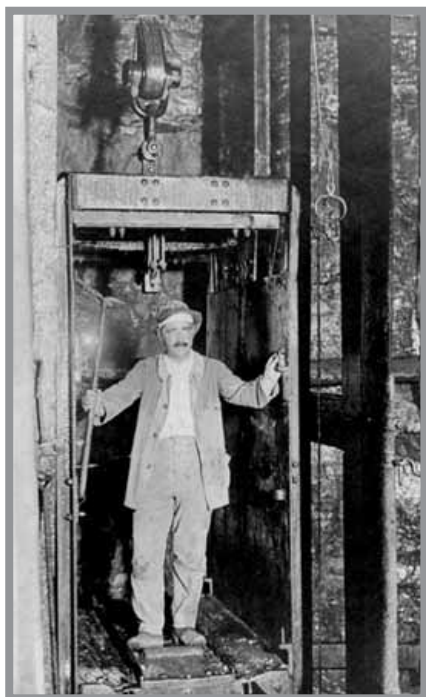
La conexión del Pozo con las labores en cada piso tiene lugar en el enganche o "cóncavo", un ensanche para traspase de personal, materiales y vagonetas. Foto: Colectivo Arrayanes.
