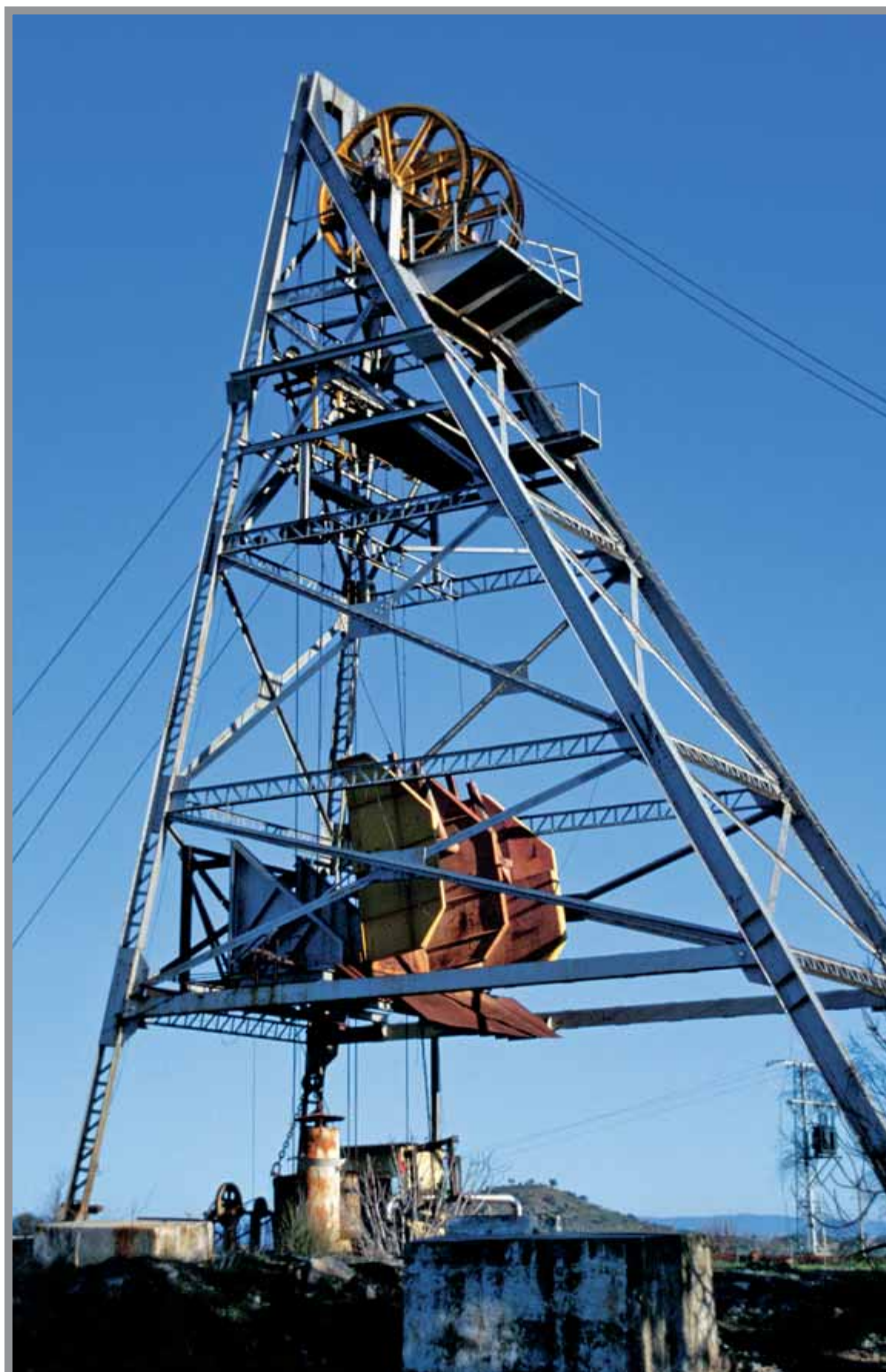
Moderno castillete metálico del Pozo "San Luis", en la concesión "Casualidad", más conocido como "Cerro Hueco" por el elevado número de geodas y sopladors que aparecen. El Pozo fue profundizado desde los 150 m hasta los 300 m para reconocer en profundidad el filón "Democracia", con resultado negativo. Foto: G. García, 12/1999.
