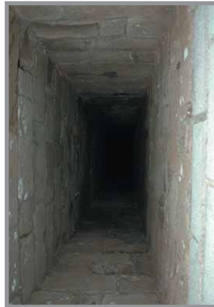
Pozo de mina con mampostería de arenisca del país. Estos accesos deben señalizarse y protegerse, pero no obturarlos ni precintarlos. Foto: G. García, 2008.
