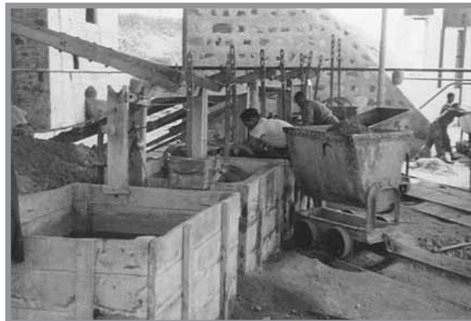
Cribas cartageneras, en el lavadero del Pozo “San Vicente”. El fundamento de la concentración es gravimétrico. Foto: J. Martín-Delgado Tamayo, 1955.
