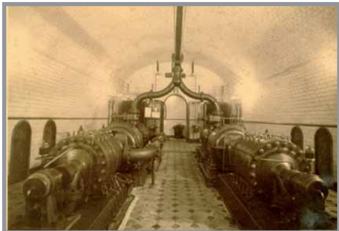
Sala de bombas en la 11ª Planta del Pozo "San José" de "Arrayanes", en 1931, instalada en un anchurón de 14 m de largo, "revestido todo él de azulejo blanco biselado", un despilfarro innecesario. Foto: Archivo de F. Gutiérrez Guzmán.
