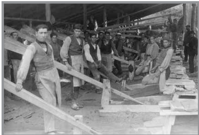
Los “Cajones del país” o cribas cartageneras, como el “rumbo”, eran rudimentarios métodos para el lavado de tierras. Su ineficiencia permitió el reciclado de escombreras a partir de 1958. Foto: Colectivo Arrayanes.
