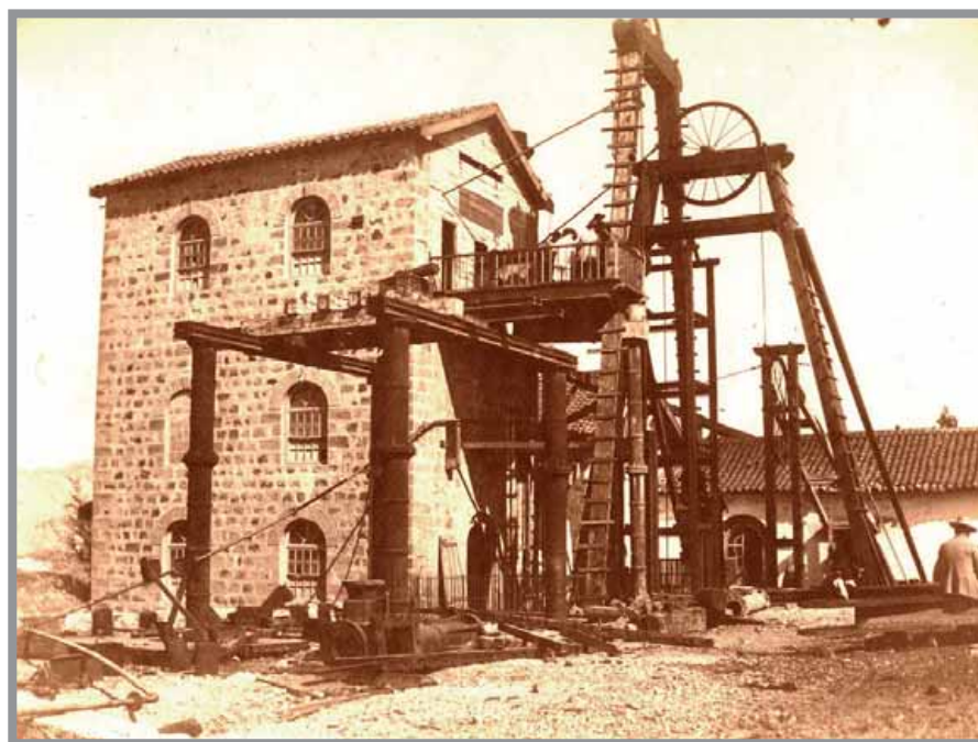
Panorama del Pozo "San Vicente" de la mina "San Miguel", en 1892. También conocido como "Pozo Máquina", alcanzaba ya en 1910 la profundidad de 600 metros en su 23ª Planta. Este pozo, tras su reprofundización en 1956, se convirtió, con sus 1.008 metros, en la mina más profunda de España. Foto: Archivo de F. Gutiérrez Guzmán.
