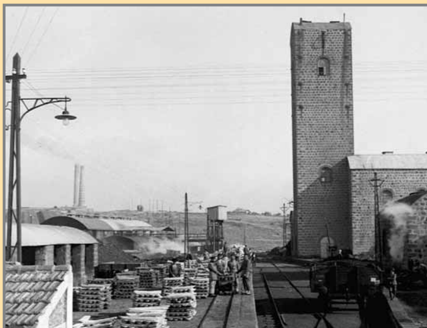
Muelle de embarque de lingotes en la Fundición. Al fondo, la torre de perdigones. En 1880 tenía 300 empleados y en 1885 es inaugurado tras la ampliación de instalaciones, convirtiéndose en la primera fundición linarense que transforma el plomo dulce y lo desplata, elaborando además planchas, tubería, balas y perdigones. Foto: Colectivo Arrayanes.
