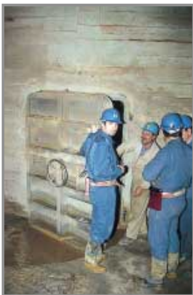
Puerta estanca de acero inoxidable que da acceso a la sala de bombas del 45 Piso de Alfredo. Esta sala se encuentra a una profundidad de 562 m y está aislada del resto de la mina por un muro de hormigón de 50 cm de espesor. Foto: Ángel Sanz.
