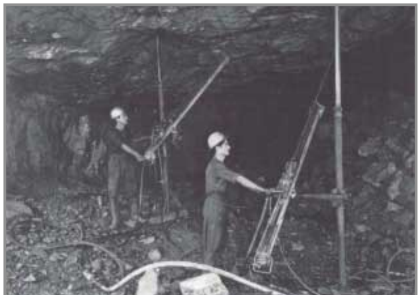
Perforación de barrenos de realce con máquinas de columna en Tharsis (ppios. de siglo XX). Foto cedida por Fundación Riotinto.
