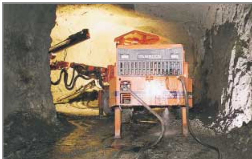
Jumbo perforando una pega de avance en el Nivel 675 de Sotiel Este . Foto cedida por Almagrera, S.A.
