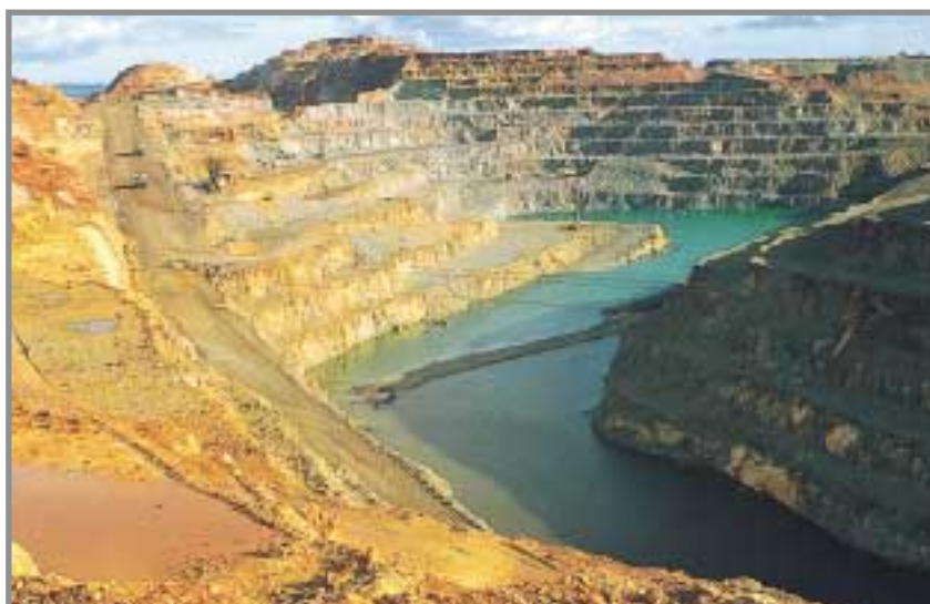
Inundación de Cerro Colorado en noviembre de 1997. El agua inundó el banco 304 (apertura) y el 316 (de 0,5m a 1m). Foto: Iván Carrasco.
