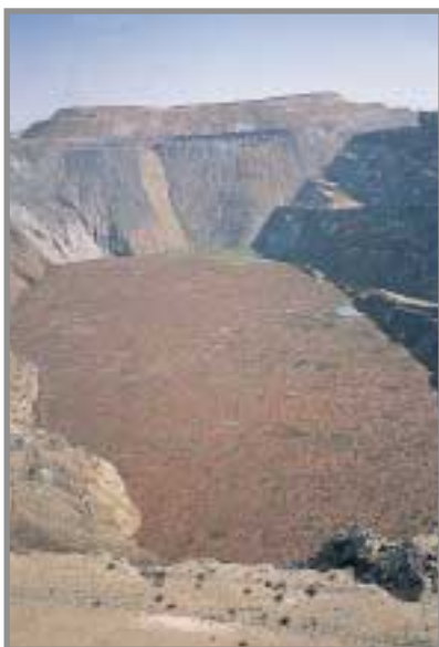
Estado de la corta de Aznalcóllar en febrero de 1999, con los lodos depositados en su interior. Al fondo se puede observar el vacio de esteriles de la corta de Los Frailes, aunque actualmente se está empleando como balsa de los esteriles de la planta de concentración. Foto: Miguel Checa.
