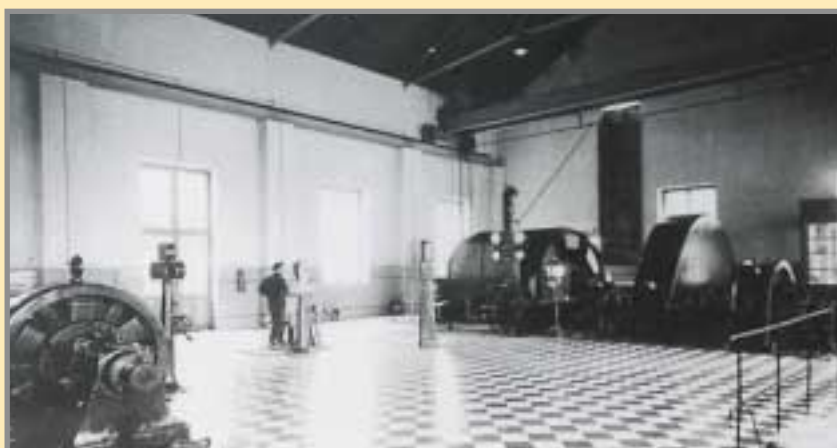
Máquina de extracción del Pozo Santa Amelia, hacia mediados del siglo XX. Foto: AZSA.
