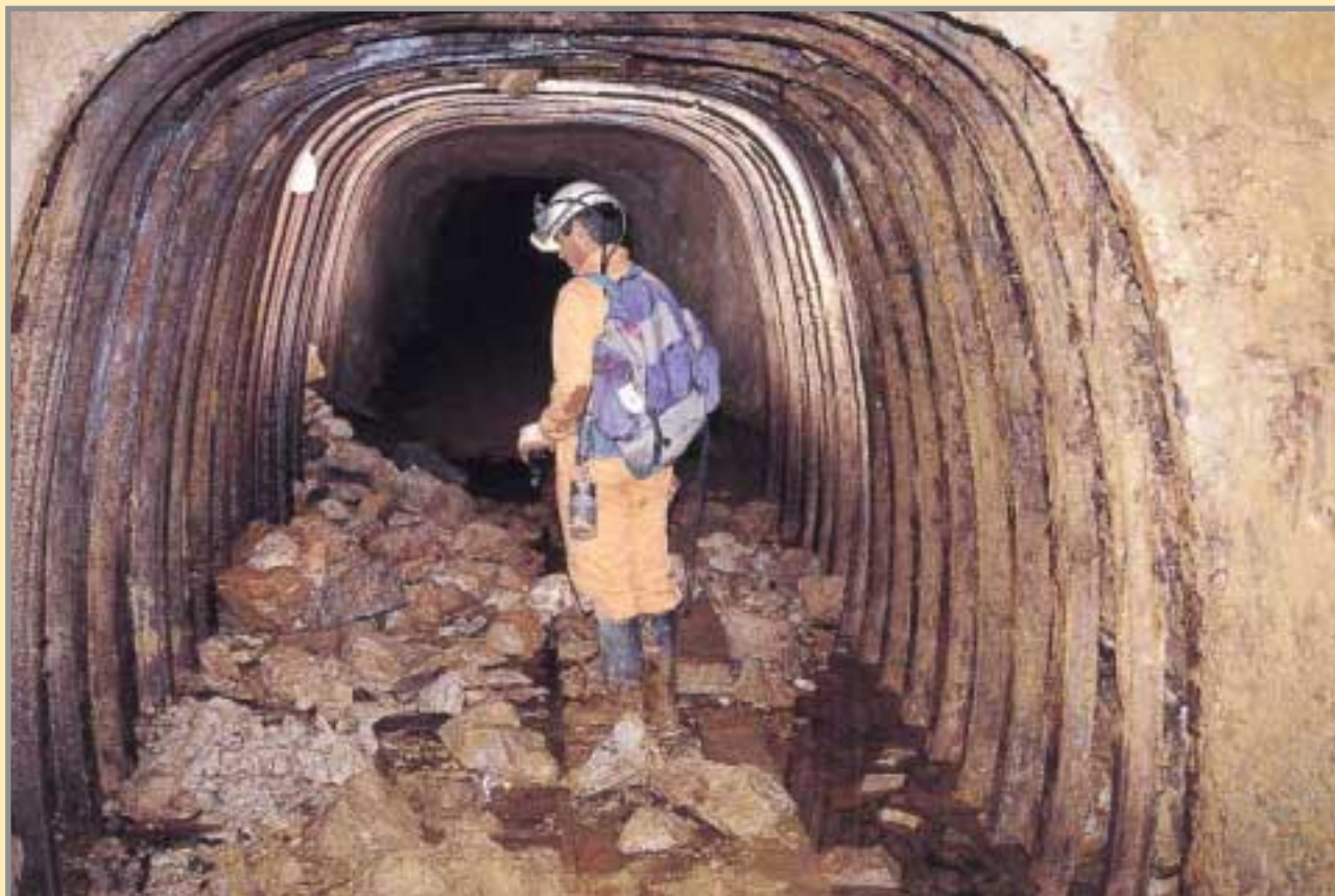
Tramo de galería posteoado con cerchas en "Las Ligorias", del Grupo La Florida. Para la gestión turística de las antiguas minas, deberían ser llamados a consulta los técnicos de minas y las asociaciones mineralógicas, quienes poseen la experiencia adecuada para el éxito de estas iniciativas. Foto: M. Hedrosa, 10/98.
