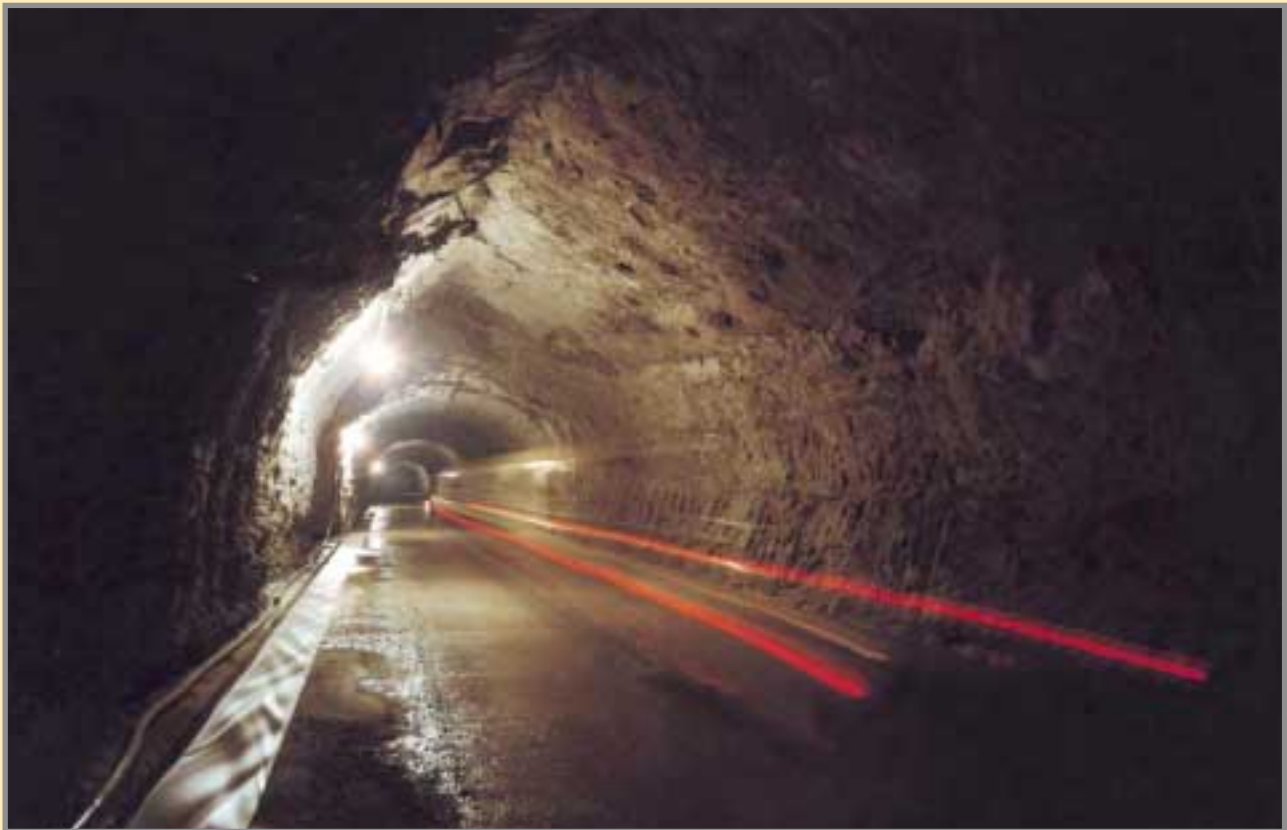
La rampa Jorge Valdés tiene el piso íntegramente hormigonado, mejorando su disponibilidad en servicio y reduciendo los tiempos de recorrido. Foto: AZSA.
