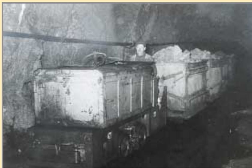
Locomotora de acumuladores alcalinos para arrastre de un tren de mineral en el Nivel 20. Foto: AZSA, mediados de s. XX.
