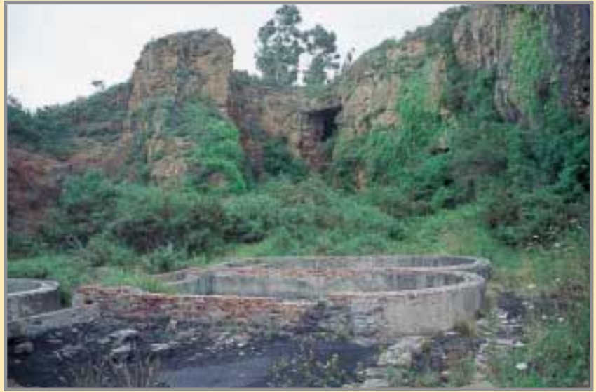
Restos de instalaciones de preparación mecánica del mineral, en la mina "Emilia". Al fondo, se observan los macizos de dolomía trabajados, con conexiones con labores subterráneas. Foto: G. García, 7/2001.
