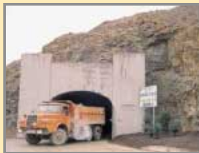
La rampa Jorge Valdés fue puesta en servicio en 1985. Tiene una longitud de 3.400 m con una pendiente del 12 %. Foto: AZSA.
