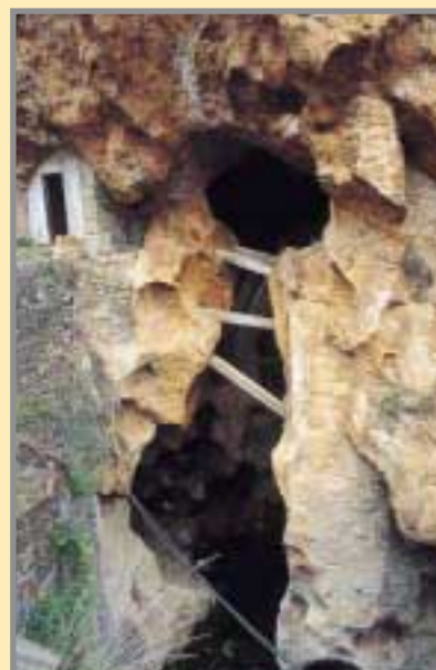
Mampostas soportan un morro de dolomía quebrado. Al fondo arranca un pozo actualmente inundado. Foto: G. García, 7/2001.
