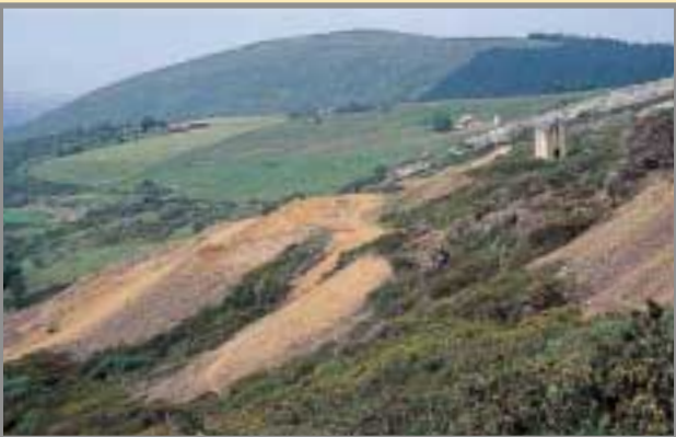
Labores en superficie, con escombreras de dolomía y restos de calaminas. Obsérvese el banco blanco de caliza (techo de la formación), detrás del transformador. Zona de la mina Isidra. Foto: G. García, 8/2000
