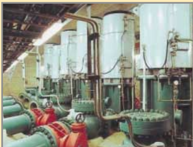
Sala de bombas del nivel -272, con una capacidad de desagüe de 9.000 m 3 /h. Reocín es la mina española con mayores dificultades en el achique de agua, con entradas constantes de 1,2 m 3 /h. Foto: AZSA.
