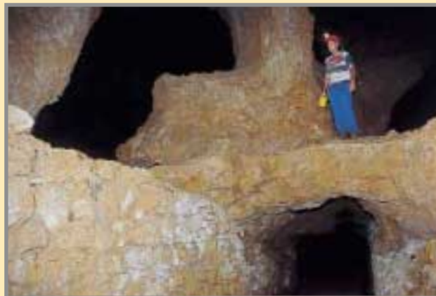
Columnas y pedrizas a lo largo del plano inclinado de la mina de Udías, entre los niveles 1 y 2. Foto: G. García, 8/2001.
