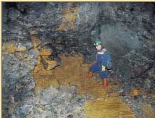
Descalce de un pilar sobre masa arcillosa que fluye hacia el piso, en Punta de Lanza, nivel -245, cámara 2. 6/01. Foto: G. García.
