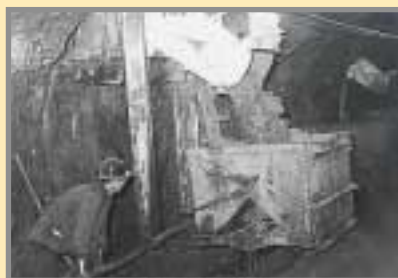
Piguera abierta de la tolva en galería de muro para carga de mineral en el Nivel 14. Foto: AZSA, mediados de s. XX.
