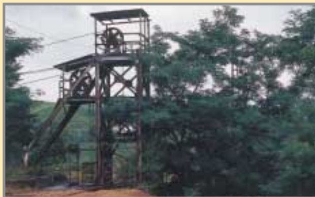
El pequeño castillete de la mina "San José" (Novales) elevaba las vagonetas desde el nivel de calle hasta la plataforma de ferrocarril. 8/96. Foto: G. García.
