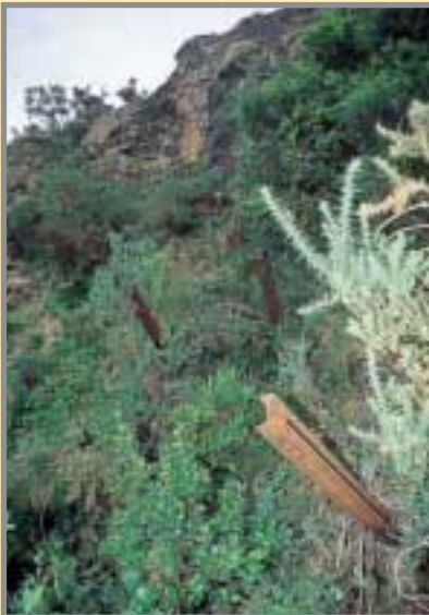
Evidencia del descenso progresivo del fondo de la corta. Raíles empotrados en las paredes. Foto: G. García, 7/2001.
