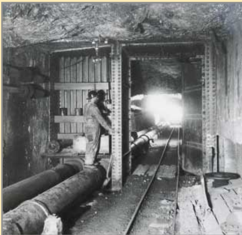
Cerramiento metálico subterráneo en el nivel 20, con vía para circulación de mineral y tuberías de desagüe. Foto: AZSA, mediados s. XX.
