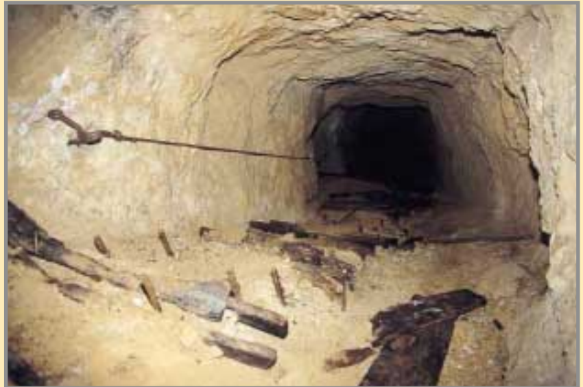
Escalera de comunicación con un piso inferior, con peldaños de madera y cable-pasamanos. Los niveles más bajos se encuentran actualmente invadidos por el agua. Foto: G. García, 7/2001.
