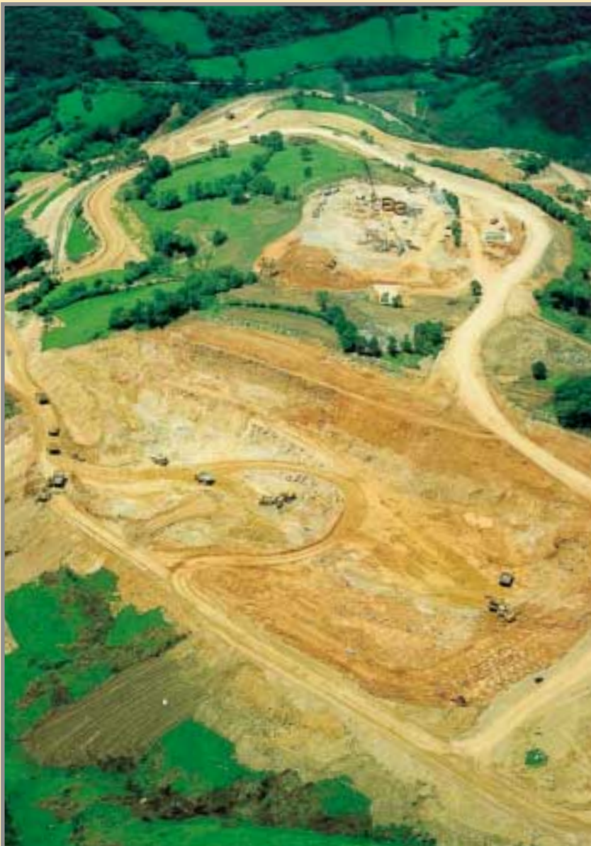
Fase de construcción de la planta de tratamiento, en 1997. Como paso previo a la elección del emplazamiento se realizaron sondeos de esterilización para confirmar la inexistencia de mineral bajo las instalaciones. Foto: Cortesía de RNGM, S.A.
