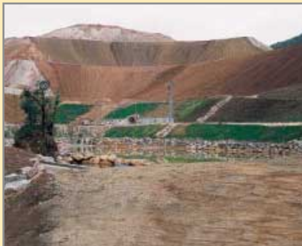
Imagen intermedia de la restauración de la Escombrera Sur en la zona de la galería de exploración que actualmente drena el acuífero de El Valle, y que en un futuro pasará a fase de producción. Foto: Cortesía de RNGM, S.A.
