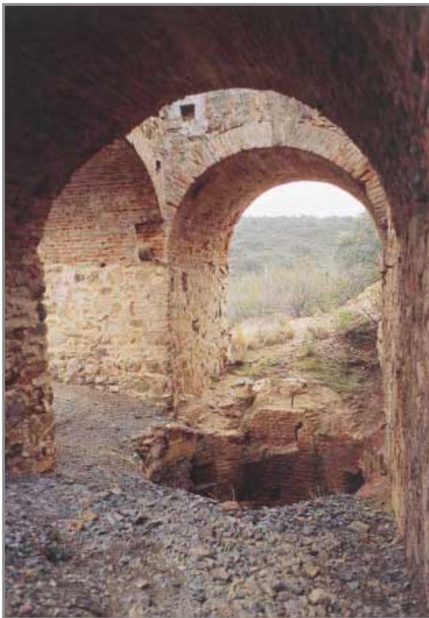
El Pozo Central, de sección circular y 143 m de profundidad, discurre en estéril. Fue construido en 1908 por la Compañía Peñarroya, al Norte del filón. En el nivel -133 tiene un recorte o travesía de 155 metros en dirección Sur, que toca al filón, con una metalización pobre. Foto: G. García, 11/95.
