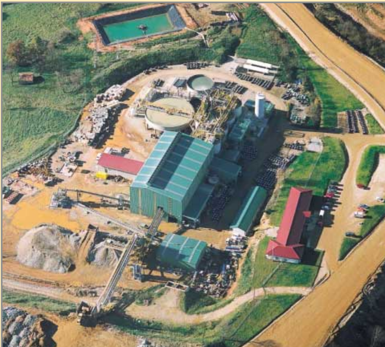
En la planta de tratamiento se obtienen tres tipos de productos: un concentrado gravimétrico de alta ley, otro concentrado de baja ley procedente del circuito de flotación y el bullion de oro. La zona de acopio o stock de abastecimiento de la planta (esquina inferior izquierda de la foto) es el lugar donde han podido salvarse de la machacadora algunas de las diversas muestras de especies minerales que aparecen ilustrando este trabajo. Foto: Cortesía de RNGM, S.A.
