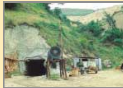
Imagen del portal de la galería de drenaje en 1999. Posteriormente, este valle se utilizó como escombrera, siendo necesario prolongar artificialmente la galería. Foto: G. García.
