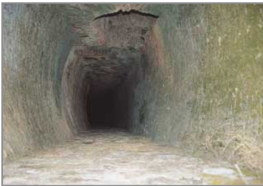
Perspectiva de la caña del Pozo del Arco, completamente revestida en su primer tramo. Por este pozo son accesibles algunos paneles de explotación, y se ha confirmado la presencia de pironomita en otros puntos del filón. Foto: G. García, 7/2001.
