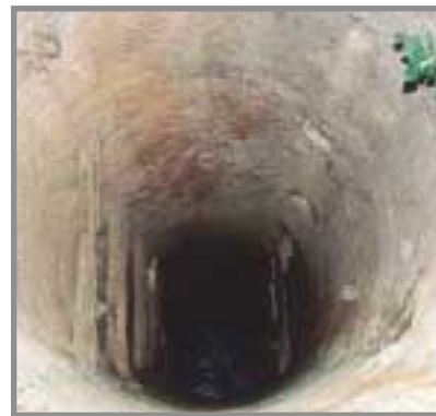
Caña del Pozo Central, con el fondo inundado. Tiene un diámetro revestido de 3,5 m, cortando pizarras hasta los 90 m y cuarcitas después. En el nivel -93 se practicó un anchurón para la colocación de una bomba y un foso de 100 m². Foto: G. García, 7/2001.
