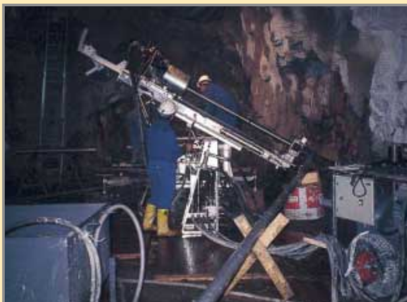
Perforación con jumbo Tamrock en las labores de ampliación de la infraestructura de interior. Diciembre de 2001. Foto: Cortesía de RNGM, S.A.
