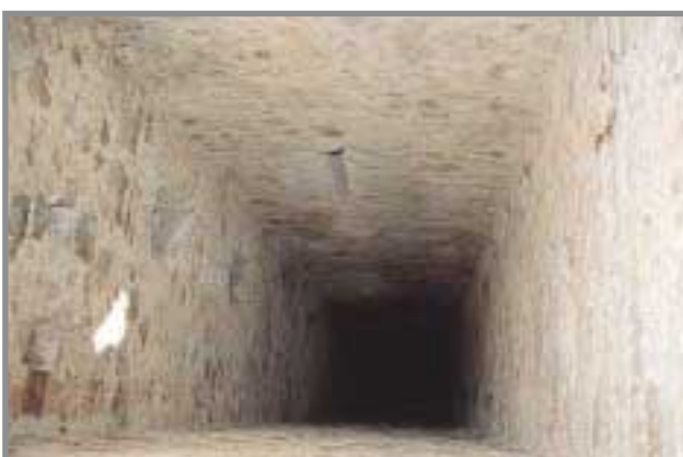
Caña del Pozo "Oriente", con los huecos de los antiguos estamples en su mampostería. Los materiales de su escombrera son diferentes al escombro de las minas del lado Oeste, con abundante siderita. Foto: G. García, 7/2001.
