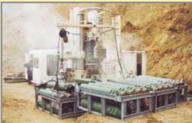
Construcción de una chimenea de ventilación con raise-boring para la mina subterránea. Foto: Cortesía de RNGM, S.A.
