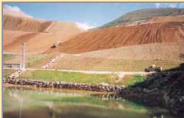
Acondicionamiento de escombreras restauradas, previo a la hidrosiembra. Zona de la galería de drenaje. Foto: Cortesía de RNGM, S.A.
