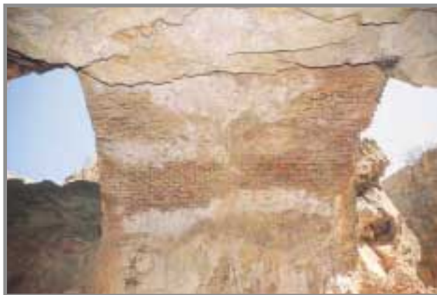
Macizo de sujeción de hastiales, construido en la zona baja de la trinchera, en pleno eje antidual de la Cuarcita de Cantera (Caradociense). Perspectiva desde el fondo de la trinchera en la zona de aparición de piromorfita. Foto: G. García, 7/2001.
