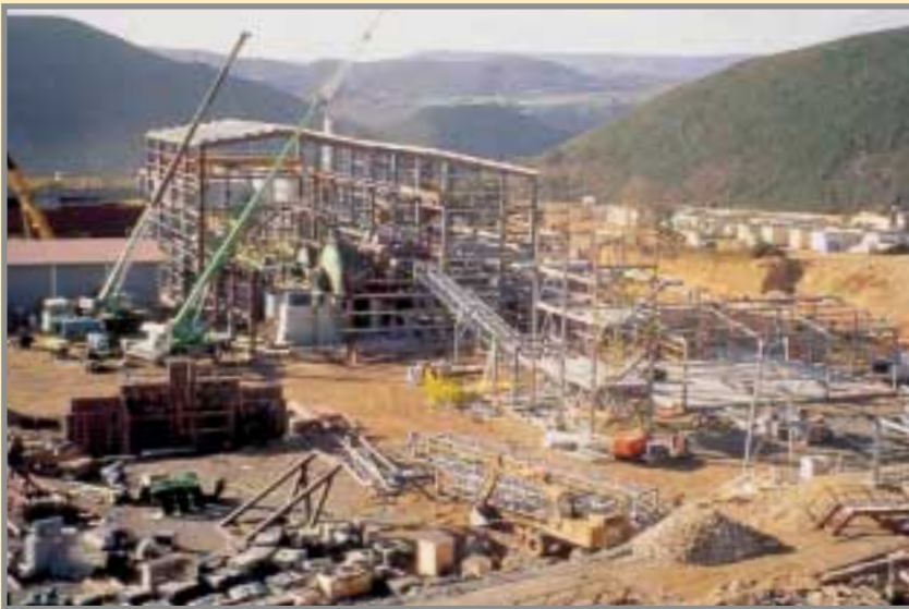
Fase de construcción de la planta de tratamiento, en 1997. Como paso previo a la elección del emplazamiento se realizaron sondeos de esterilización para confirmar la inexistencia de mineral bajo las instalaciones. Foto: Cortesía de RNGM, S.A.
