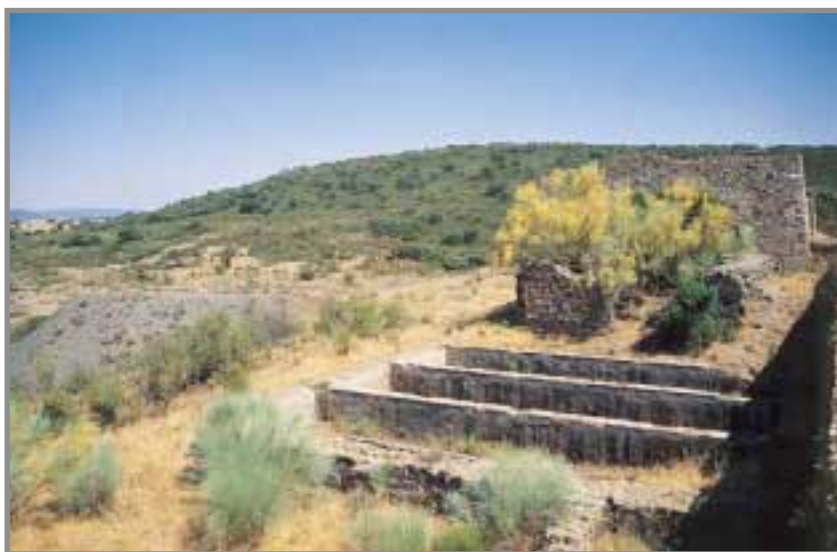
En el Pozo Central Peñarroya instaló una bomba centrífuga y un compresor de 100 HP, así como una máquina de extracción de 150 HP, todo ello a vapor. En la foto se observan los fosos de las antiguas calderas, cada una de las cuales tenía su propia chimenea. Foto: G. García, 7/2001.
