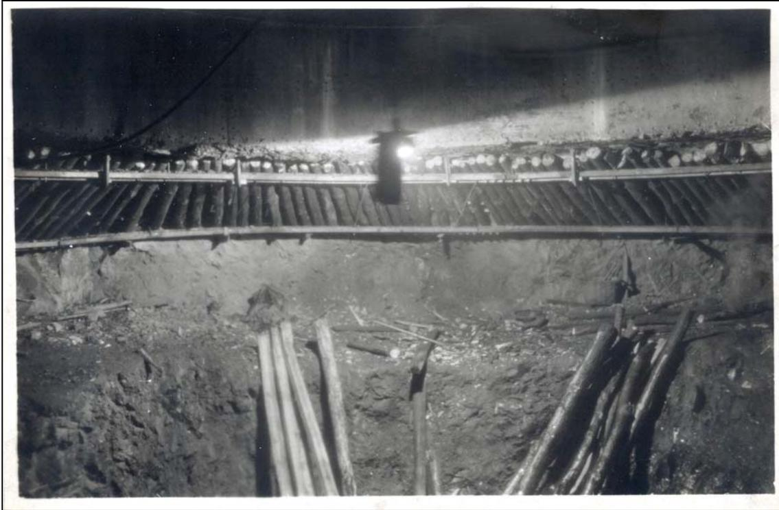
Figura 7: *Detalle del encofrado. 4-12-1941.*
