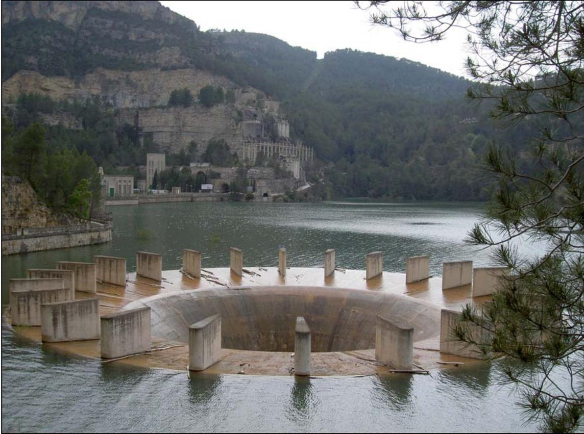
Figura 51: Aliviadero del pantano y planta cementera (Fot. J.M. Sanchis, 2010)
