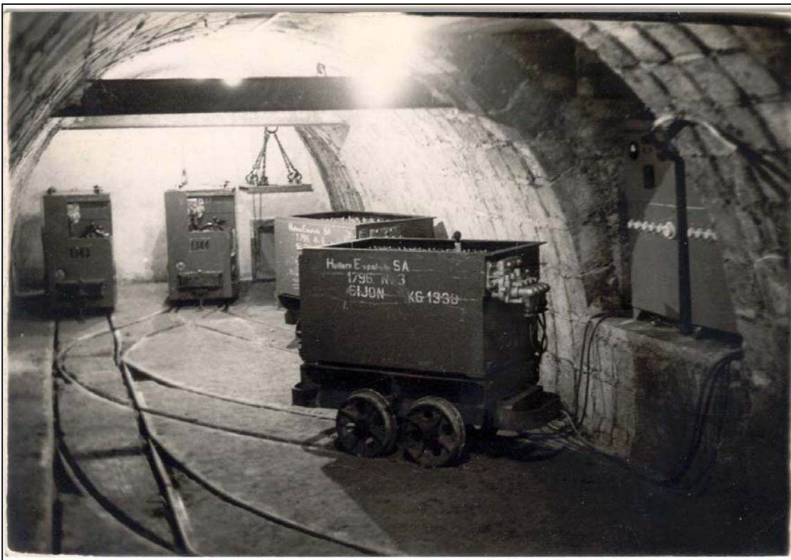
Figura 42: *Sala de carga de baterías de tractores eléctricos, 1958.*
