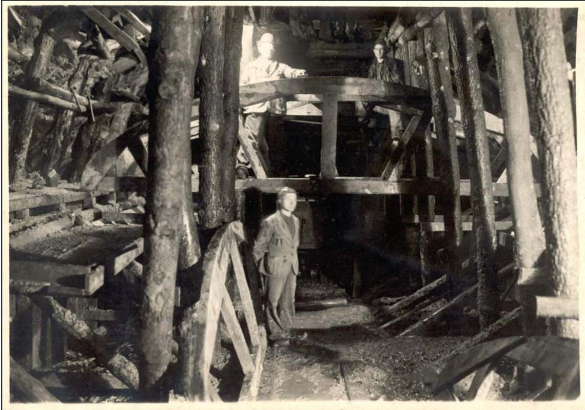
Figura 8: *Encofrados de madera, 4-12-1941.*
