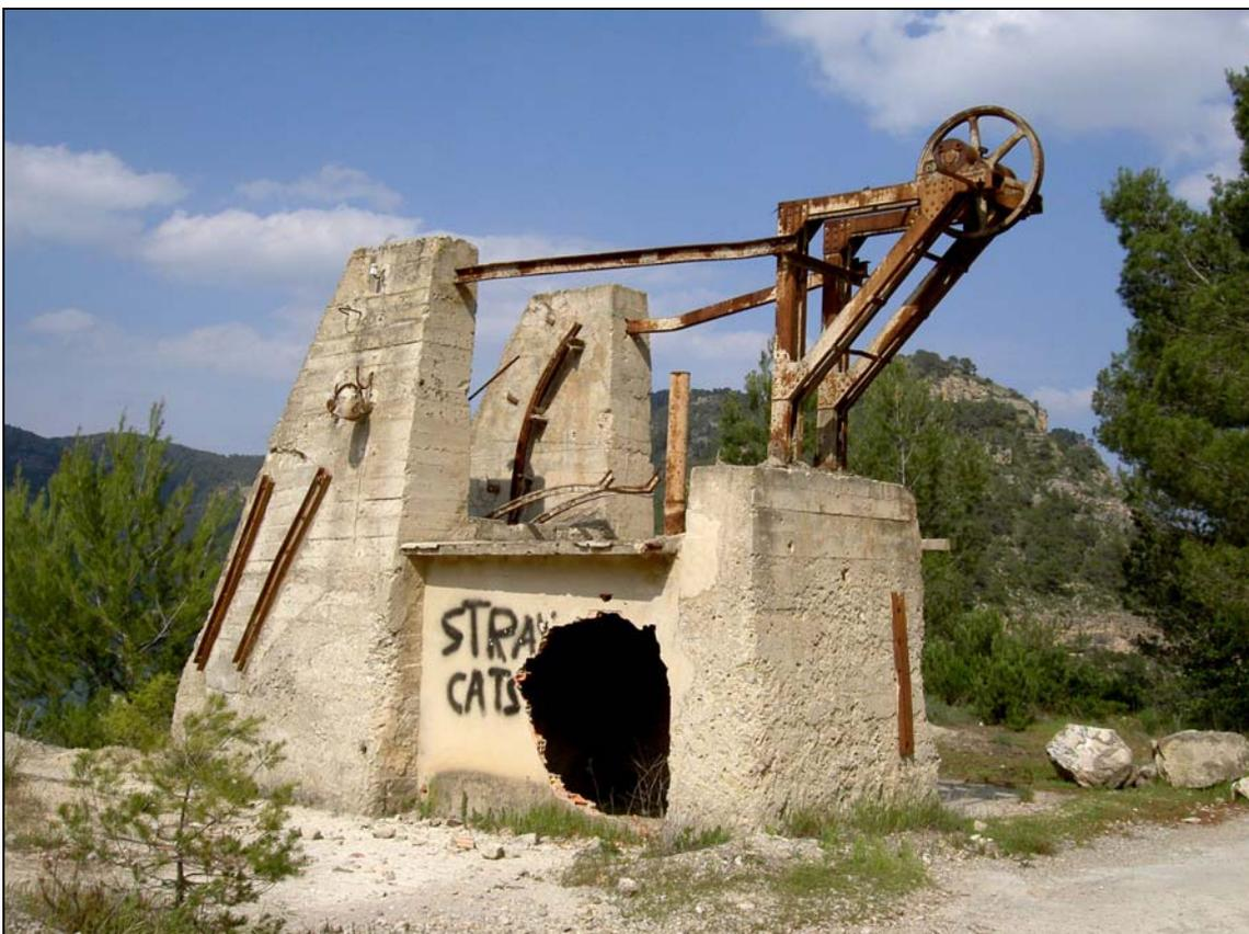
Figura 54: Sistema para la elevación del cemento (Fot. J.M. Sanchis, 2010)
