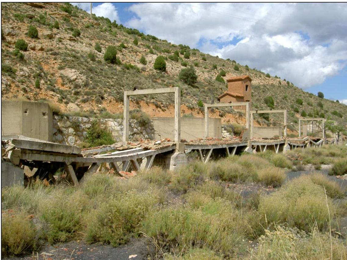
Figura 83: Restos de la estructura de hormigón de la cinta transportadora (Fot. J.M. Sanchis, 2010)
