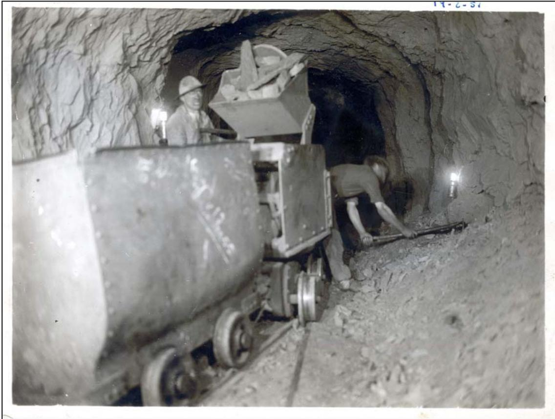
Figura 32: Pala autocargante en un avance, 1951.
