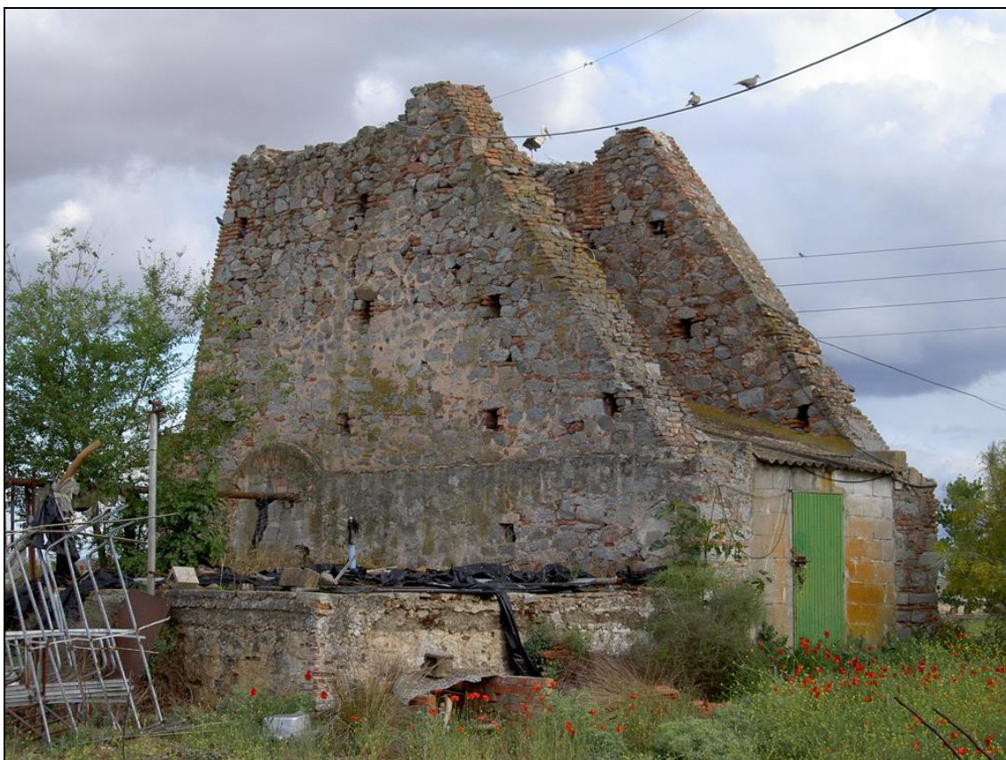
Figura 7: Muros de mampostería de El Convenio (Fot. J.M. Sanchis, 2008)
