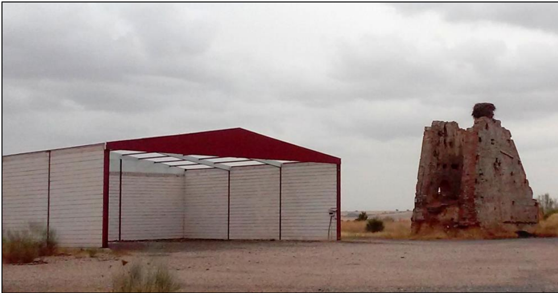
Figura 25: Pozo Potosí, en la actualidad (Arch. S. Muriel)
