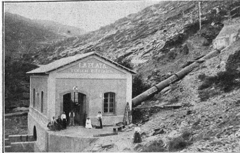
Central eléctrica de las minas
