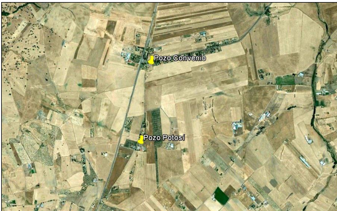
Figura 2: Vista aérea de los pozos (Google Earth)
