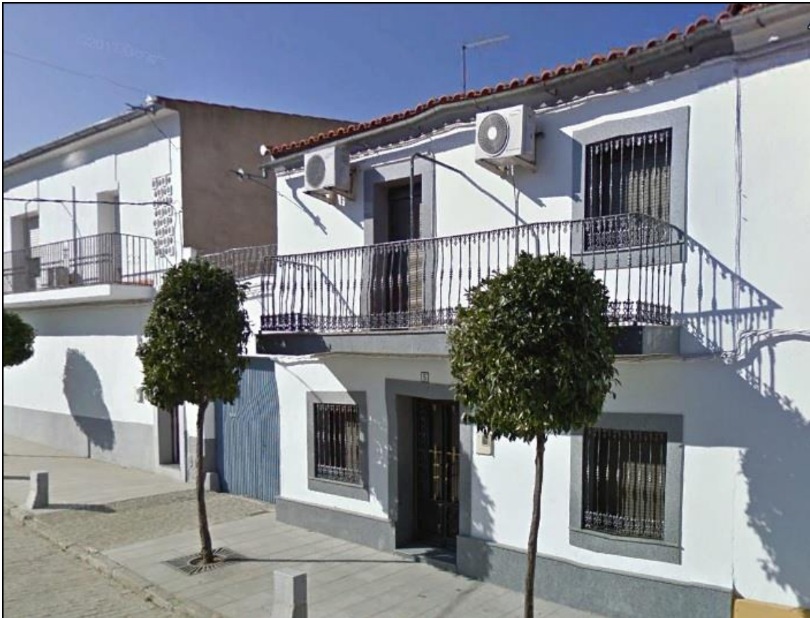
Figura 27: Calle San Isidro, 5 (antes nº 1), sede de las oficinas de la mina.
