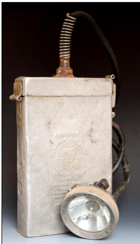
Fig. 28 (Izquierda): Lámpara Edison de casco (Col. J.M. Sanchis)
