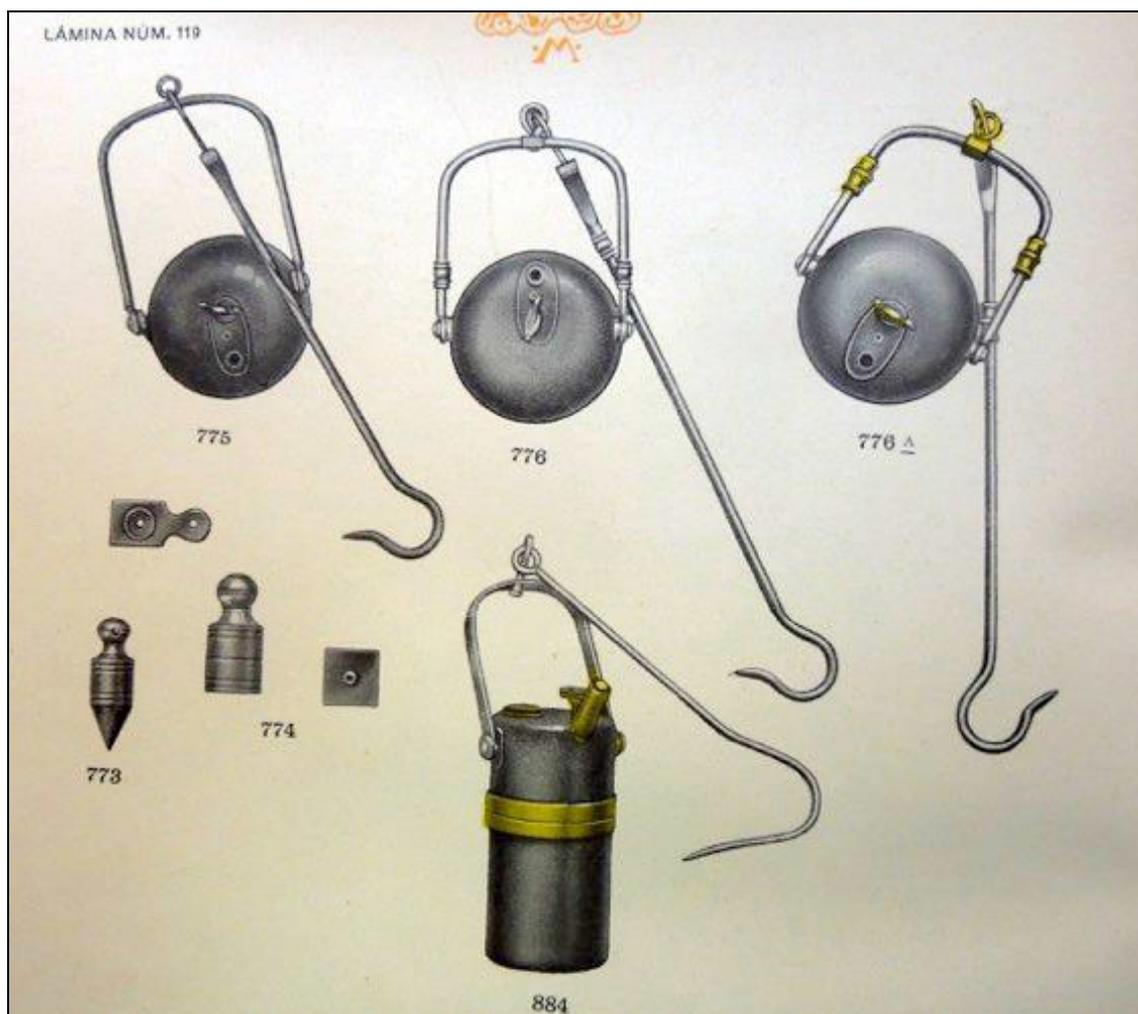
Fig. 44: Lámparas de mina en el catálogo de 1921 (Arch. J.M. Sanchis)
